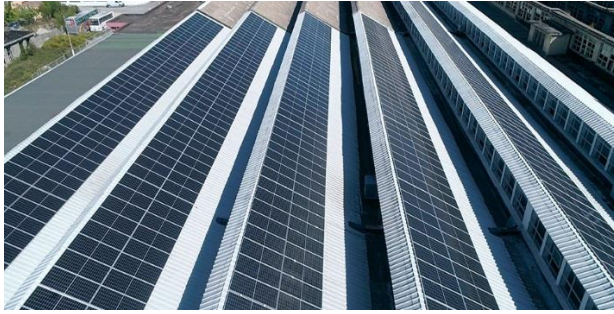
Resim 2.10. PV panellerin şet çatı üzerine uygulanması (Altenergy, 2022)
