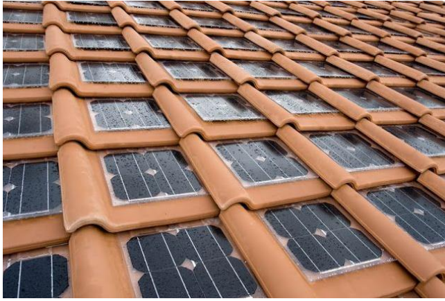
Resim 2.13. Solar kiremitlerin çatı üzerine uygulanması (Power enerji, 2022)
