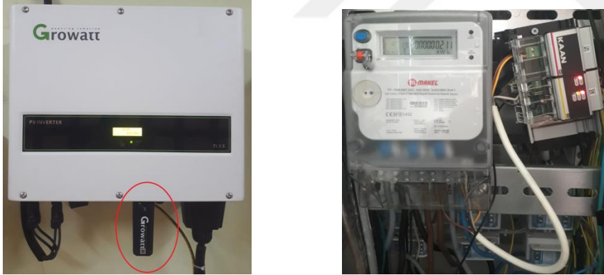
Resim 2.3. İnvertere bağlı modem ve sayaca bağlı uzaktan izleme cihazı
