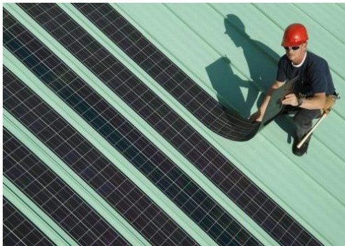
Resim 2.16. Çatılarda solar halı kullanımı (Uyar, 2016)
