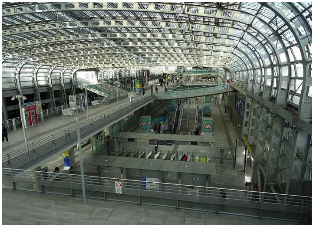
Resim 2.12. PV panellerin atrium çatı üzerine uygulanması, Porta Susa istasyonu, Torino, İtalya (Wikimedia, 2022)
