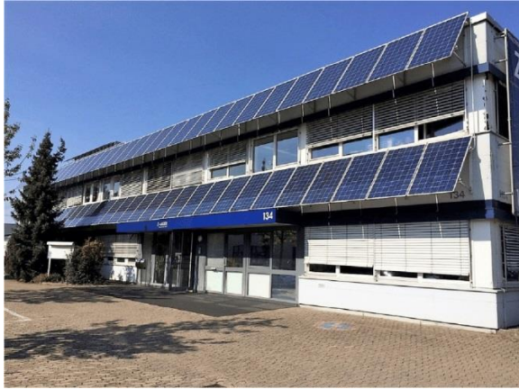
Resim 2.5. PV panellerin sabit gölgeleme elemanı olarak kullanımı Almanya,Vauban (Researchgate, 2022)
