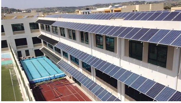
Resim 2.6. PV panellerin hareketli gölgeleme elemanı olarak kullanımı, St Nicholas College, Malta (Zammit, 2018).
