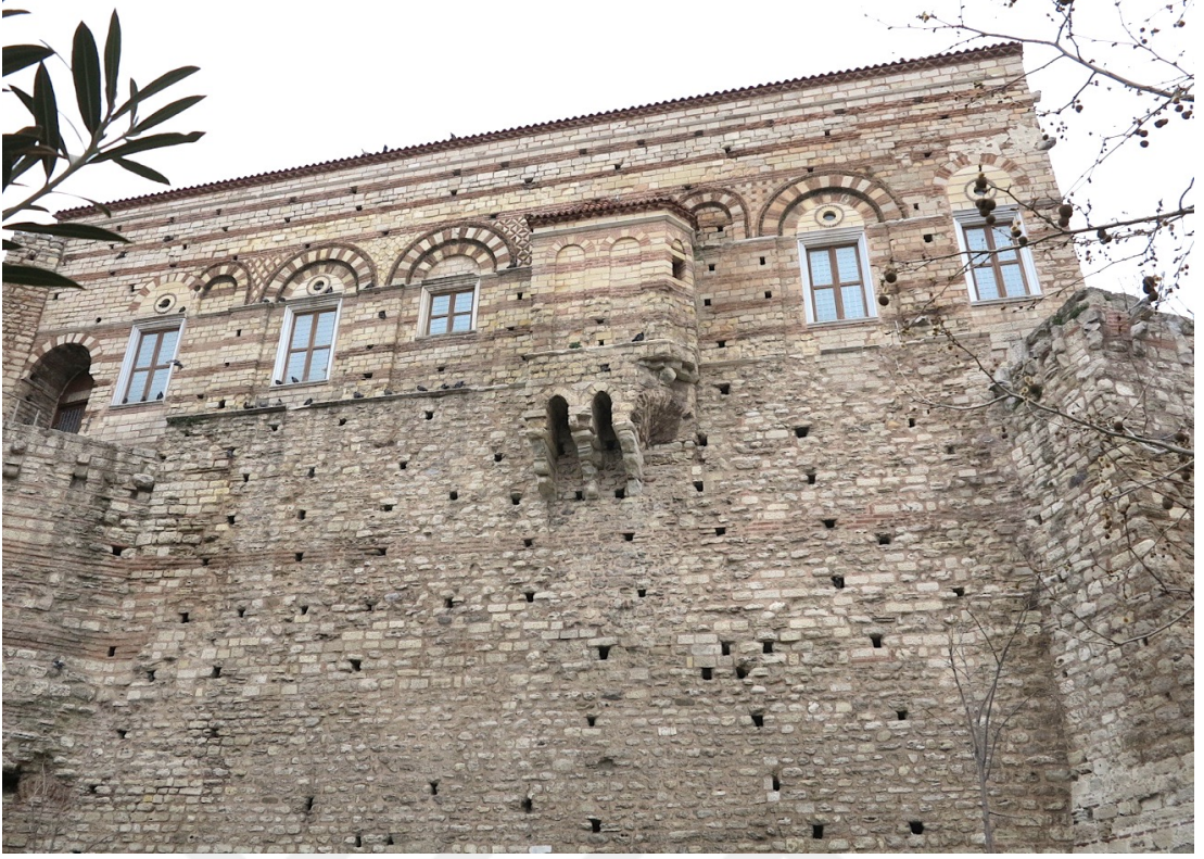
Res. 47: Tekfur Sarayı, güney cephesi (Ramírez, 2017)
