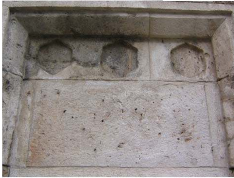
Fotoğraf 61: Sümbül Baba Zaviyesi'nin Kuzey-Doğu Cephesinde Yer Alan Türbenin Pencere Alınlığı
