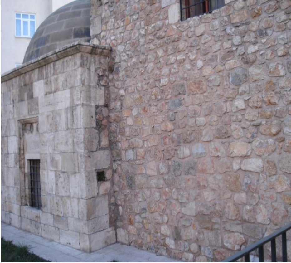
Fotoğraf 44: Sümbül Baba Zaviyesi Kuzey-Doğu Cephesi
