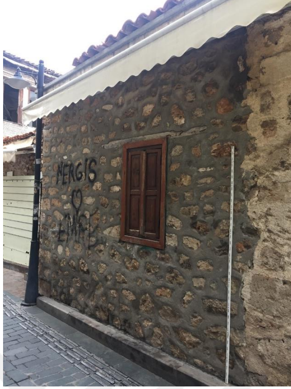
Fotoğraf 3. 97 Ahi Kızı Türbesi, Güney Cephe
