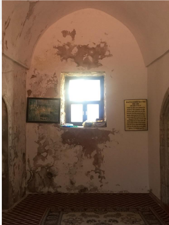
Fotoğraf 3. 182 Ahi Muhittin Zaviyesi Batı Odası Güney Cephe
