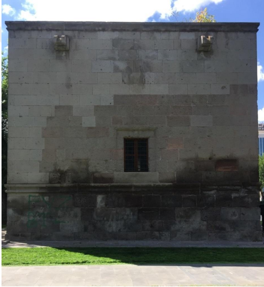
Fotoğraf 3. 112 Ahi Emir Ali Türbesi, Doğu Cephe
