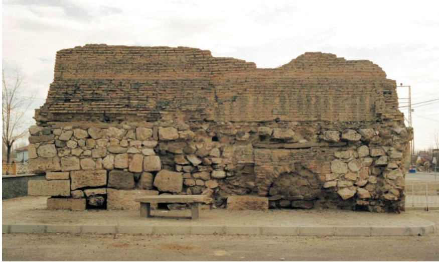
Fotoğraf 3. 116 Bedrettin Gevhertaş Türbesi, Onarım Öncesi
