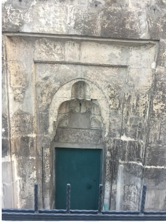
Fotoğraf 3. 136 Ahi Emir Ahmed Türbesi, Giriş Kapısı
