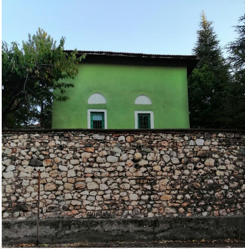
Fotoğraf 3. 142 Ahi Yusuf Türbesi, Kuzey Cephe
