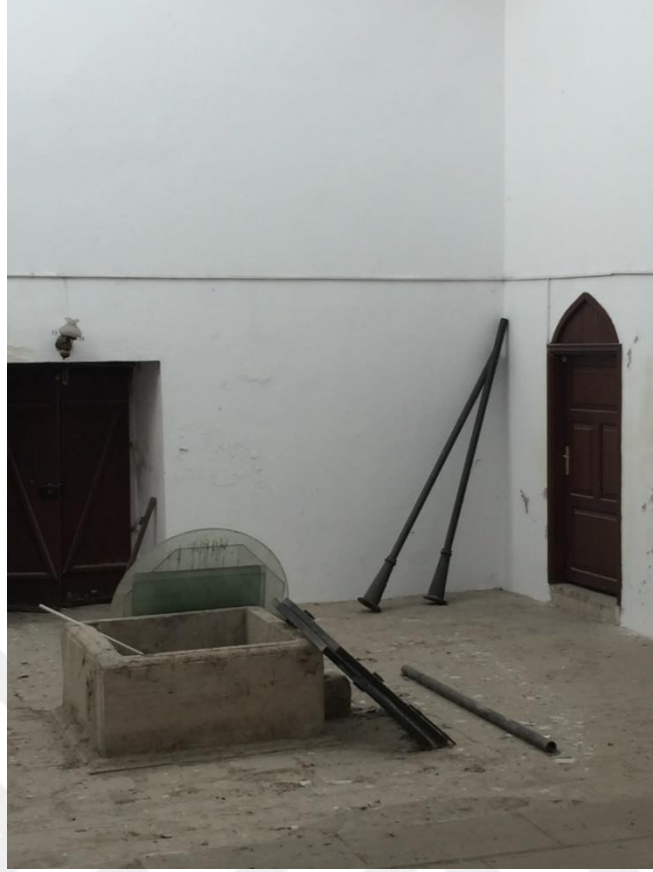
Fotoğraf 3. 178 Ahi Muhittin Zaviyesi Aydınlık Feneri Altındaki Havuz
