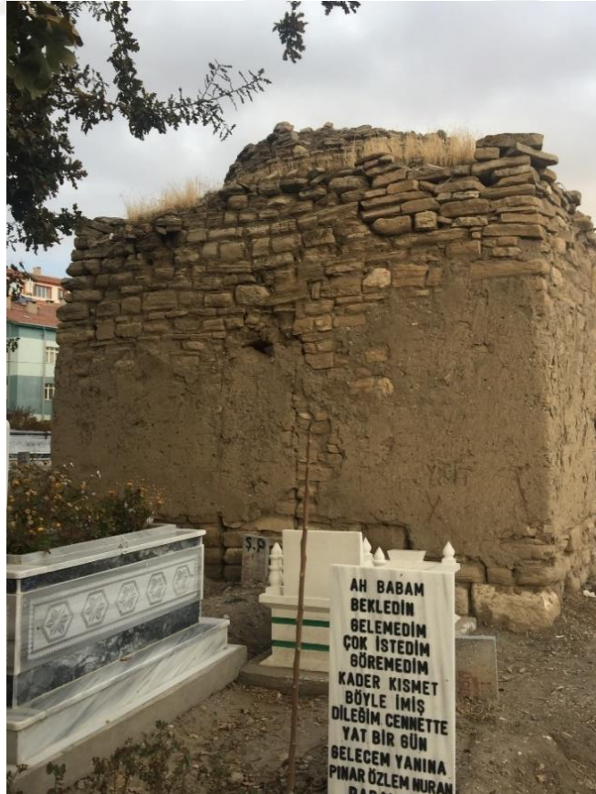
Fotoğraf 3. 127 Helvacı Dede Türbesi, Kuzey Cephe
