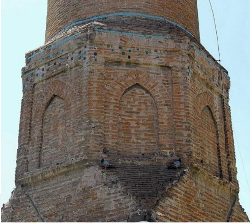
Fotoğraf 3. 28 Ahi Şerafeddin Camii, Minare Kaide ve Pabuçluk Kısımındaki Tuğla Süslemeler
