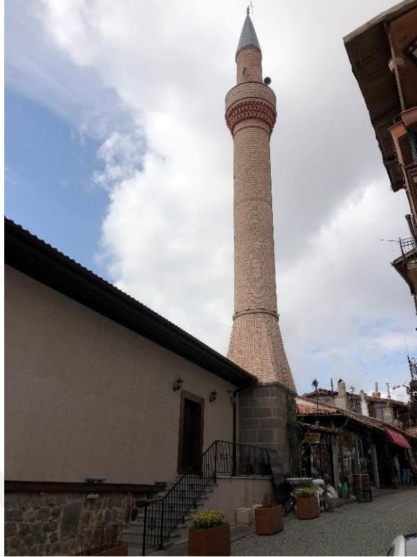
Fotoğraf 3. 6 Ahi Elvan Camii, Minare
