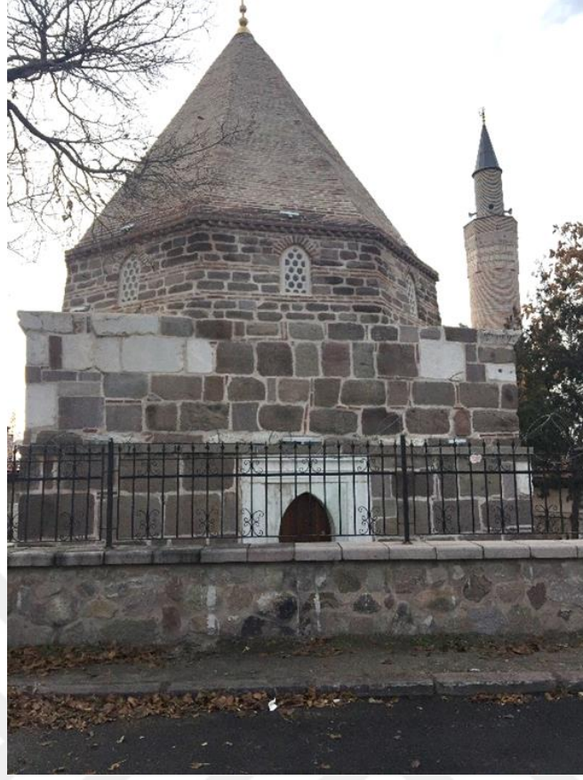
Fotoğraf 3. 88 Ahi Şerafeddin Türbesi, Kuzey Cephe
