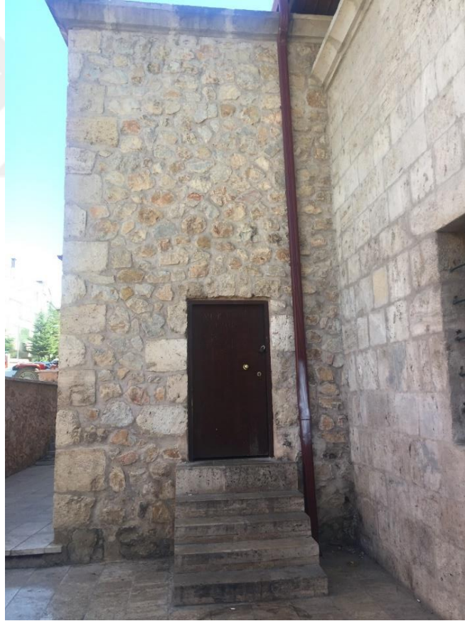
Fotoğraf 3. 172 Ahi Muhittin Zaviyesi, Kuzeydoğu Cephe'deki Batı Giriş Odası Kapısı
