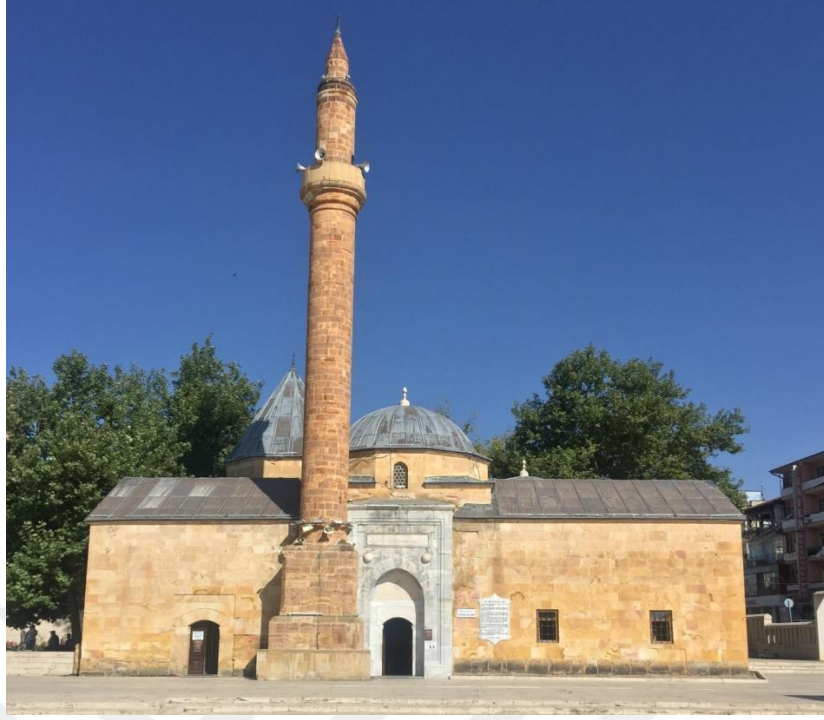
Fotoğraf 3. 157 Kırşehir Ahi Evren Zaviyesi, Genel Görünüş
