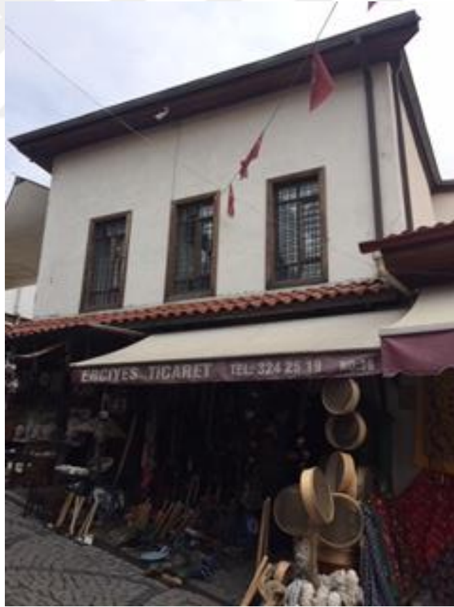
Fotoğraf 3. 58 Hacı Arap Camii, Batı Cephe
