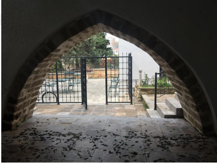
Fotoğraf 3. 108 Ahi Yusuf Türbesi, Yazlık Mescit Bölümü Kuzey Cephe
