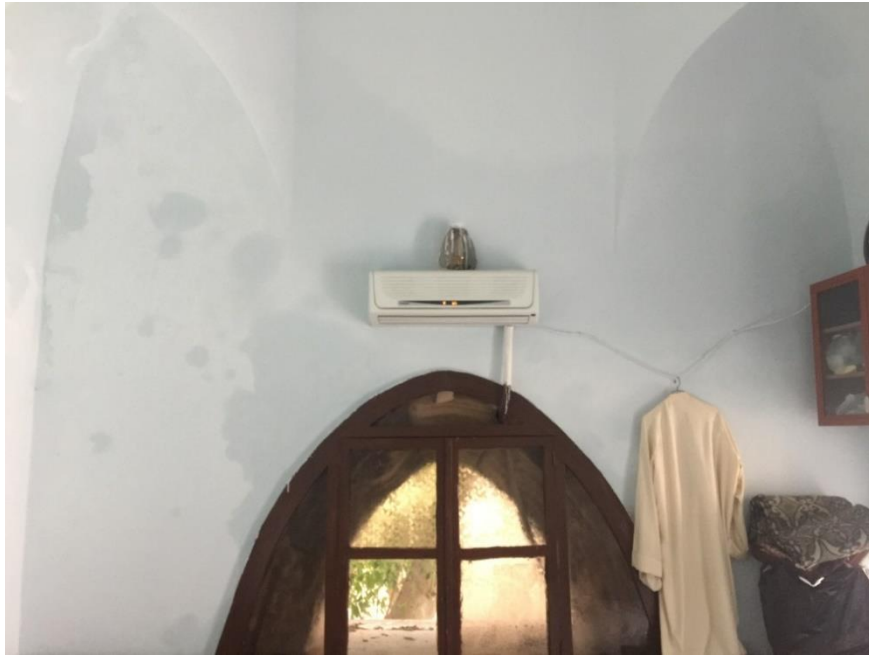
Fotoğraf 3. 104 Ahi Yusuf Türbesi, Batı Cephedeki Sivri Kemerli Pencere
