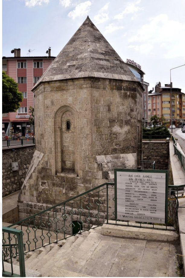
Fotoğraf 3. 132 Ahî Ahmed Türbesi, Doğu Cephe
