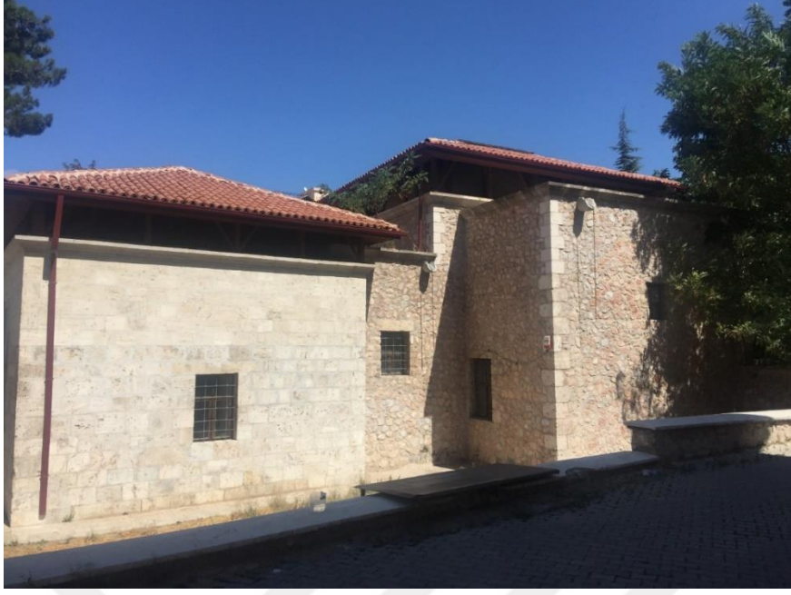
Fotoğraf 3. 171 Ahi Muhittin Zaviyesi Güney Cephesi
