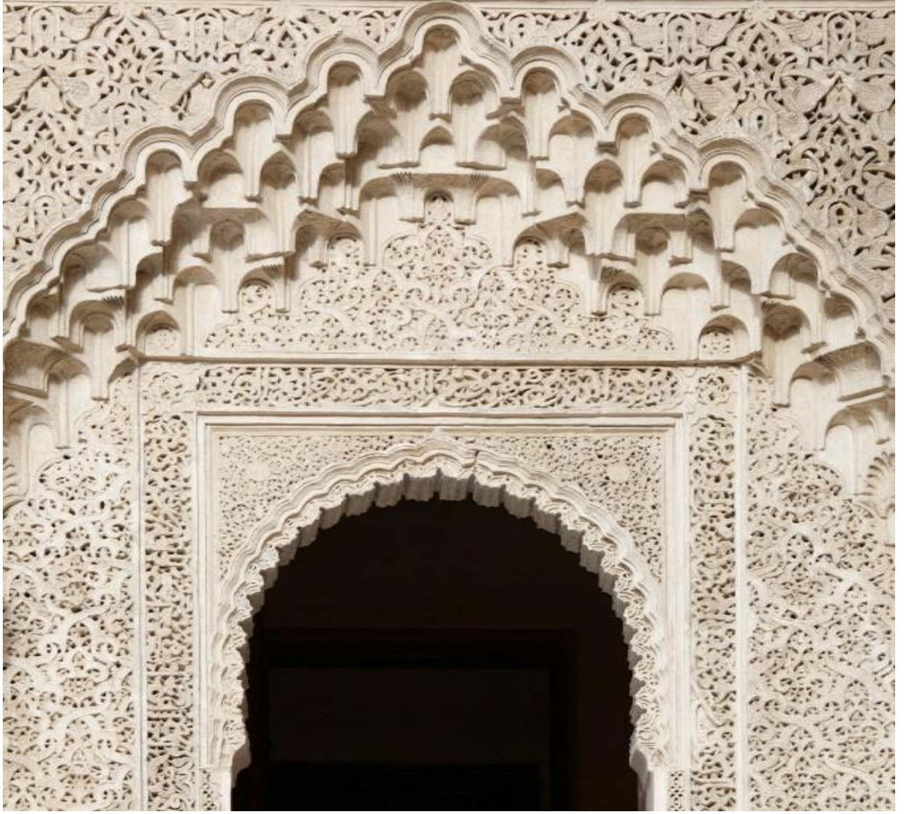
Görsel.15-Avlu Cephe Alçı Detayları (Latif,2011:254)
