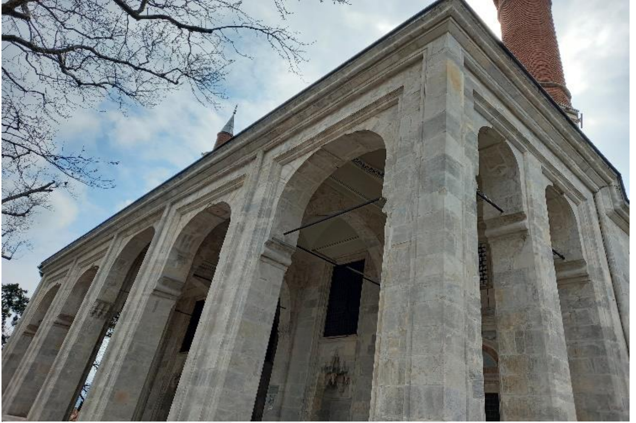
Görsel.70- Yıldırım Külliyesi Cami Giriş Cephesi Revak (Türker 2020)
