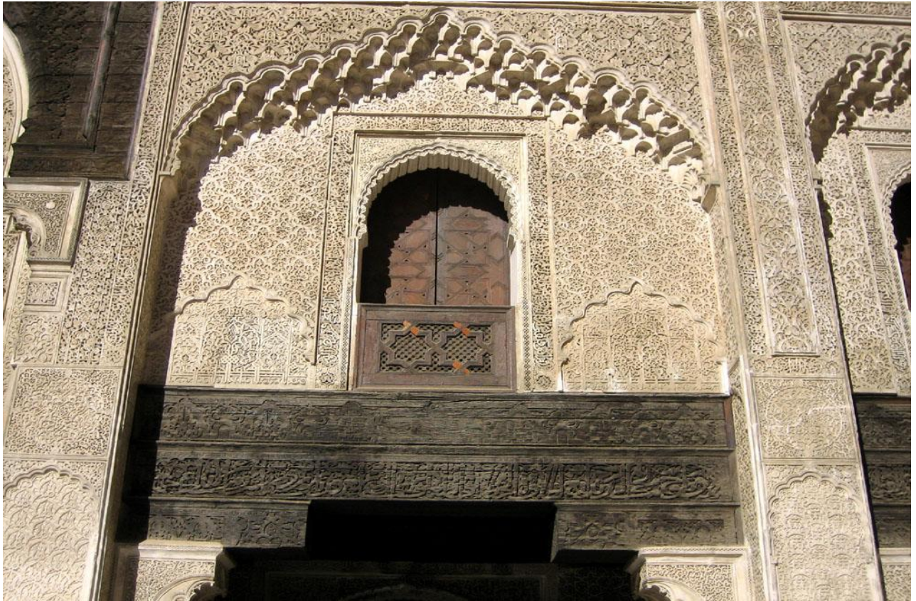
Görsel.14-Avlu Cephe Alçı ve Ahşap Detayları (Latif,2011:254)
