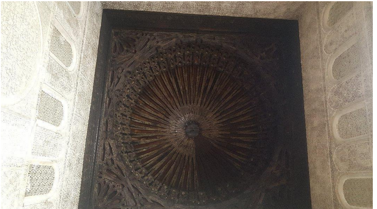
Görsel.24-Derslik Eyvani Ahşap Kubbe
