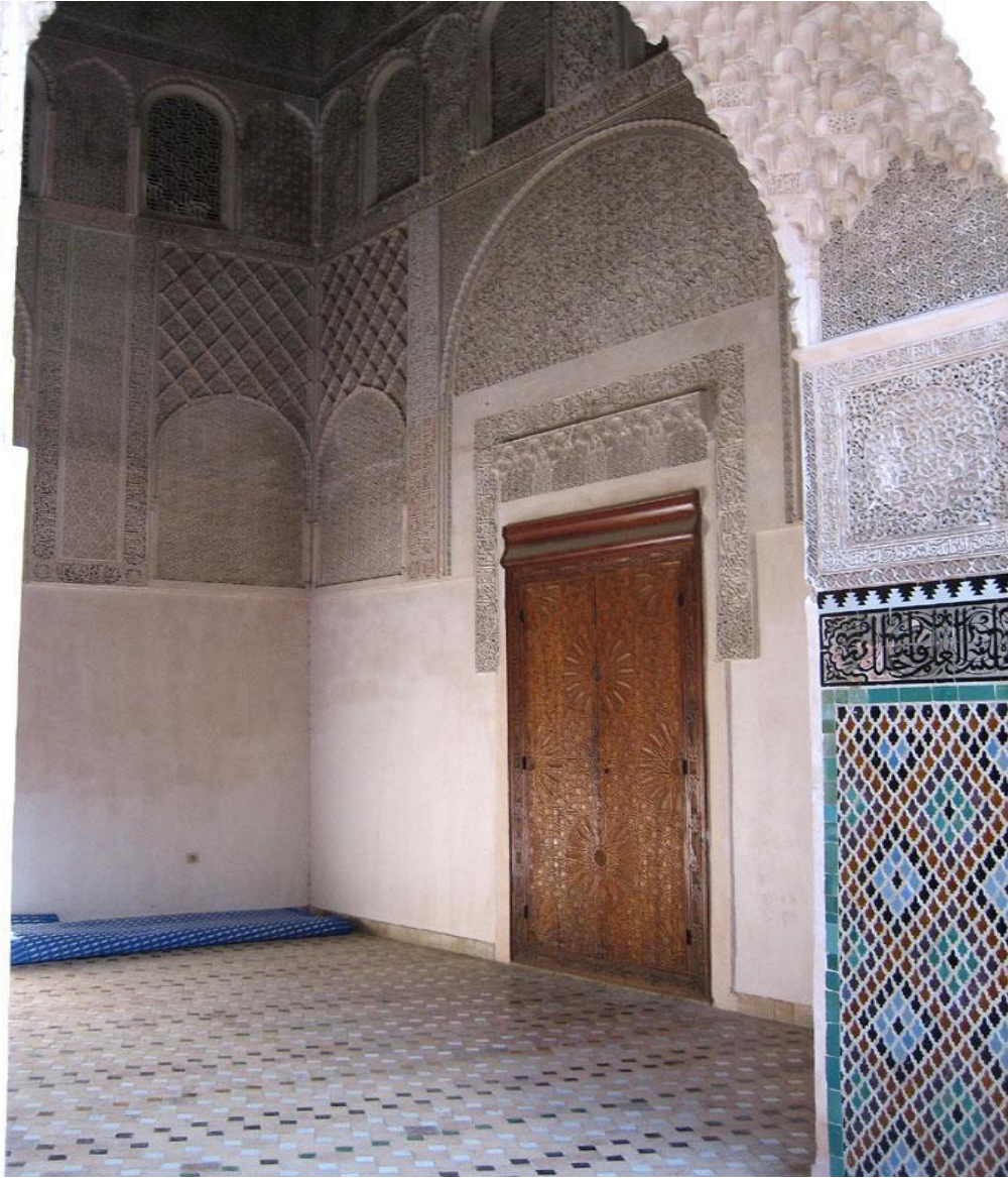
Görsel.23-Derslik Eyvani İç Duvar (Latif,2011:253)
