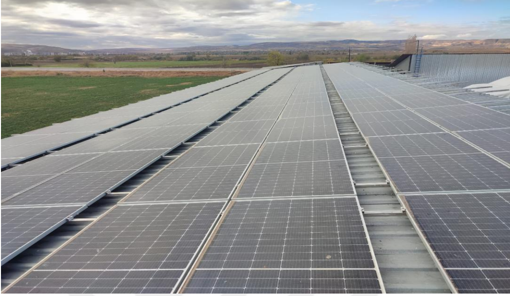
Şekil 5.2 Çatı görüntüsü (Orta çatı)
