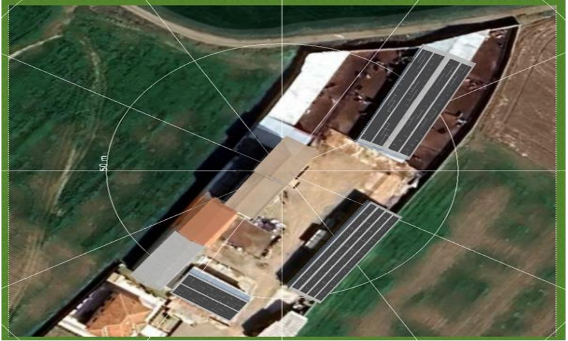
Şekil 5.18 Tüm sahaya ait panel yerleşmiş hali
