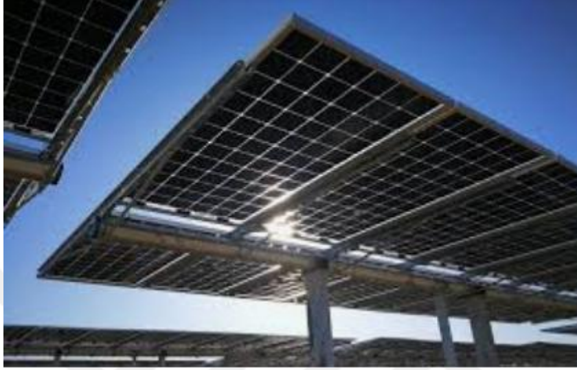
Şekil 4 9 Çift yüzölü güneş paneli (Entegro Enerji,2021)
