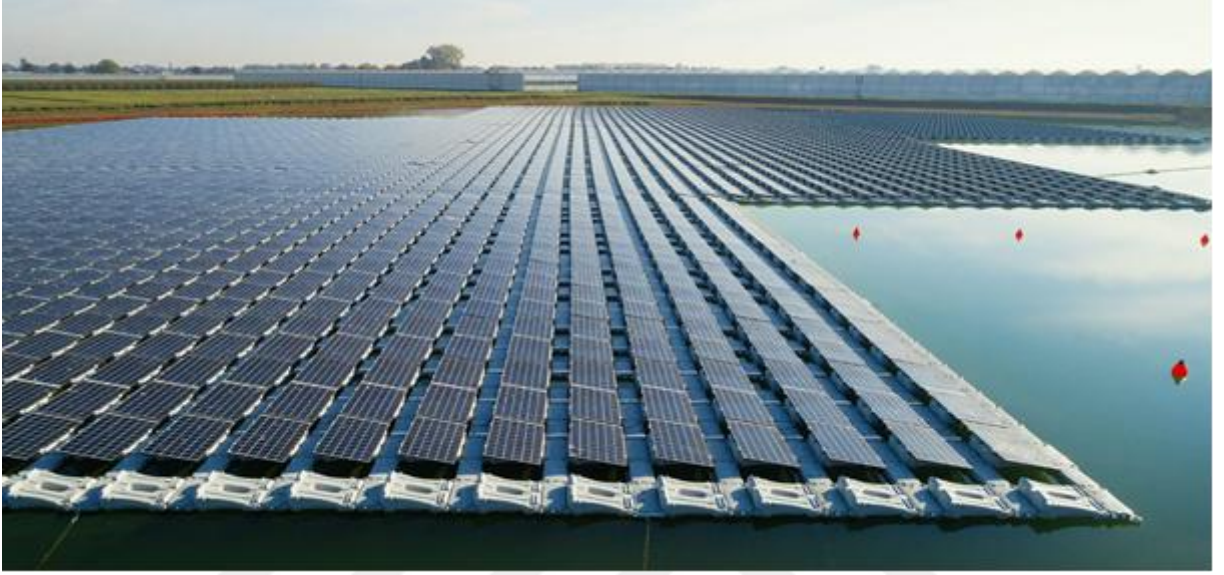
Şekil 4.6 Yüzer FV sistem (İnvento Enerji, 2020)
