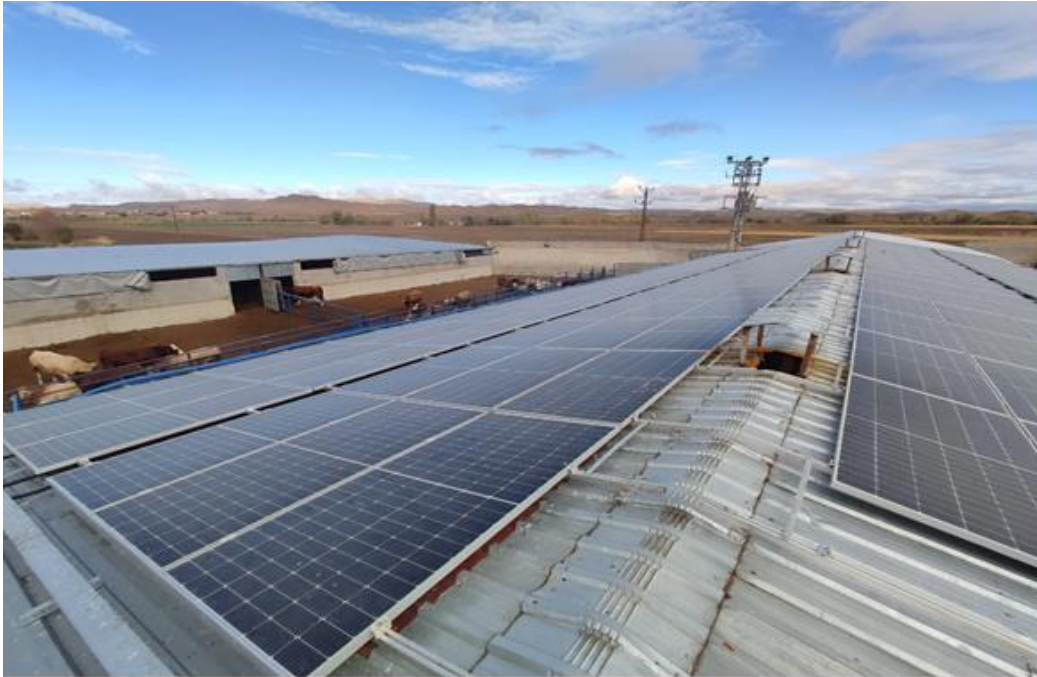
Şekil 5.1 Çatı görüntüsü (Büyük çatı)
