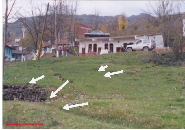
Resim 2: Efteni Kaplıcası civarında gelişmiş heyelanlar (Efteni Gölü).
