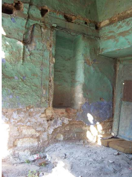
Fot.5.13 Z4 duvarda niş, 2005.
