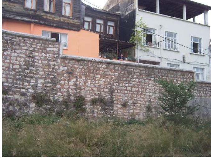
Fot. 5.33 Tekkenin batısında yer alan dış avlu-istinat duvarı, 2004.
