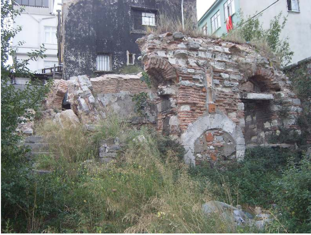
Fot. 5.46 Mutfak kuzey cephesi pencere ve kapısı, 2005.
