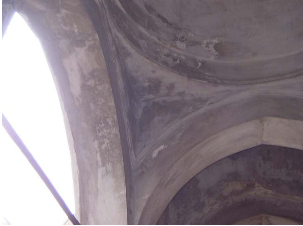
Fot. 5.41 Revaklı avluda tevhidhane önündeki kubbe köşeleri, 2004.
