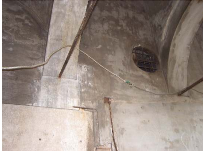
Fot. 5.32 Avlu cephesinden çilehane penceresi, 2004.
