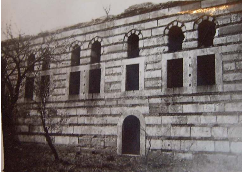
Fot 5.3 Doğu cephesinde yer alan giriş kapısı kapatılmadan önce,(İ.H.KKütüphanesi), tarih yok
