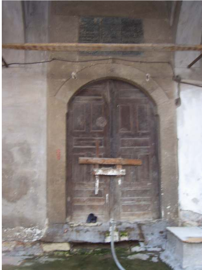
Fot. 5.22 Revaklı avludan tevhidhane giriş kapısı, 2004.
