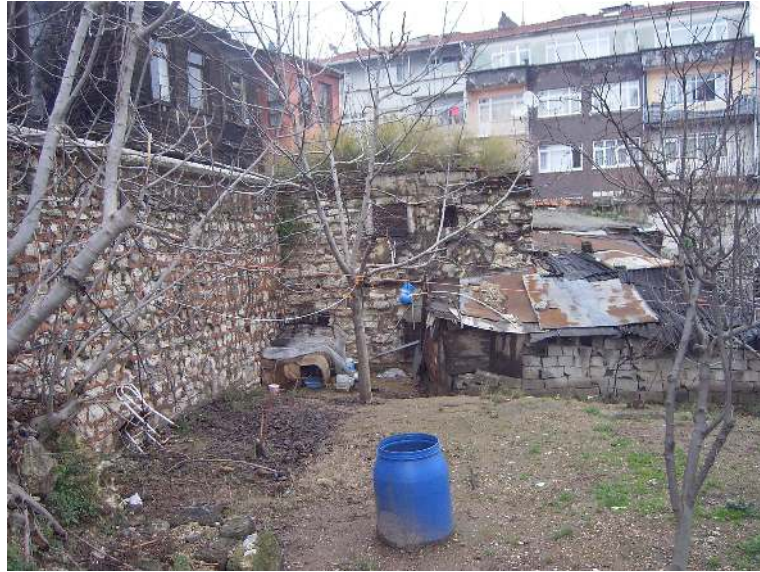
Fot. 5.56 Su haznesi güney cephesi, 2004.
