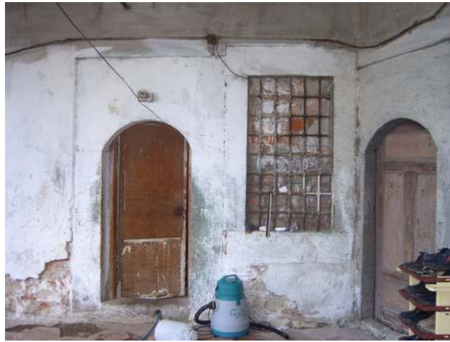
Fot. 5.15 Z6 hücresi revaklı avlu cephesi, 2005.
