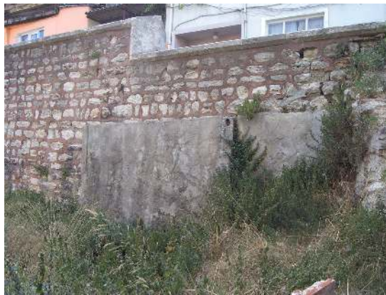
Fot. 5.61 Günümüzde batı cephesi dış avlu giriş kapısının durumu, 2005.
