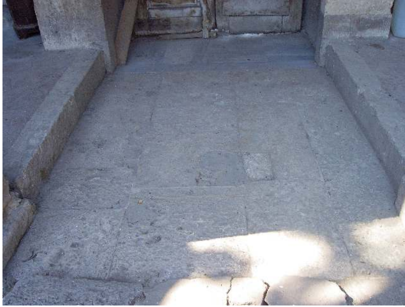
Fot. 5.8 Revaklı avlu giriş kapısı döşemesi, 2004.
