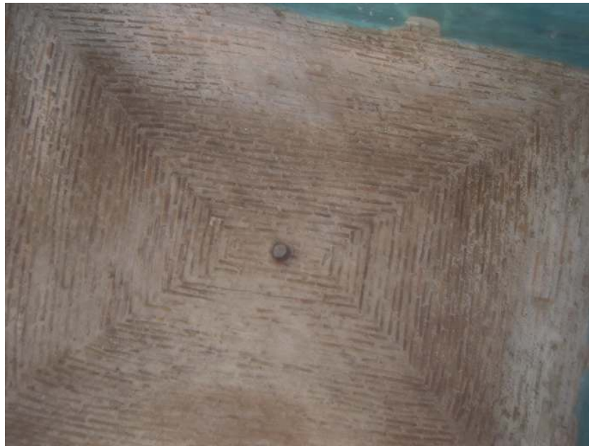
Fot. 5.44 Z5 Derviş Hücresinde tuğla ayna tonoz, 2004
