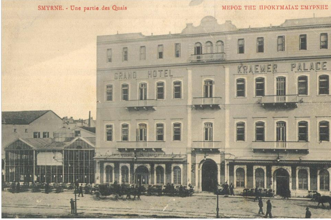
Şekil 4.41. Kraemer Palace, Dört Katlı İken [61]
