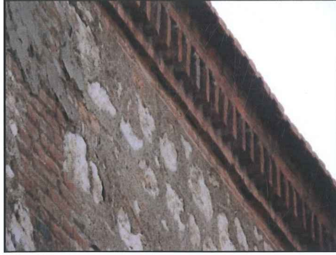
Resim 71. 119 sokak no:10 tuğla dişli friz saçak ayrıntısı. (Buca)
