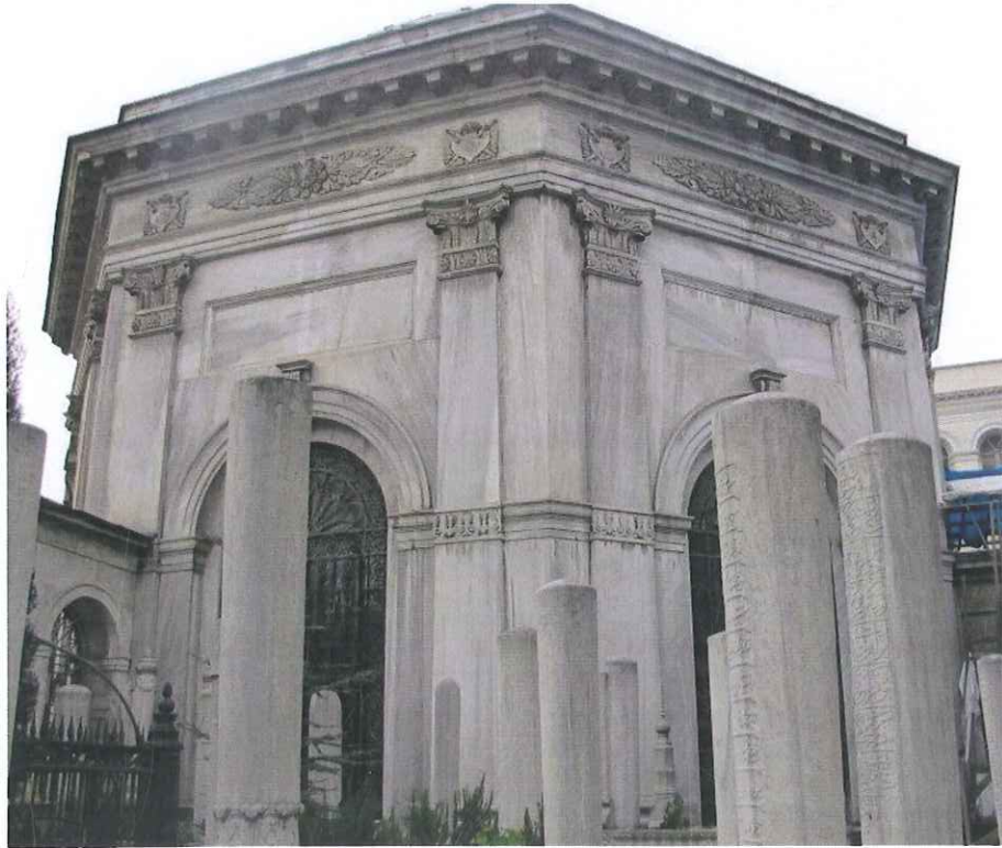
Resim 7. İstanbul, Sultan II. Mahmud Türbesi.
