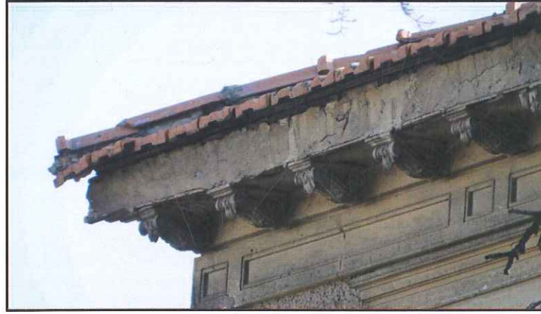
Resim 59. R. Whittall Köşkü alçı payanda saçak ayrıntısı. (Bornova)
