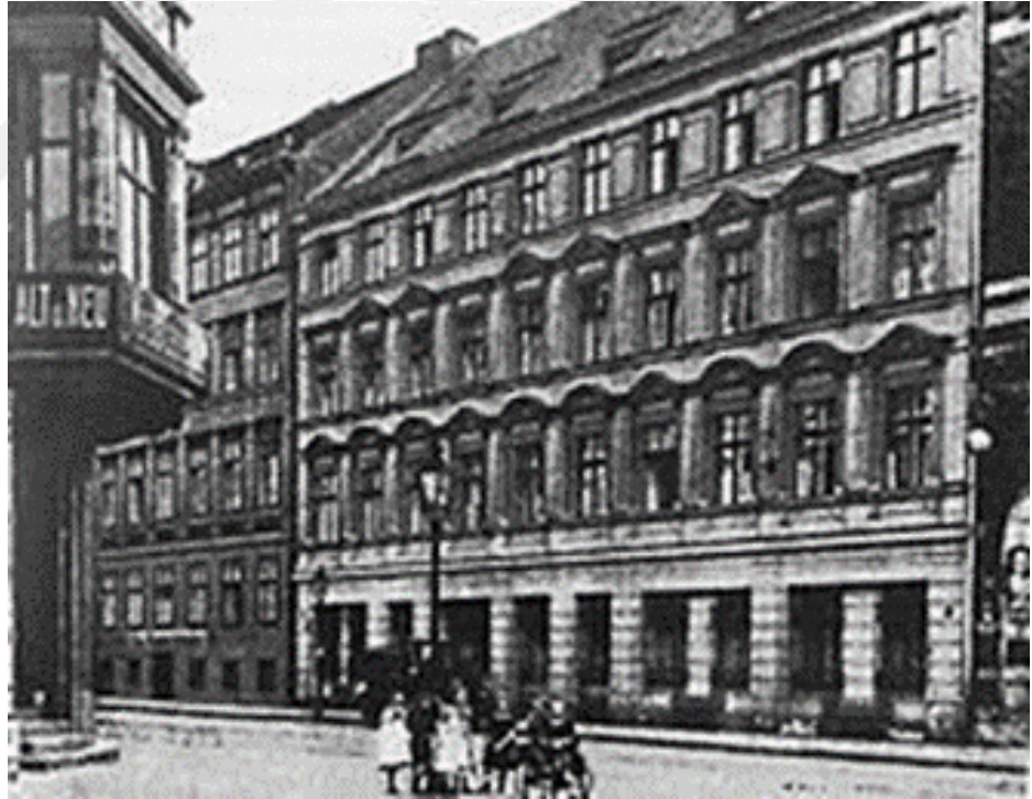
Resim 2.6. NfO Merkez Binası, Berlin, Mauerstrasse, 45-46.
