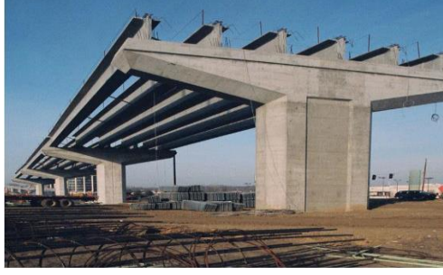
Şekil 1.16. Öngerilmeli beton bir köprü (URL-10)
