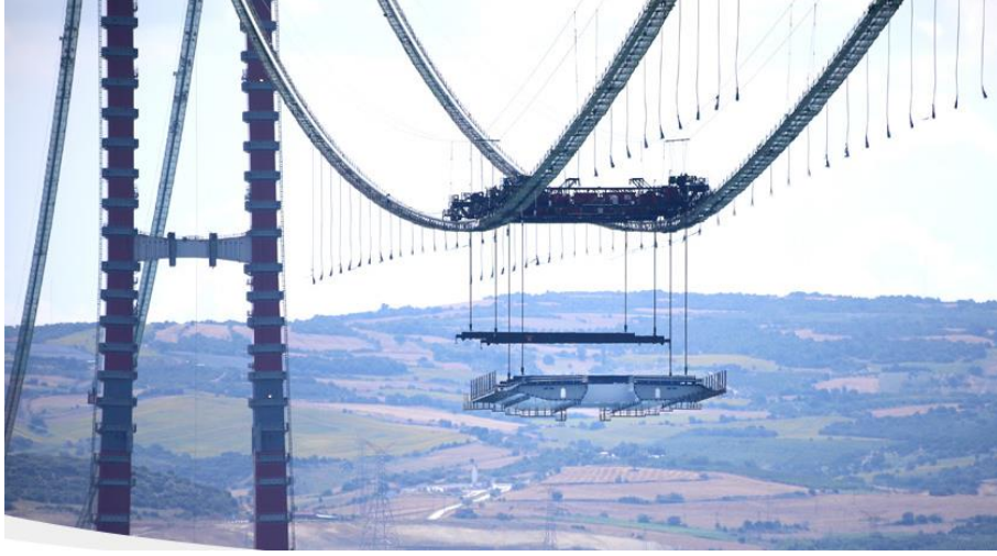
Şekil 2.10. 1915 Çanakkale Asma Köprüsü ilk tabliye montajı (URL-18)
