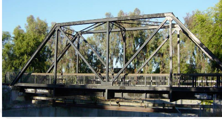
Şekil 1.6. Kaliforniya'daki Güney Pasifik Kafes Kirişli köprüsü (URL-4)
