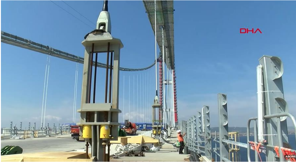
Şekil 2.13. 1915 Çanakkale Asma Köprüsü işleri tamamlamak üzere (URL-18)
