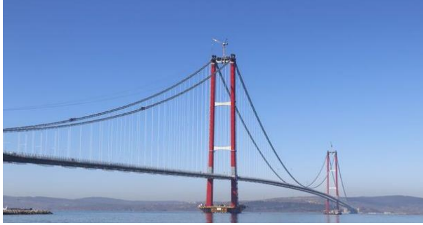
Şekil 2.14. 1915 Çanakkale Asma Köprüsü işleri tamamlandı (URL-20)
