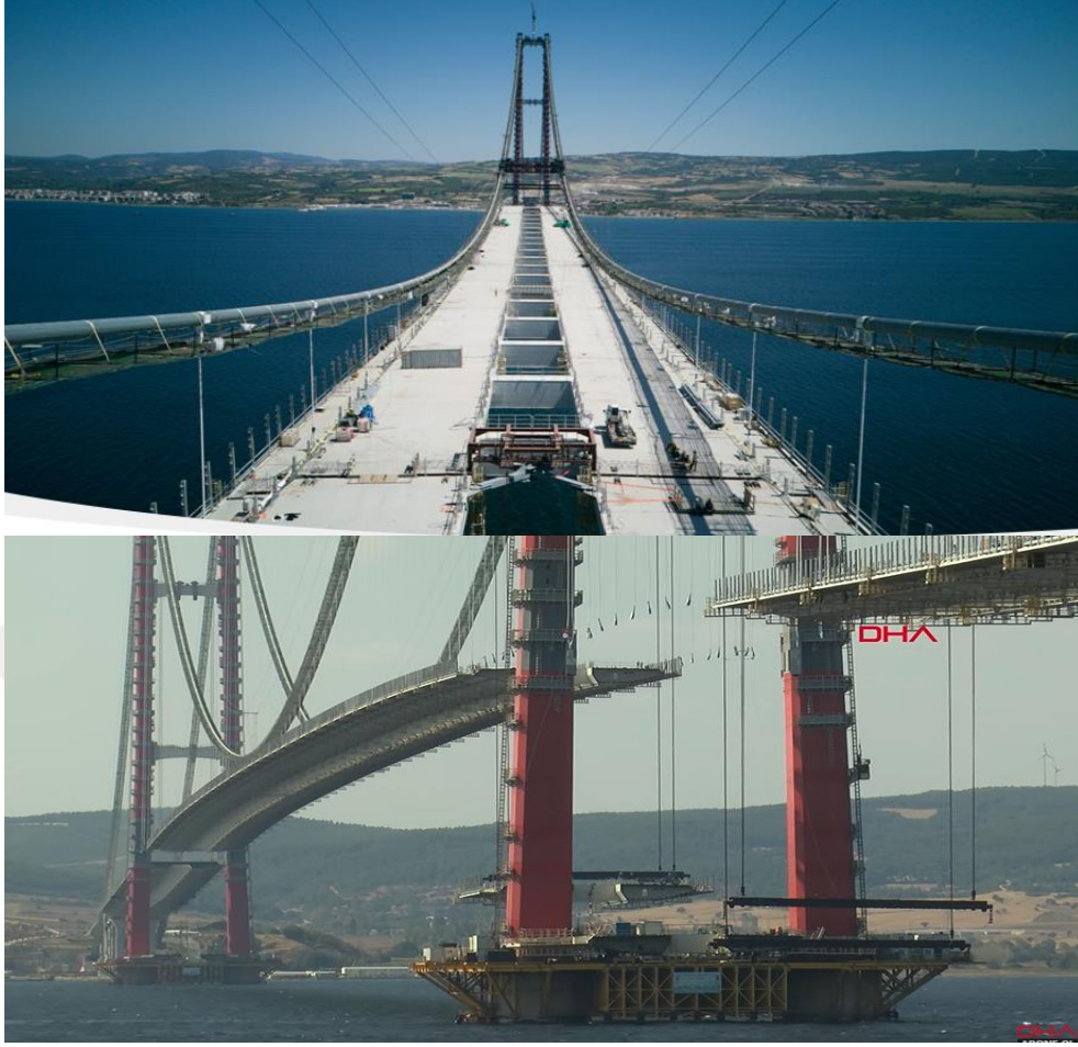
Şekil 2.12. 1915 Çanakkale Asma Köprüsü son tabliye montajı (URL-18).
