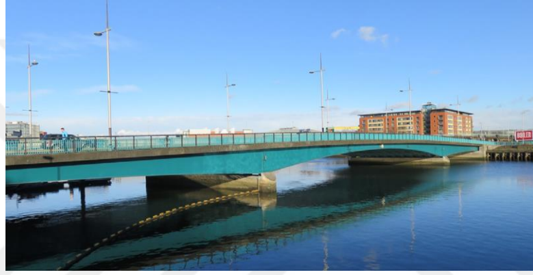
Şekil 1.5. Kraliçe II. Elizabeth Köprüsü (çelik sürekli kirişli köprü). (Lin ve Yoda, 2017)
