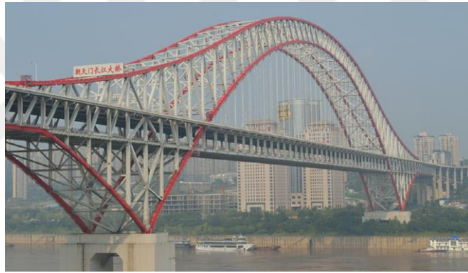
Şekil 1.2. Chaotianmen Köprüsü, Chongqing, Çin. (Lin ve Yoda, 2017)
