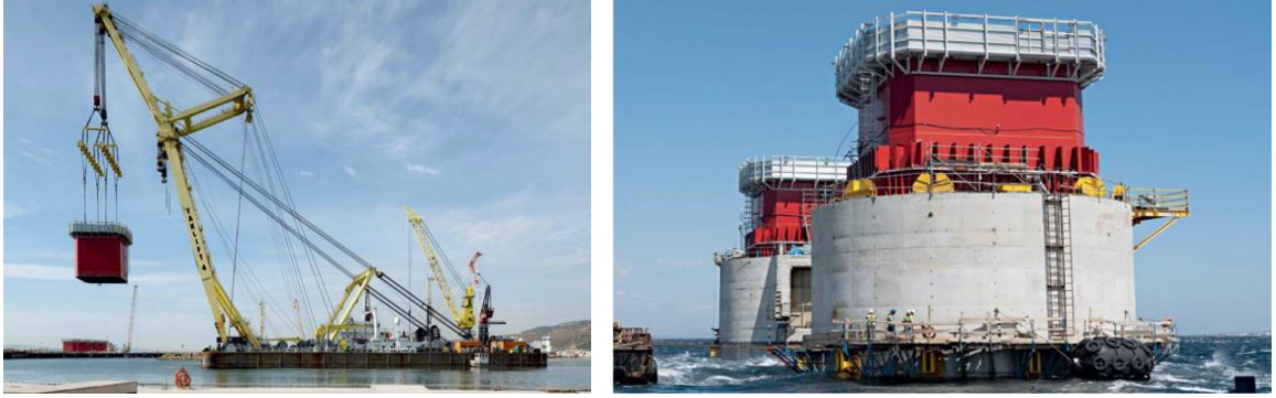
Şekil 2.4. 1915 Çanakkale Asma Köprüsü kule ilk imalatı (URL-16)
