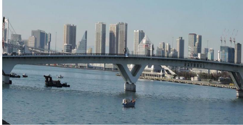
Şekil 1.7. Toyosu Köprüsü, Tokyo, Japonya. (Lin ve Yoda, 2017)
