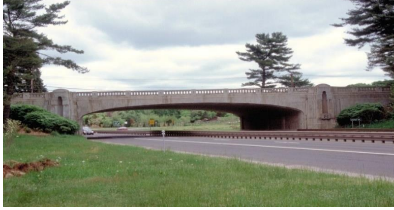
Şekil 1.12. Rijit çerçeveli bir köprü (Merritt Pkwy Köprüsü-ABD) (URL-7)
