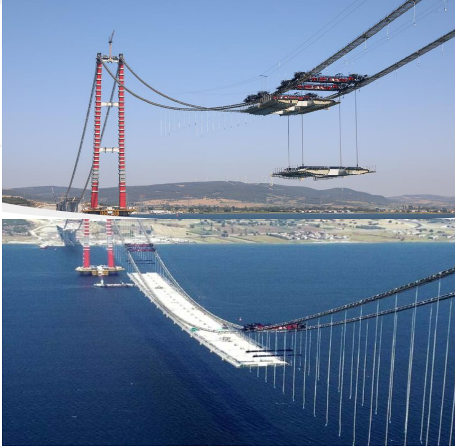
Şekil 2.11. 1915 Çanakkale Asma Köprüsü tabliye parçaları montajı (URL-18)
