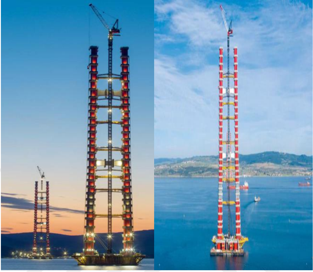
Şekil 2.6. 1915 Çanakkale Asma Köprüsü kule son imalatı (URL-16)
