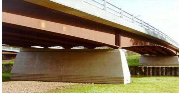
Şekil1.17. Çelik-beton kompozit kutu kirişli bir köprü (Westgate köprüsü, Gloucester) (URL-11)
