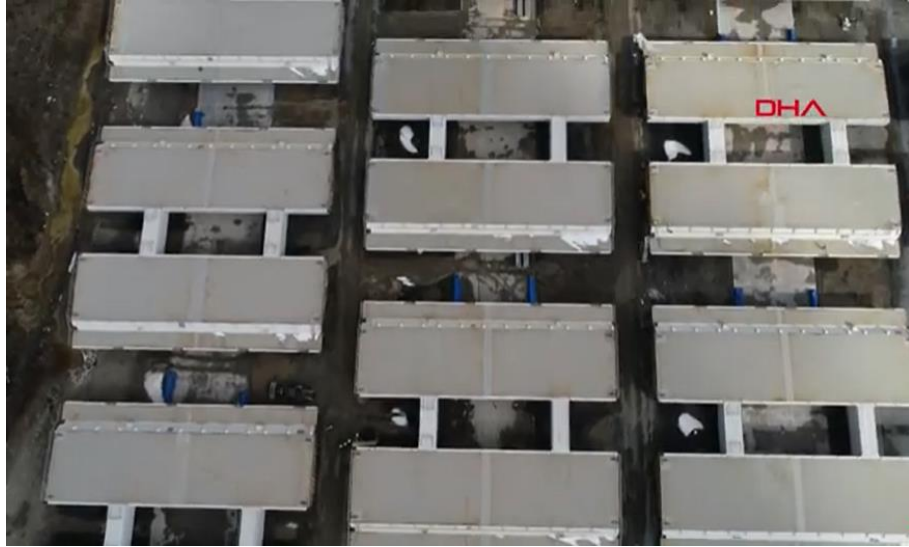
Şekil 2.9. 1915 Çanakkale Asma Köprüsü tabliye parçaları (URL-19)
