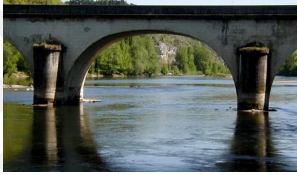
Şekil 1.15. Dünyanın ilk betonarme köprüsü (URL-9)
