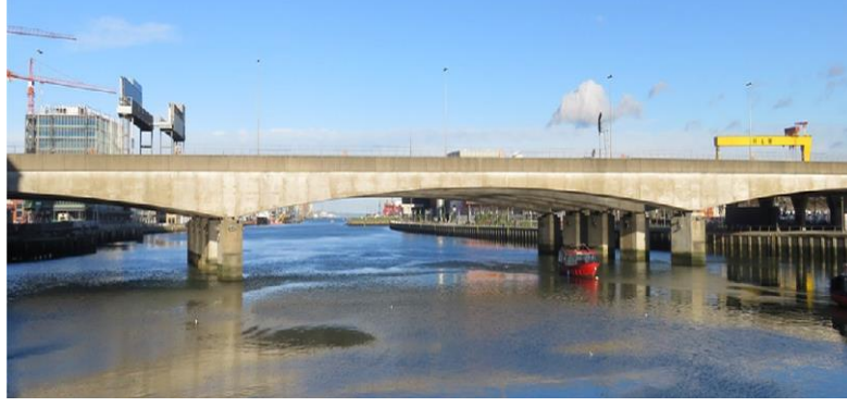
Şekil 1.4. Lagan köprüsü (beton sürekli kirişli köprü). (Lin ve Yoda, 2017)
