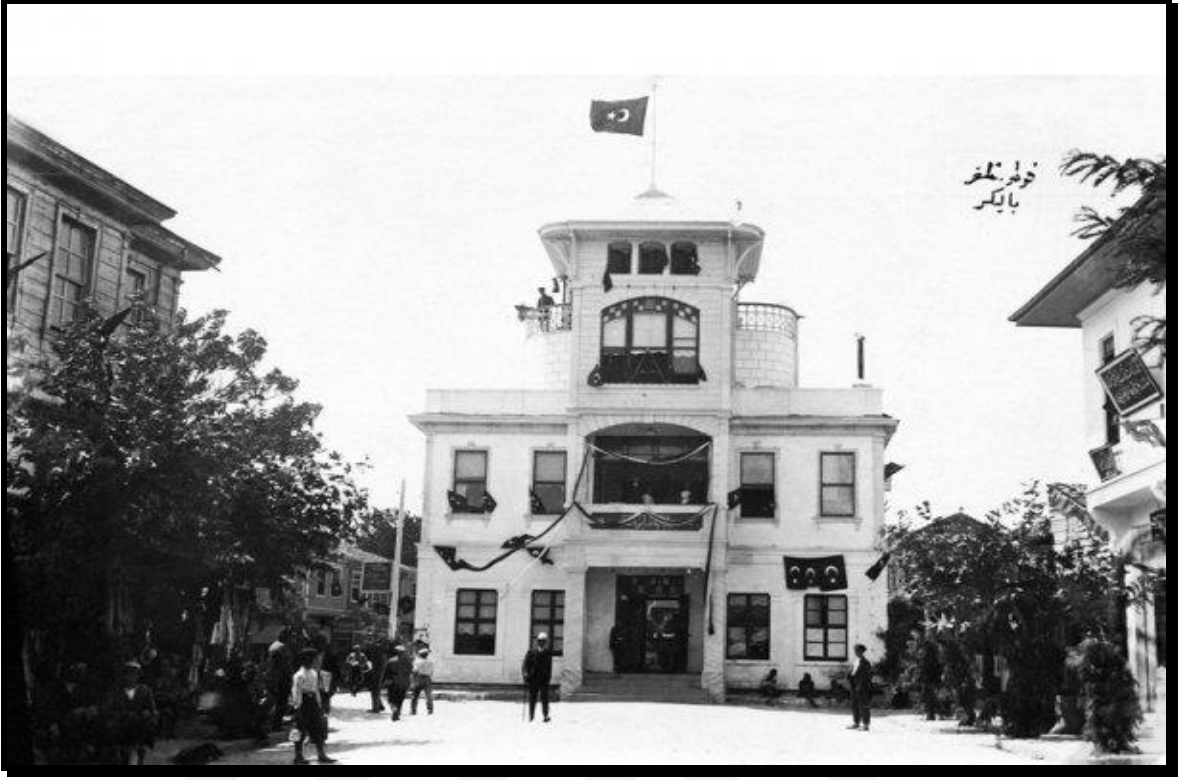
Ek: 9 Nisan 1935’de yıkılan eski belediye binası
