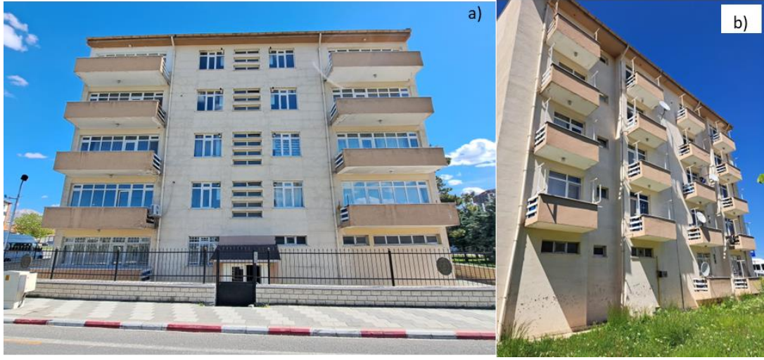
Şekil 2.1: Binanın a) önden ve b) yandan görünüşü
