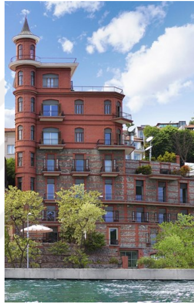
Görsel 83. Perili Köşk Borusan Contemporary Bina görüntüsü
