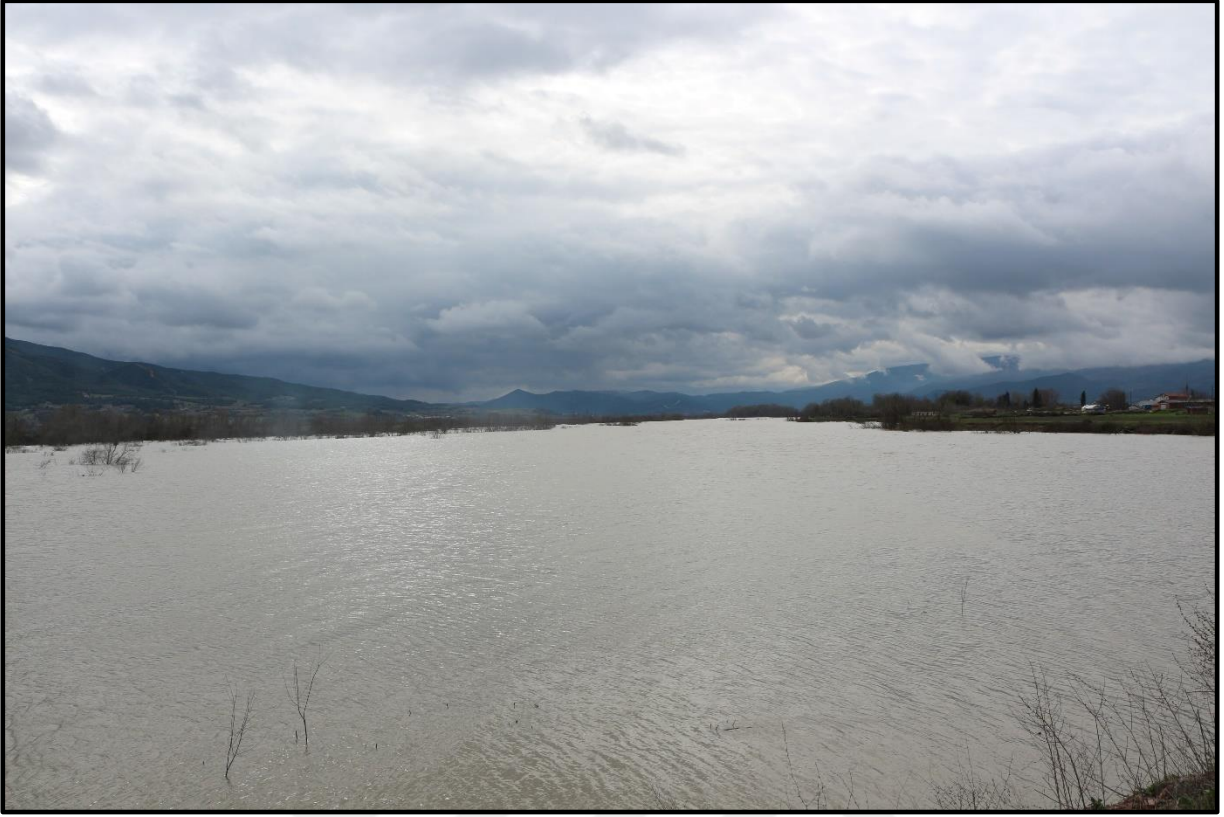
Resim 2.2. Çardak Köyü Yakınlarından Baraj Alanından Genel Görünüm
