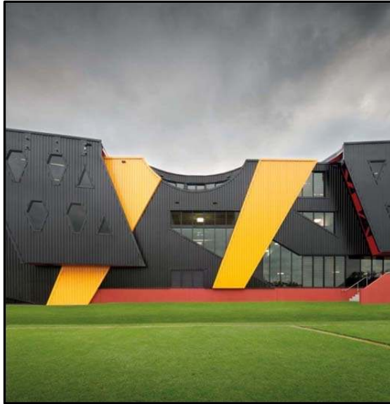
Şekil 3.46. Spor Merkezi Cephesi (Url-18)
