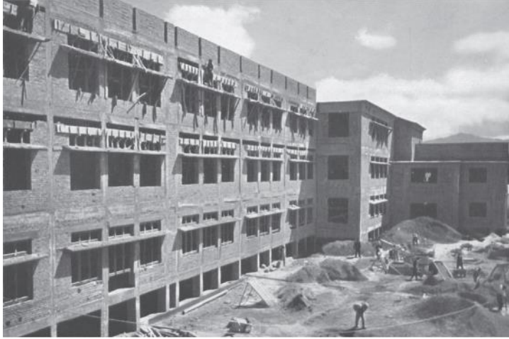
Şekil 4.28. Atatürk Lisesinin cephesinde kullanılan güneş kırıcı elemanlar (Alpagut 2018)
