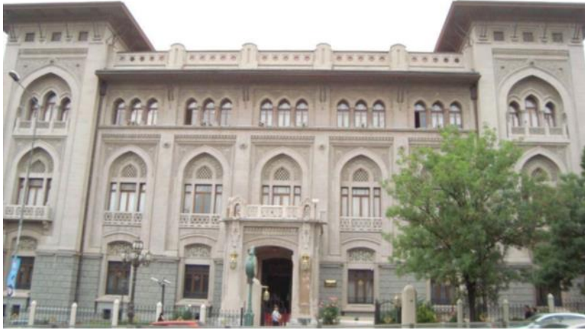
Şekil 4.35. Ankara Ziraat Bankası yapısının dış cephesi (Çinici 2015)
