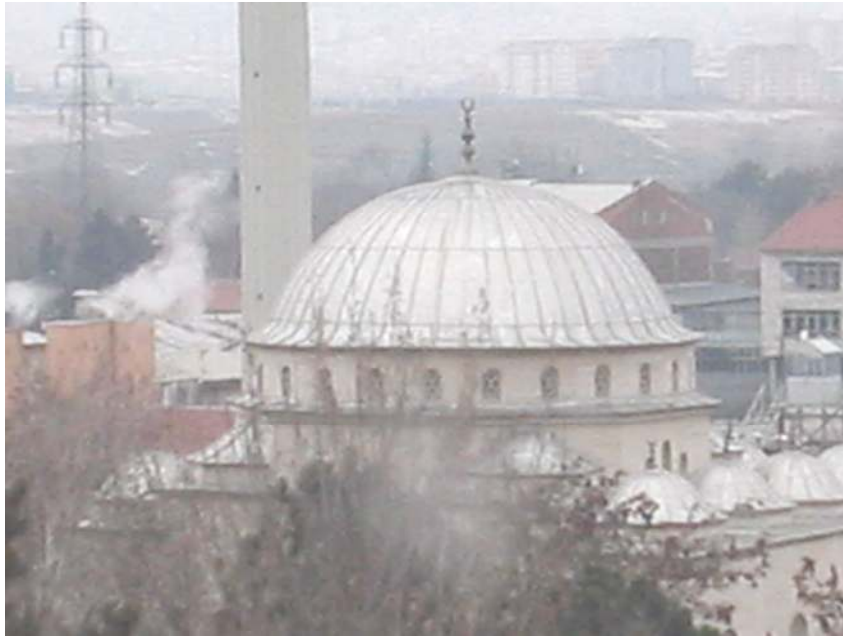
Resim 9.89. Köy Hizmetleri Camii'nin uzaktan görünümü
