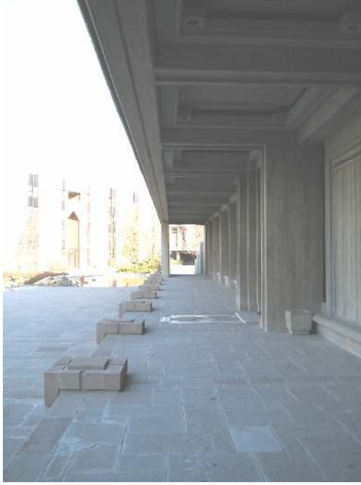
Resim 9.23. TBMM Camii'nin kolonsuz revakları (son cemaat mahalli)
