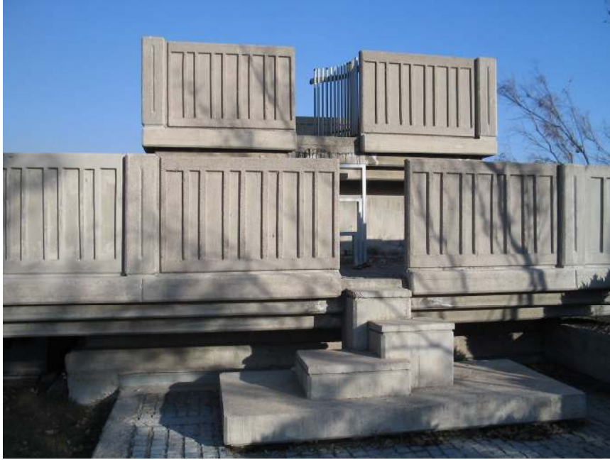
Resim 9.22. TBMM Camii'nin minaresi (arka cepheden görünüş)
