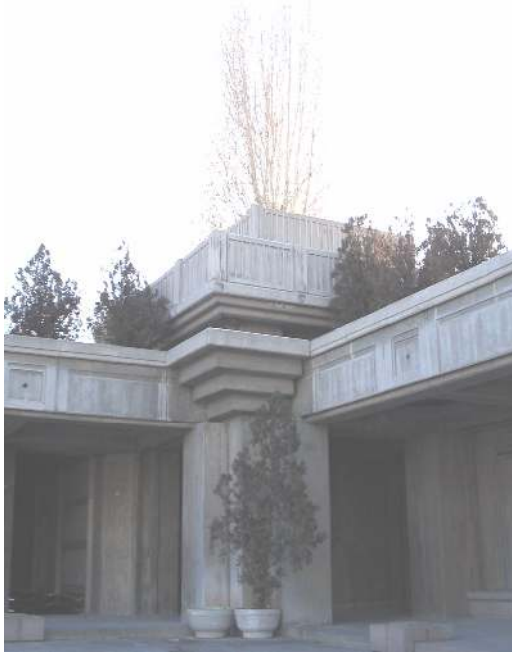
Resim 9.21. TBMM Camii'nin minaresi (ön görünüş)
