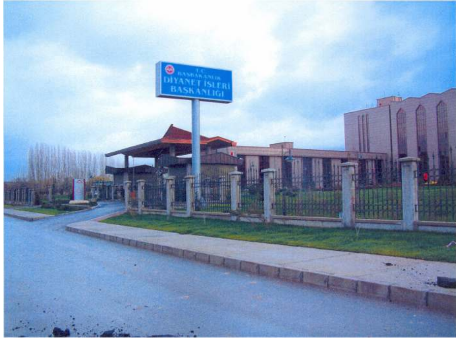
Resim 9.110. Diyanet İşleri Başkanlığı binası
