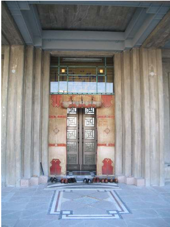
Resim 9.20. TBMM Camii'nin giriş kapısı
