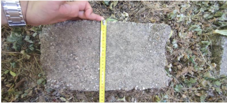
Şekil 4.37. Barınak Yapı Kooperatifi'nde duvarlarda kullanılan çimento harçlı briket eni ölçümü (21 cm)
