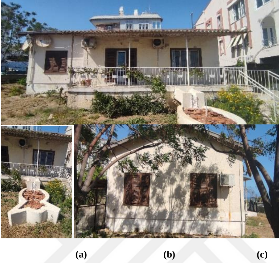
Şekil 4.40. Yukarıdan aşağıya soldan sağa a) Ayşe Cephaneçi'nin evi, sahil yoluna bakan cephe; b) Bahçedeki balık formu havuz; c) Yatak odalarının bulunduğu cephe
