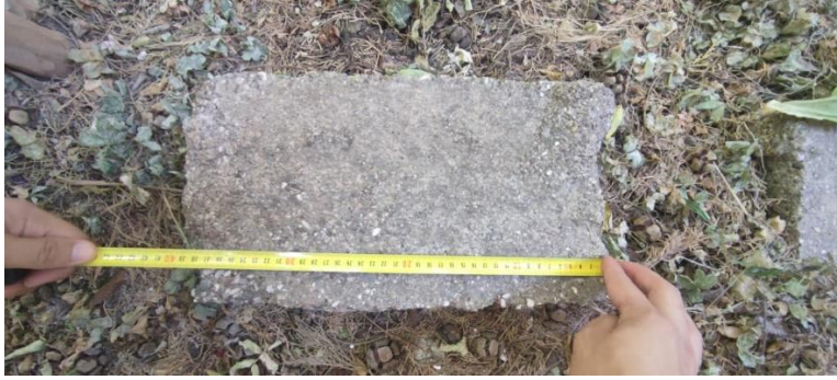
Şekil 4.36. Barınak Yapı Kooperatifi'nde duvarlarda kullanılan çimento harçlı briket boyu ölçümü (40 cm)
