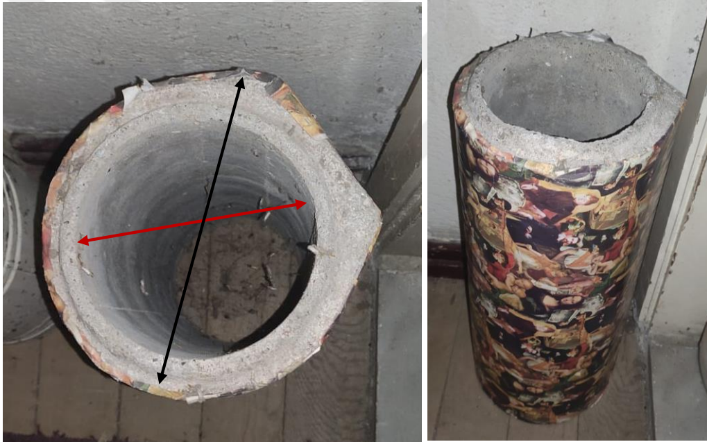
Şekil 4.34. Zemin altında odaların birbiriyle olan hava bağlantısını sağlayan beton boru
