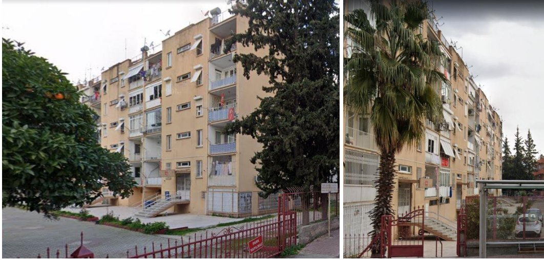
Şekil 4.55. Güç Apartmanı cepheler (Google Earth 2024b)
