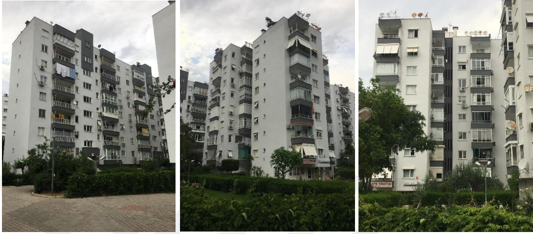
Şekil 4.79. Anıl Sitesi cephe görünüşleri
