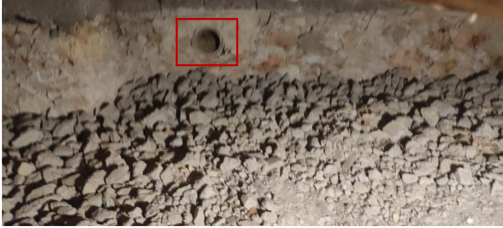
Şekil 4.34. Zemin altında odaların birbiriyle olan hava bağlantısını sağlayan beton boru
