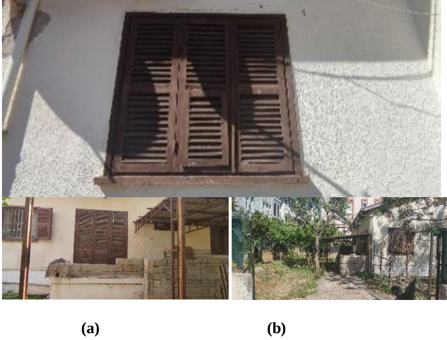
Şekil 4.41. Yukarıdan aşağıya soldan sağa a) Sedir pencere kepenkleri; b) Arka bahçeye bakan cephe; c) Araç park alanı
