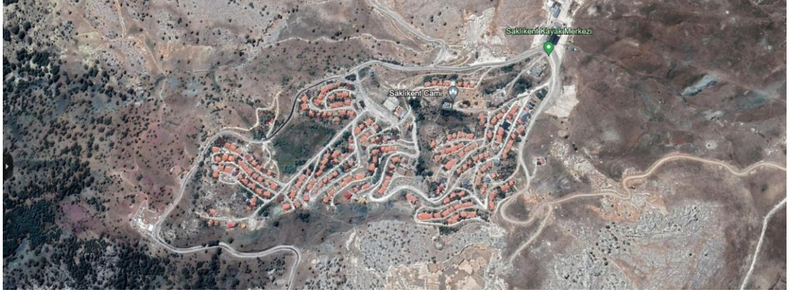
Şekil 4.68. Saklıkent’te bulunan kooperatif yerleşkesi (Google Earth 2024ç)
