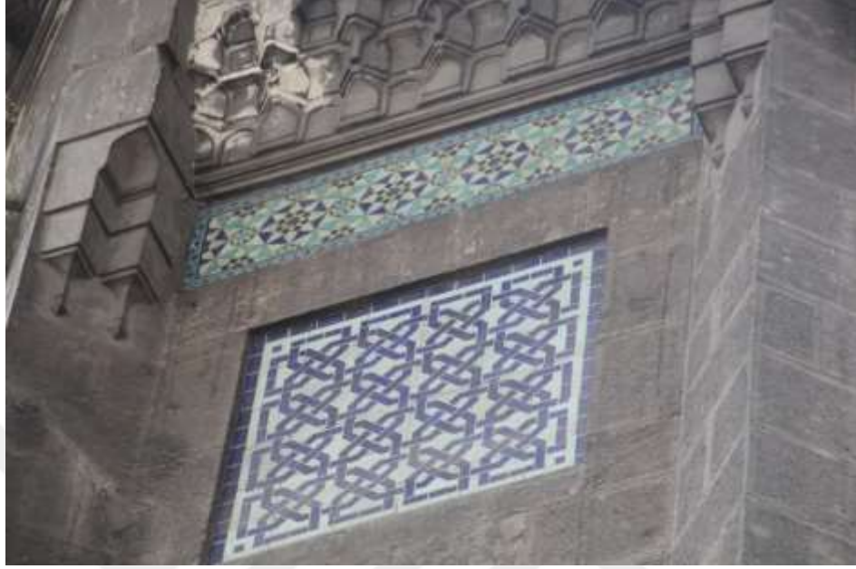
Fotoğraf 205: Hobyar Mescidi kuzeydoğu cephe pano 5 (Koçak, 2020)
