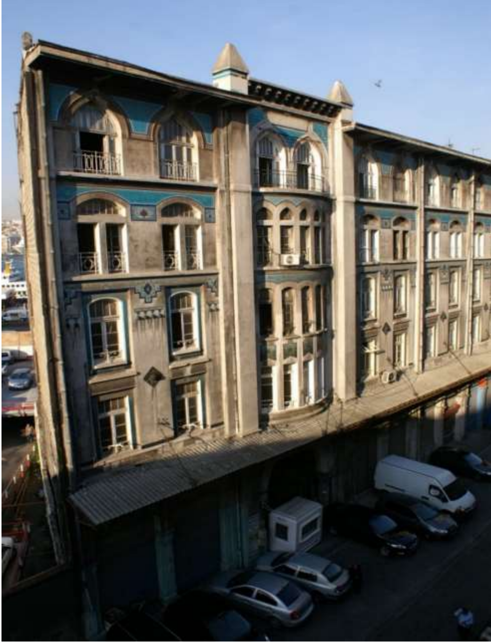
Fotoğraf 98: Liman Han, onarım çalışmalarından önceki görünümü (Tures, 2017).
