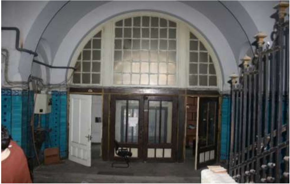
Fotoğraf 101: Liman Han, iç cephe duvarları (Tures, 2017).
