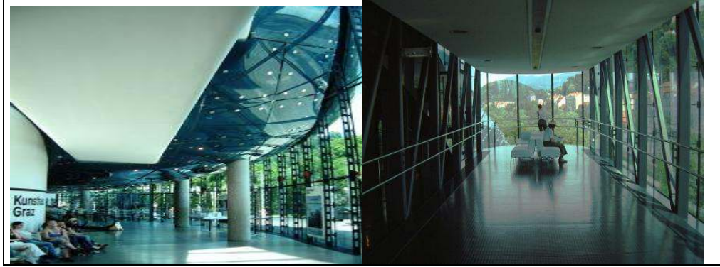
Resim 9.6. Kunsthaus Graz, Low-e cam ve çelik strüktürün cephede kullanımı [94]
