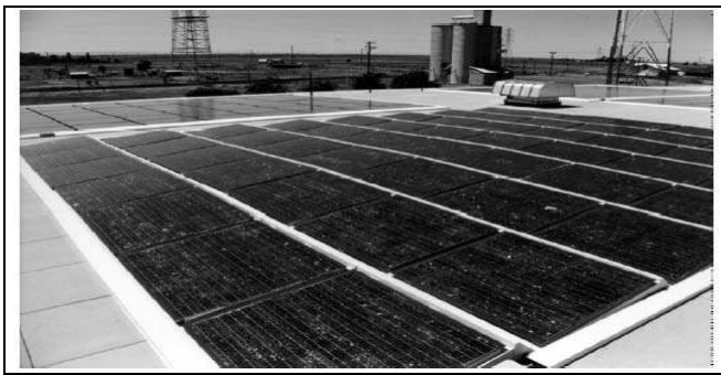
Resim 4.2. Fotovoltaik (PV) modüllerin yapıstırıldığı sistem [11]
