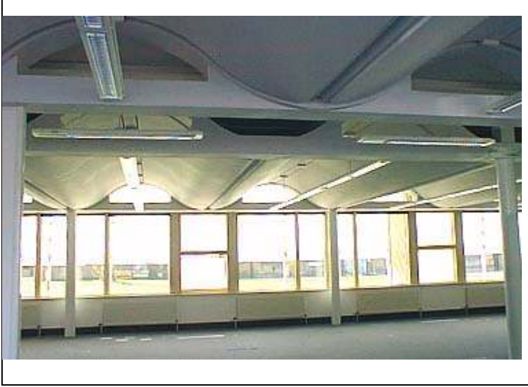
Resim 4.3. Yapı Araştırma Kurumu (BRE) Binası, aydınlatma sistemi, dalgalı formlu döşeme [46]
