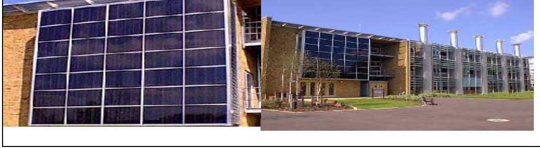
Resim 4.1. Yapı Araştırma Kurumu (BRE) Binası, havalandırma bacaları [46]
