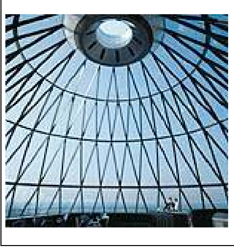
Resim 10.2. Swiss Re Londra Merkez Binası, iç avlu üstü merkezi kontrollü üçgen pencereler [97]
