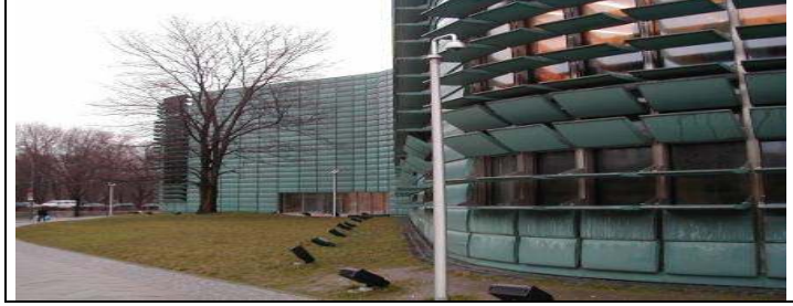
Resim 8.2. Zollhof Kompleksi, cephede güneş kırıcı paneller [100]
