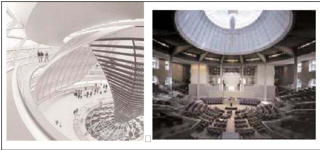
Şekil 7.1. Alman Parlamento Binası, enerjisini fotovoltaik panellerden sağlayan, aydınlatma bacası ve güneş kontrol panelleri [11]
