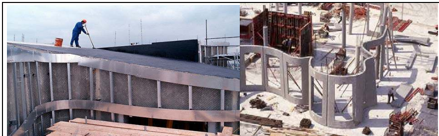
Resim 8.3. Zollhof Kompleksi, yapım aşaması [100]
