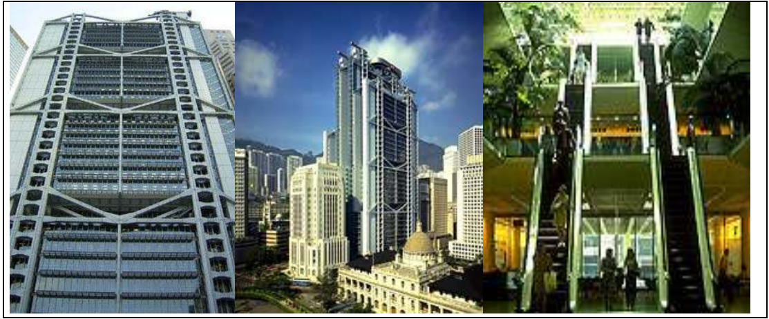
Resim 2.1. Hong Kong-Shanghai Bank Binası, dış cephe görünüş ve merkezi atrium [79]
