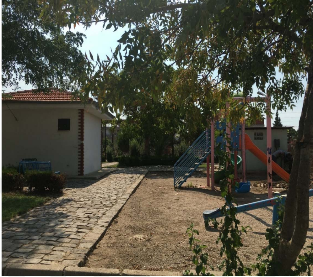
Şekil 4.13 Muhtarlık Binası Arkası Park (BMP1)
