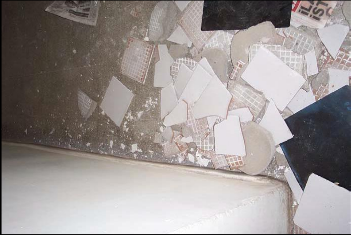
Şekil 4.23 Fayans dökülmesi [12]
