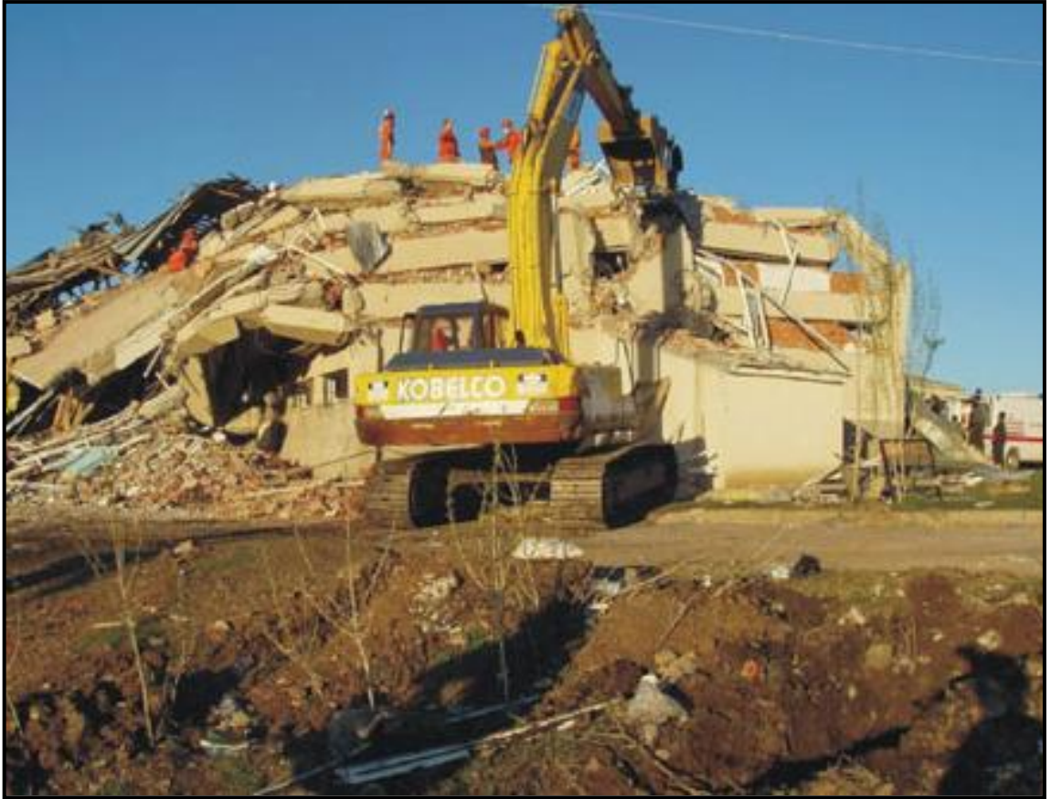
Şekil 4.17 Depremde tamamen göçmüş ve 84 öğrenci ile 1 öğretmenin ölümüne yol açmış olan Çeltiksuyu Yatılı Bölge Okulu pansiyon binasının görünümü [16]
