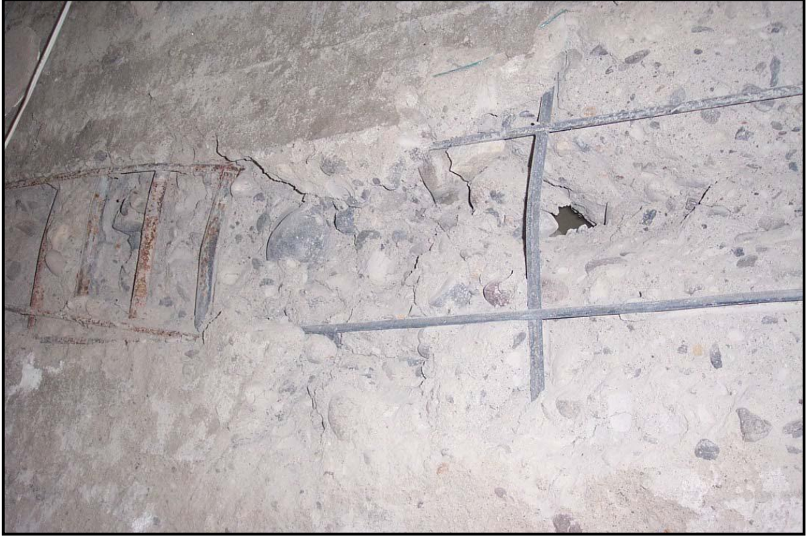
Şekil 4.12 Donatı ve malzeme kusurları [12]
