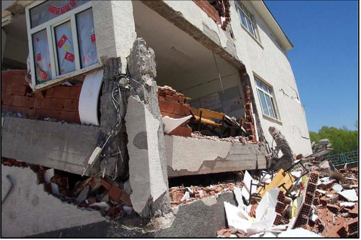
Şekil 4.10 Kolon kesmesi [12]
