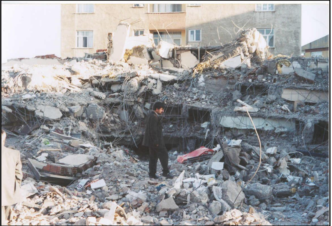
Şekil 4.15 Kolon ve kiriş çözülmüne bağlı tam göçme [21]
