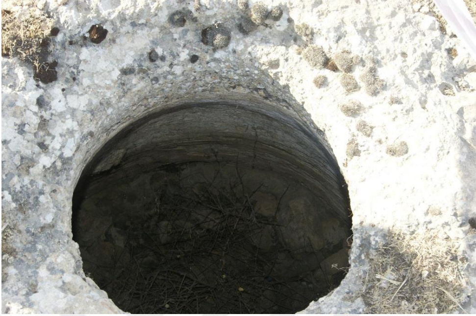
a. Zerzevan Kalesi'nden Yeraltı Sarnıcının Ağız Kısım ve Sıva Uygulaması
