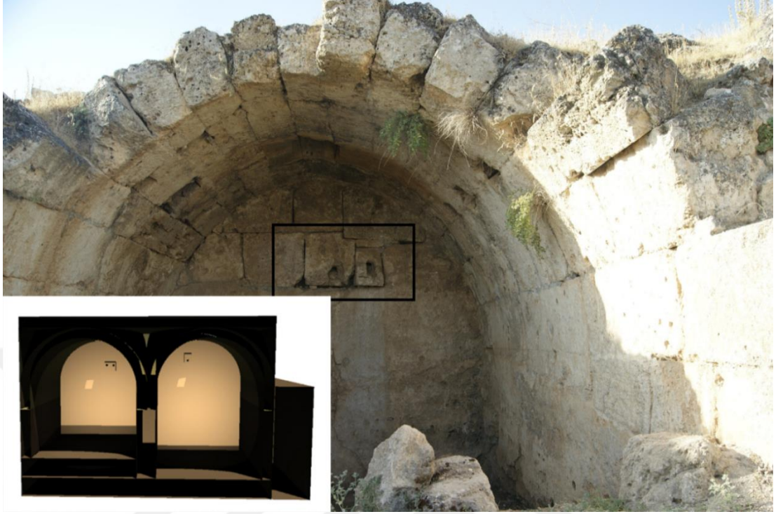
a. 1 No'lu Deponun Güney Duvarındaki Akıtaç
