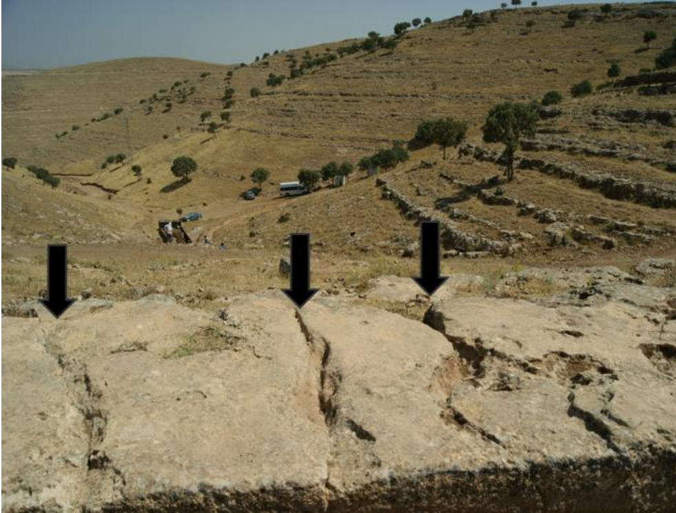
b. Zerzevan Kalesi, Su Kanalına Yağmur Sularını Toplayan Oluklar
