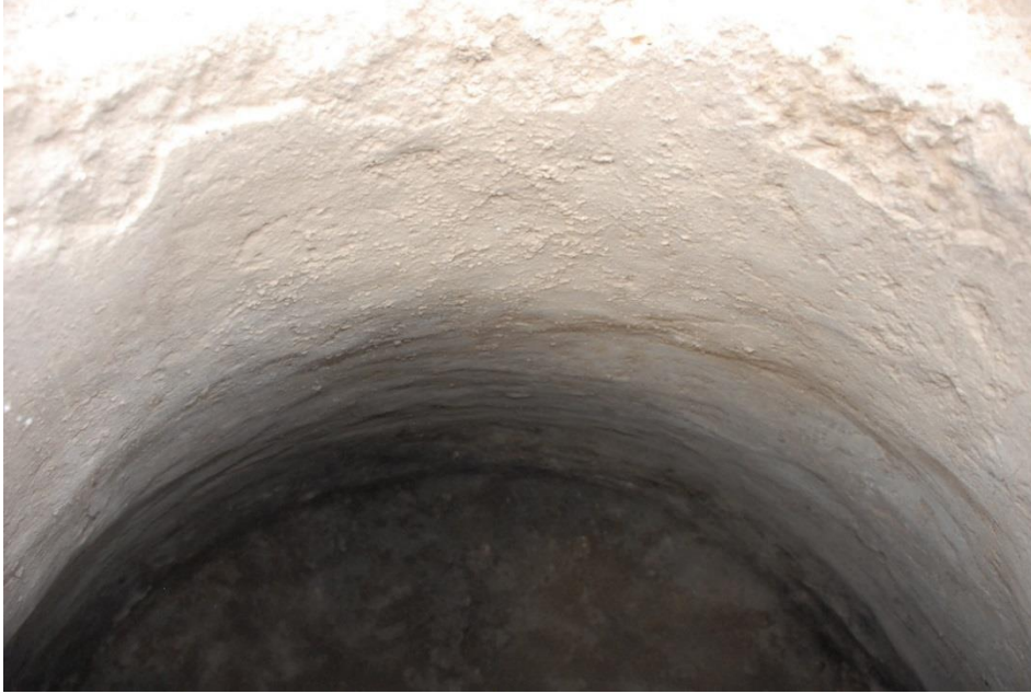
b. Zerzevan Kalesi, L Yapısı İçindeki Yeraltı Sarnıcındaki Sıva Uygulaması
