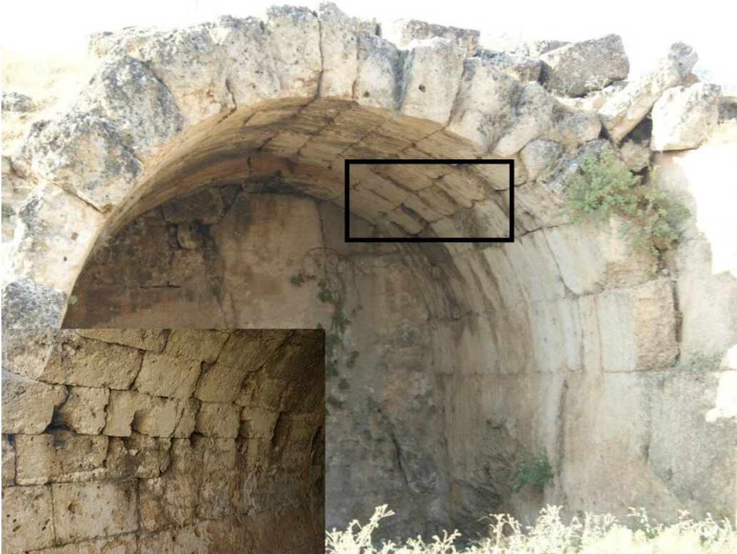
b. Tonozlu Sarnıç, 2 No'lu Depodaki Hatıl İzleri
