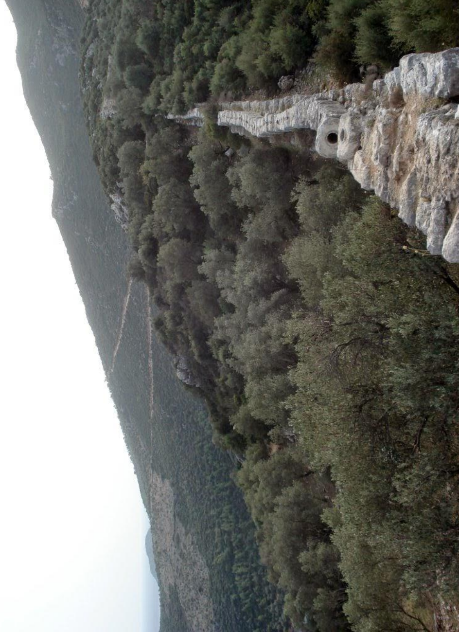
Hellenistik ve Roma Dönemlerinde Kullanım Görmüş, Patara'ya Su İleten Taş Borular
