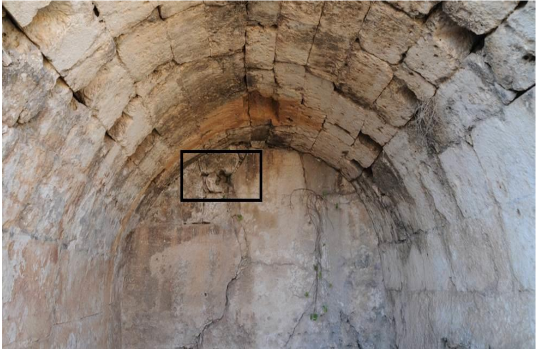
b. 2 No'lu Deponun Güney Duvarındaki Akıtaç
