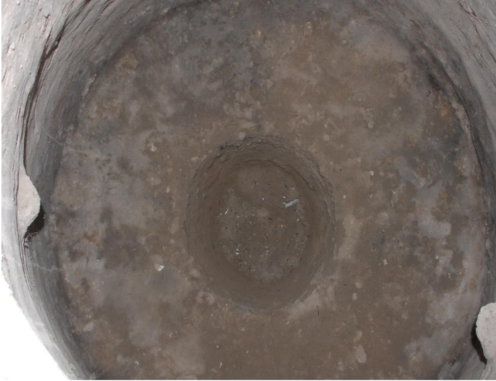
b. Zerzevan Kalesi, L Yapısı İçindeki Yeraltı Sarnıcındaki Çökertme Havuzu
