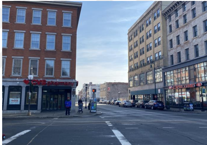
Resim 67: Sergi Binası Uzaktan Görüntüsü, 832 Chapel Street, New Haven, CT, Kasım 2019
