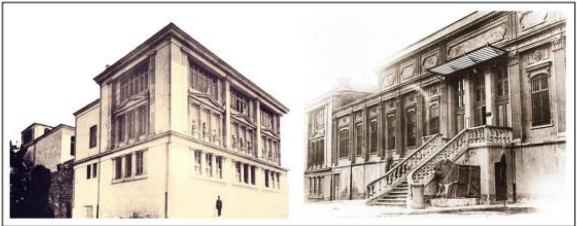
Şekil 13. Sanayi-i Nefise ilk mektep binası
