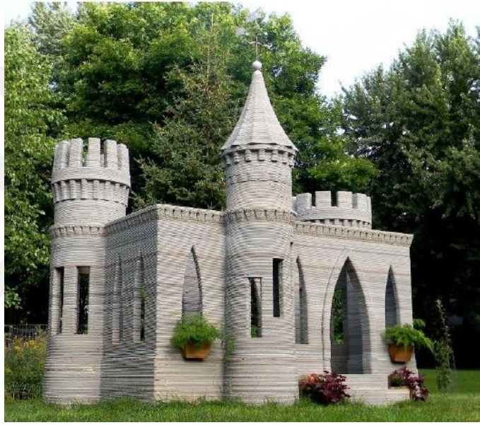
Resim 3.2. İlk yapılmış 3D Beton Baskılı Yapı (Breland, 2017)
