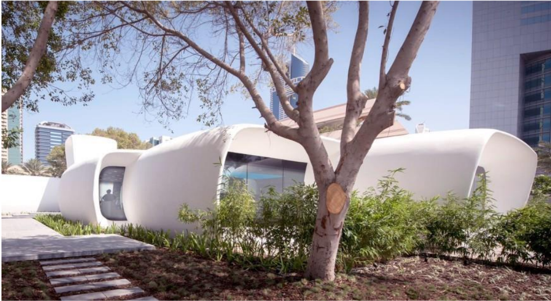
Resim 5.6. Geleceğin ofisi - 3D baskılı ofis; elektrik, su, telekomünikasyon ve hatta iklimlendirme sistemleri ile tamamen işlevsel bir bina
