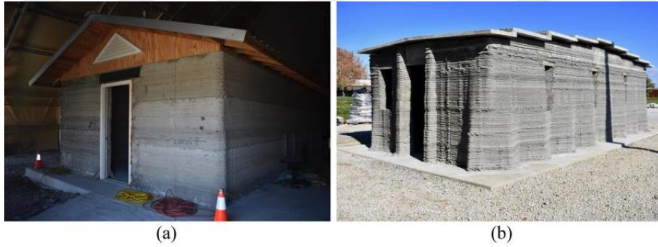
Resim 5.2. 3D Baskılı Kulübeler
