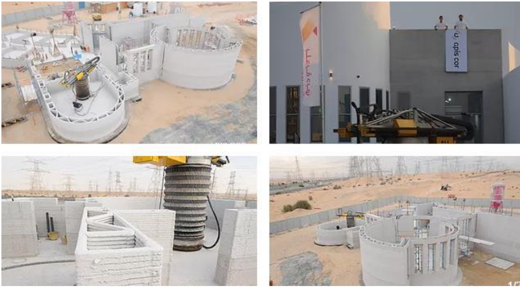
Resim 5.7. Apis Cor'un 3D baskı makinesi, binanın farklı bölümlerini inşa edebilmesi için yeniden konumlandırmak üzere bir vinç kullanılarak sahada hareket ettirilmiştir (Bayrak ve Sarıtaş, 2024)
