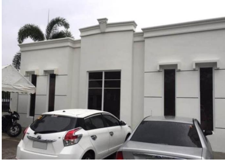
Resim 3.3. İlk Yapılmış 3D Beton Baskılı Otel
