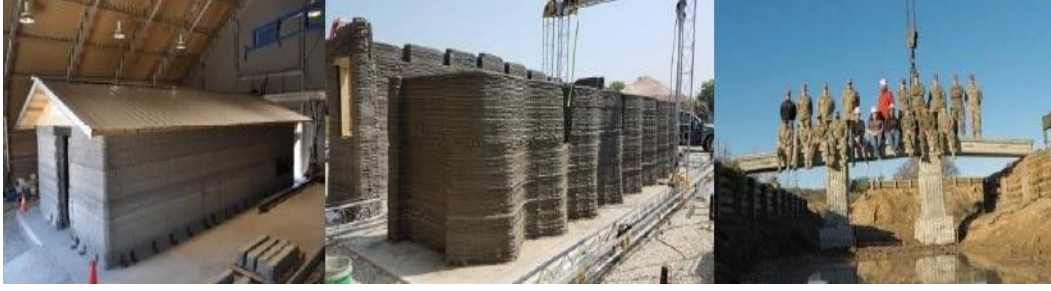
Resim 5.10. ABD Ordusu Mühendisler Birliği tarafından yürütülen ACES Projesi kapsamında inşa edilen 3DPC yapıları
