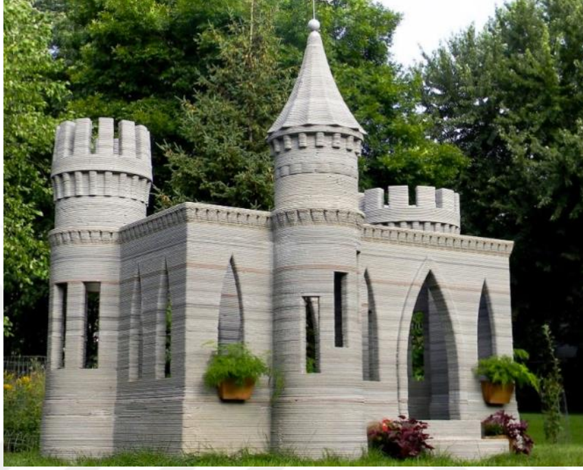
Şekil 5.2 Katmanlı üretim ile yapılan mega şato (TechCrunch)
