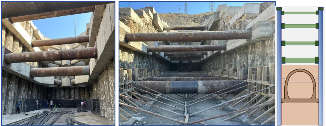
Şekil 4.31. Üçüncü kademe strutların montajı ve kuşak kiriş betonlarının dökümü.
