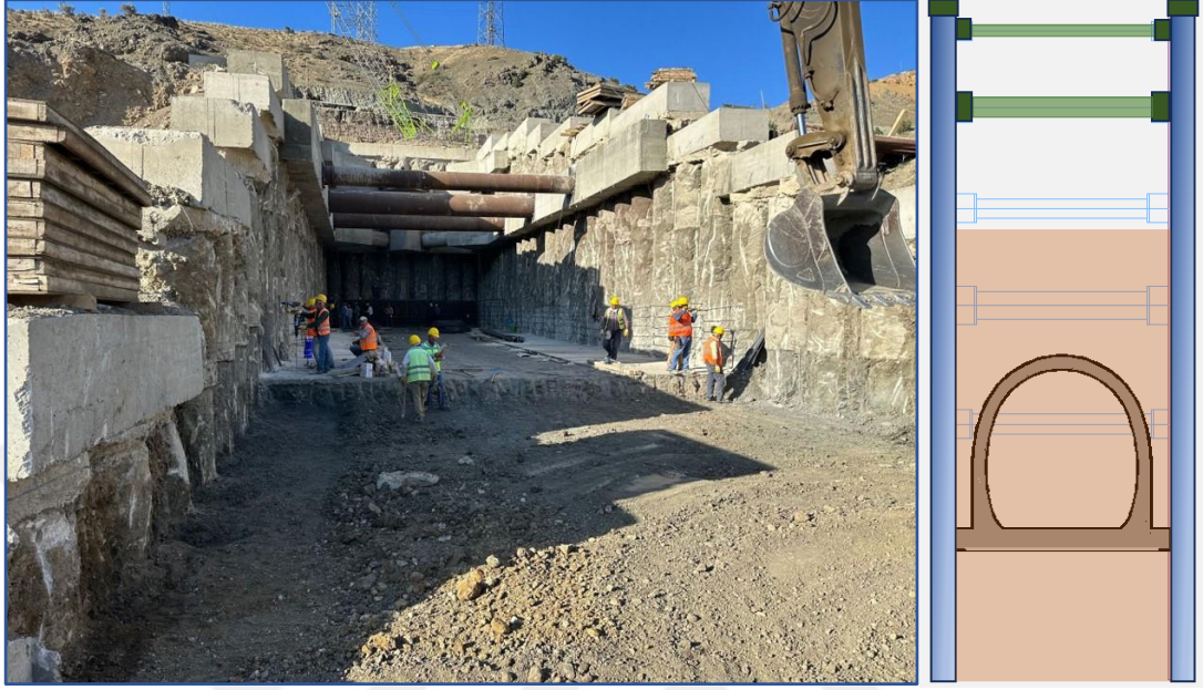
Şekil 4.30. İkinci kademe strutların montajı.
