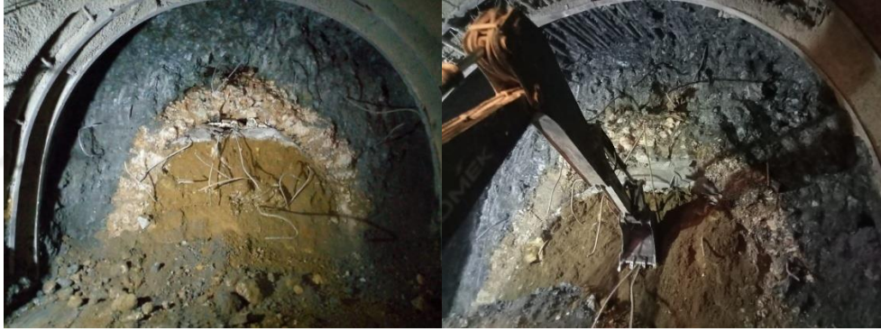
Şekil 4.58. T3 tüneli giriş kesimi kazı destekleme imalatları.
