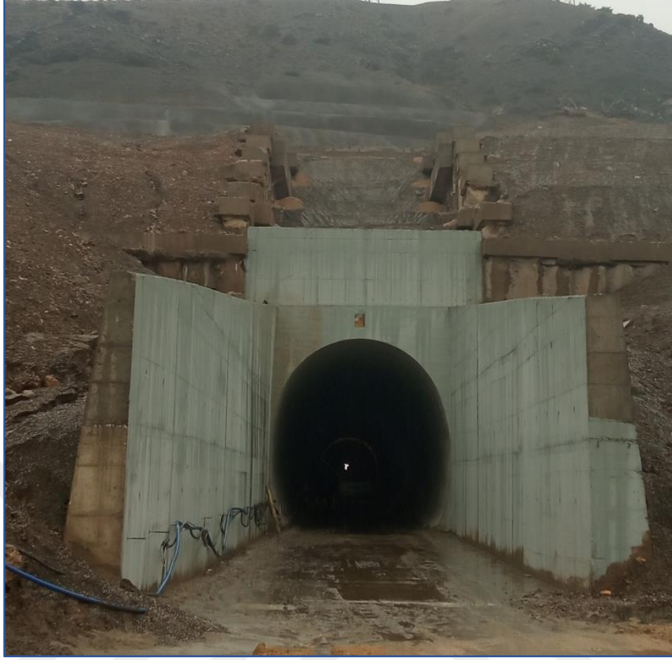
Şekil 4.39. Aç-Kapa yapısı ve istinat duvarı tamamlanmış hali.
