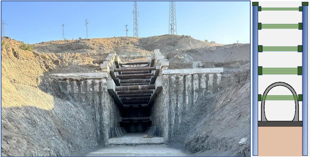
Şekil 4.33. Beşinci sıra strutların montajı ve aç-kapa temel betonunun dökülmesi.
