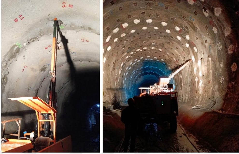
Şekil 4.65. Tünel içi konsolidasyon enjeksiyonu yapılması.
