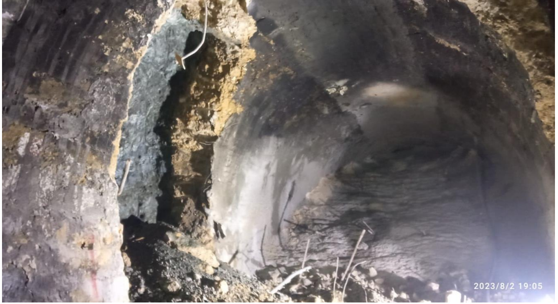
Şekil 4.55. T3 tüneli ilk tarama kazı imalatı.
