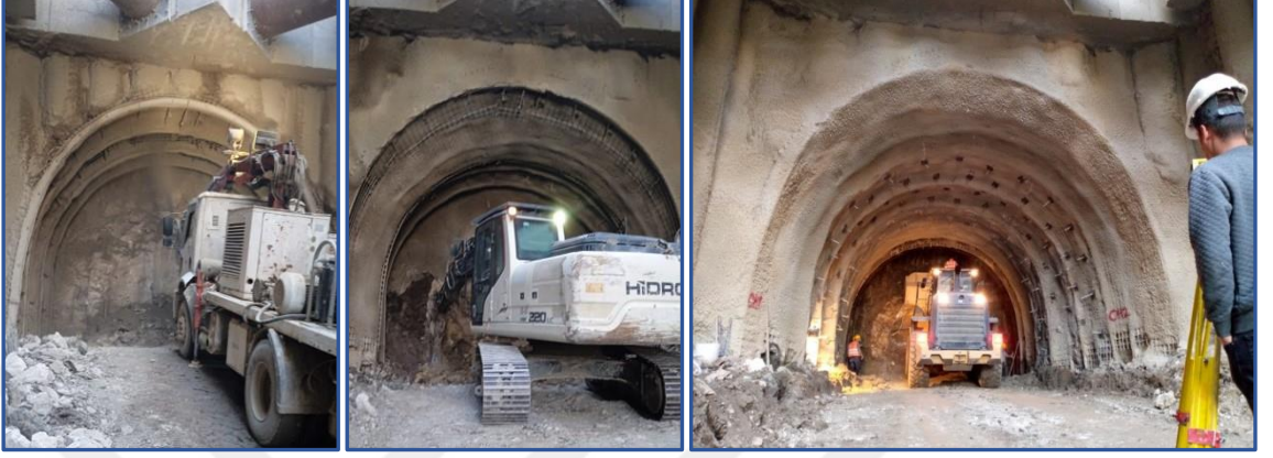
Şekil 4.57. T3 tüneli çıkış kesimi kazı destekleme imalatları.
