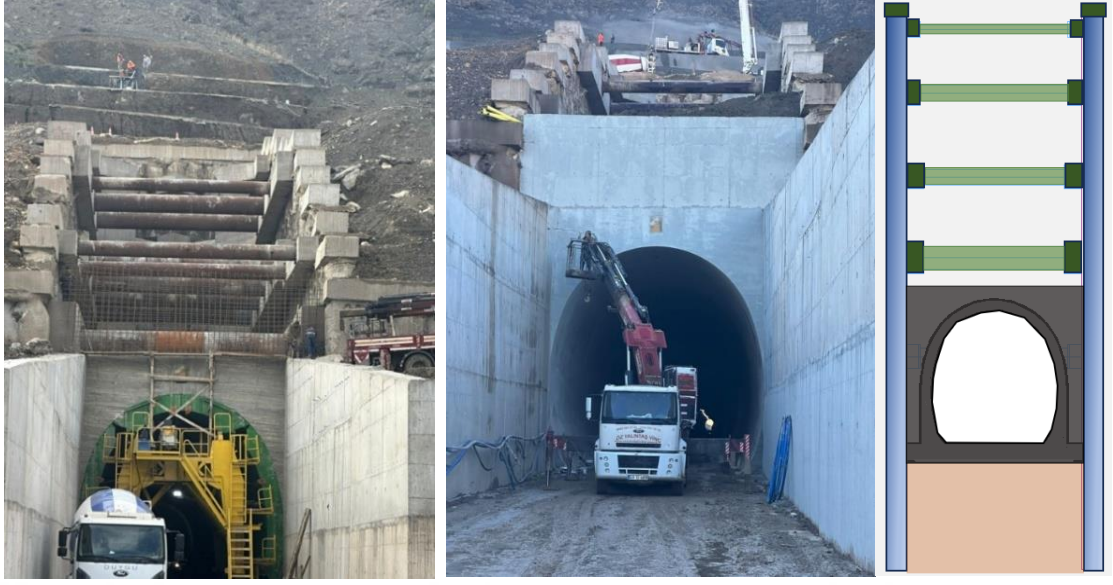
Şekil 4.37. T3 tüneli aç-kapa yapısı ve istinat duvarı betonlarının dökülmesi.
