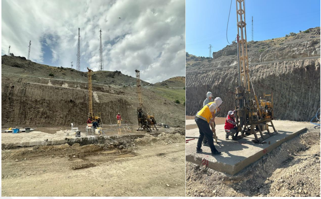
Şekil 4.14. Tünel üzeri enjeksiyon imalat fotoğrafları.
