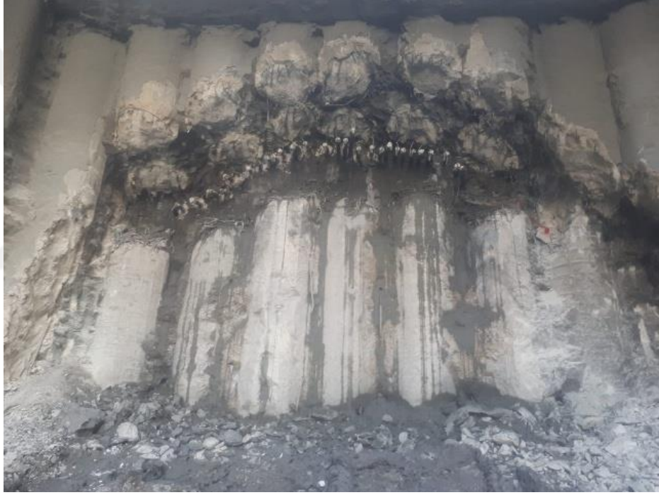
Şekil 4.36. Çıkış aynası kendinden delgili süren imalatı.
