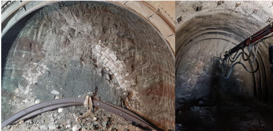
Şekil 4.59. T3 tüneli kazı destekleme imalatları esnasında mevcut taş kaplama tünel.
