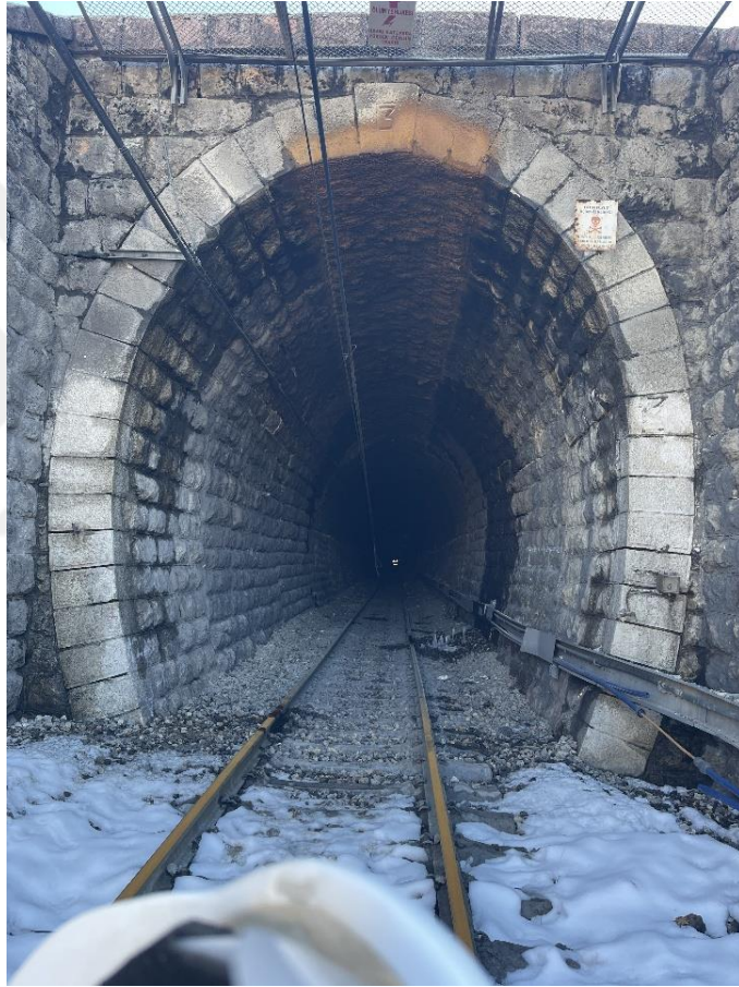
Şekil 3.1. T3 tüneli geometrisi (tünel çıkış portalı).
