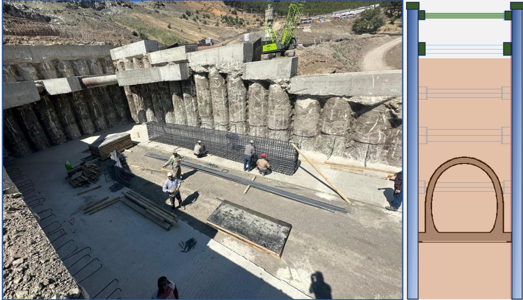
Şekil 4.29. Birinci kademe strutların montajı.
