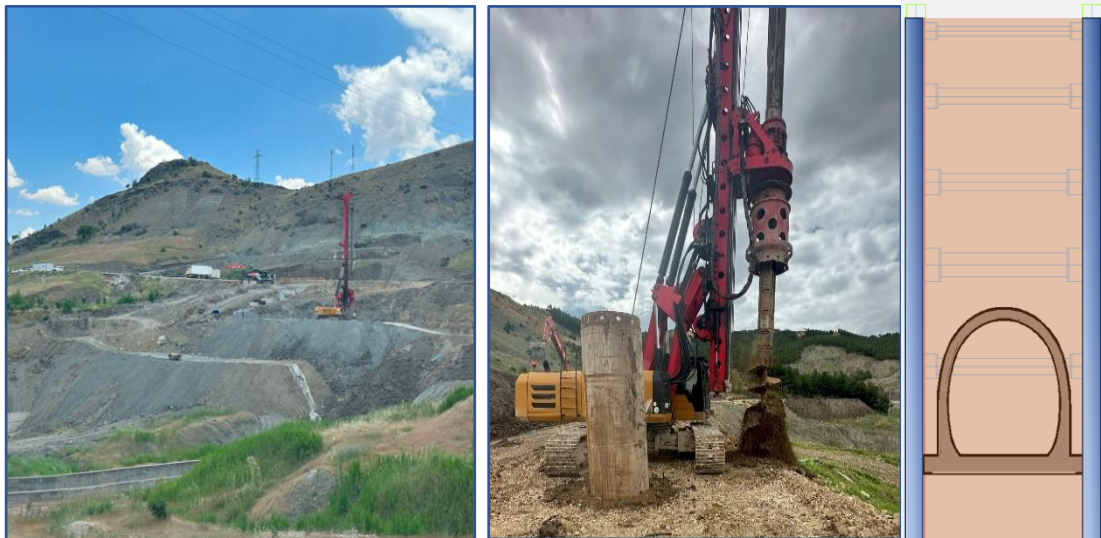
Şekil 4.27. Heyelan tutucu kazık imalatları.
