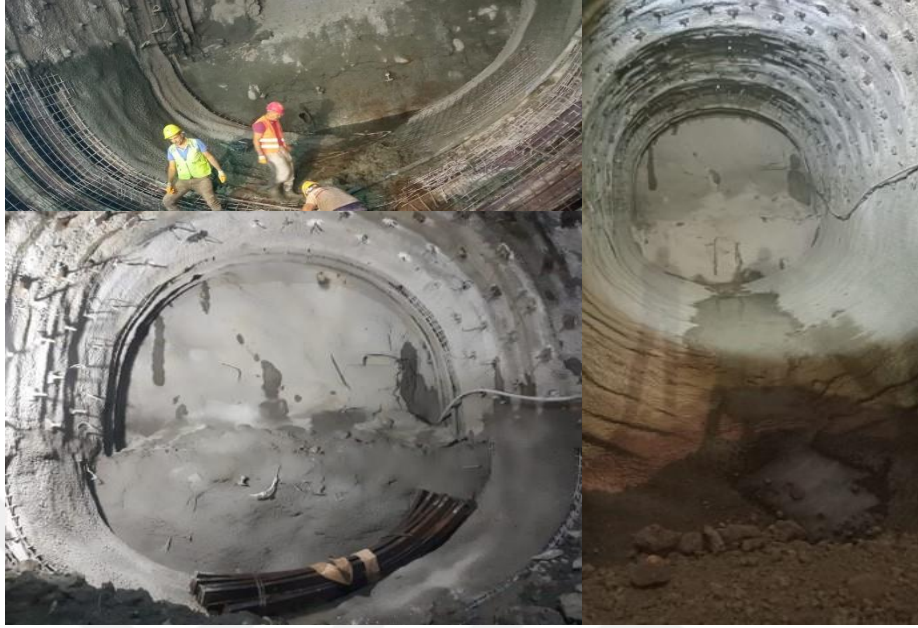
Şekil 4.60. T3 tüneli invert imatları.
