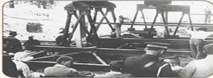
Fotoğraf 4.38: Yalova'daki köşkün kaydırılma çalışmaları (1930)
