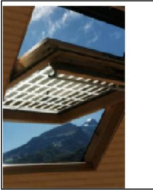
Resim 2.1. Çatı penceresinde PV panel kullanımı (Uğur, 2006)
