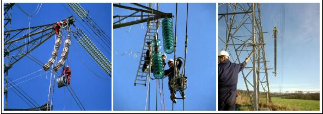
Şekil 2.25. Havai hat çekilmesi [4].
