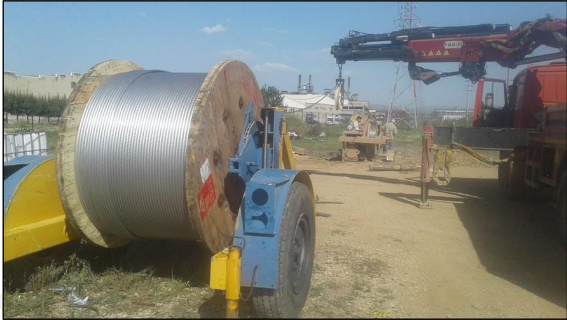
Şekil 4.6. ACCC Lisbon iletken kurulumu
