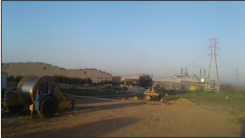
Şekil 2.29.ACCC saha uygulaması iletken kurulumu
