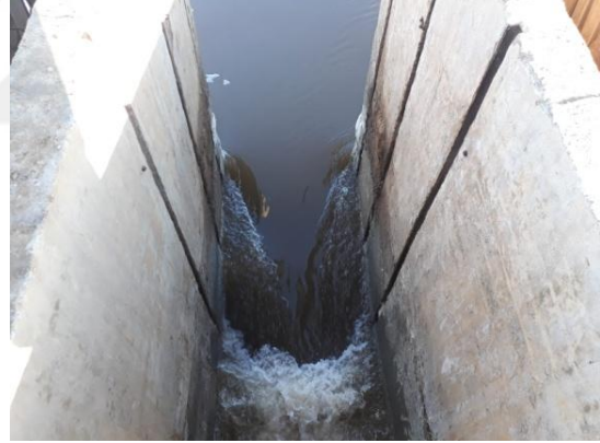
Resim 2.1 Üretim havuzuna ÖBH'dan yüksek Bome'li su alınması (a) ve soğuk hava koşullarında kristalizasyon sonrası üst tuzlu suyun boşaltılması (b).
