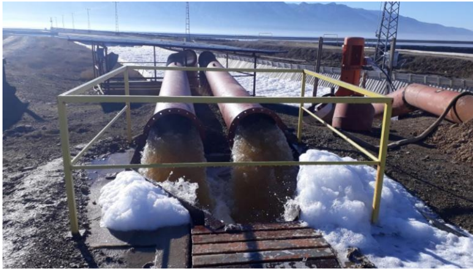
Resim 2.5 Mirabillit kristalizasyonu sonrası tuzlu üst suların sodyum klorür üretim havuzlarına alınması.
