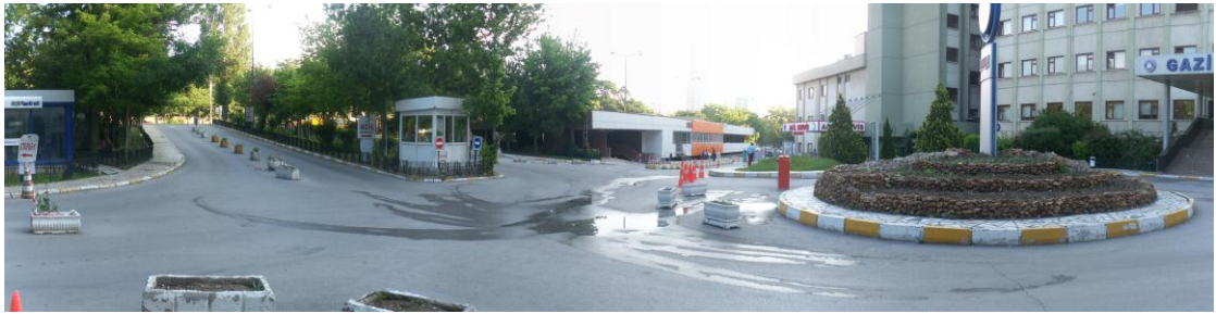
Resim 4.3. Acil servis ünitesine araç ulaşımının sağlandığı yerleşke içi yolları gösteren fotoğraf
