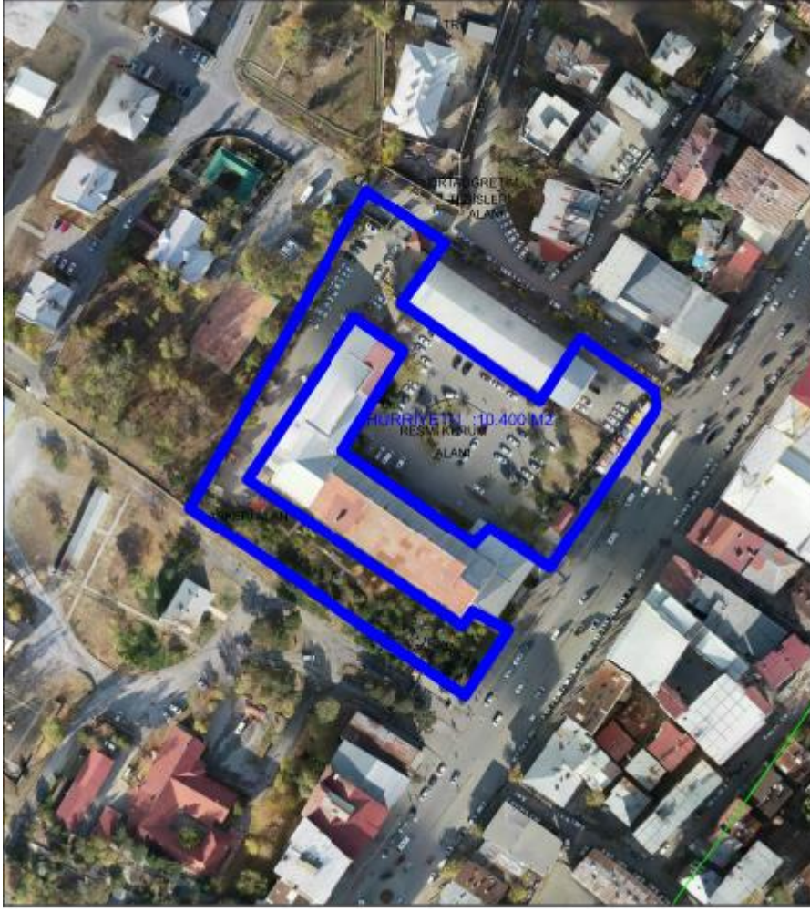
Şekil 5.9. Valilik Hizmet Binası Çevresi ve Bahçesi – Resmi Kurum
