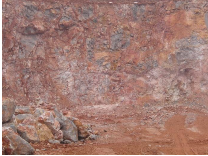
Şekil 4.31 Deney 7' ye ait patlatma aynası görüntüsü.
