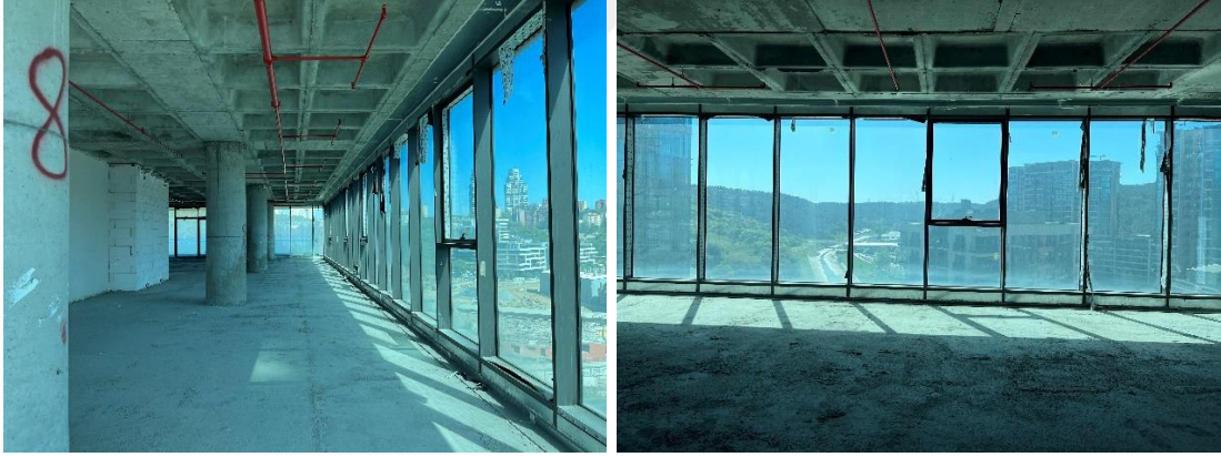
Şekil 21. Örnek Ofisin Bulunduğu Binanın İç Görünümü
