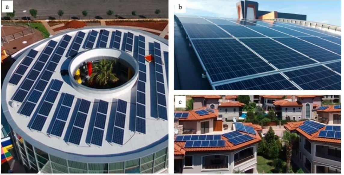
Şekil 2.51. PV panel çatı uygulamaları; a) teras çatı PV sistemler, b) entegre PV sistemler, c) monte PV sistemler (Anonim 3)
