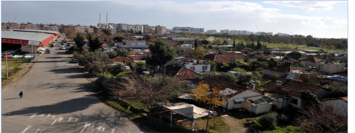
Şekil 4.5. Gülveren Mahallesi kentsel dönüşüm öncesi görüntüsü (3) (Anonim 29)
