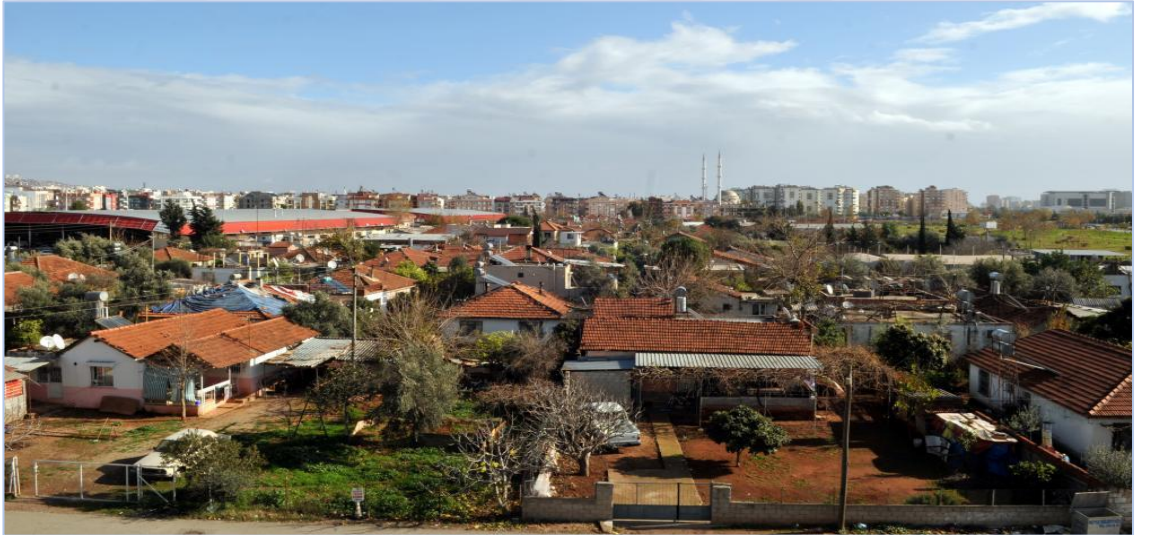
Şekil 4.4. Gülveren Mahallesi kentsel dönüşüm öncesi görüntüsü (2) (Anonim 29)
