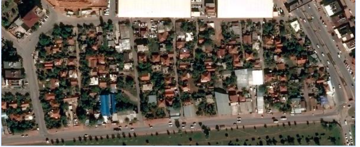
Şekil 4.3. Gülveren Mahallesi kentsel dönüşüm öncesi görüntüsü (1) (Anonim 28)
