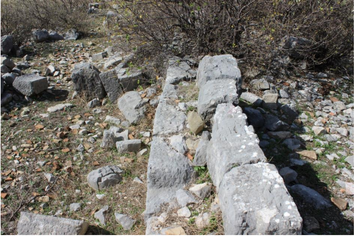
Fotoğraf 312 Kayabaşı 3. nolu Kilise güney duvarı malzeme ve teknik
