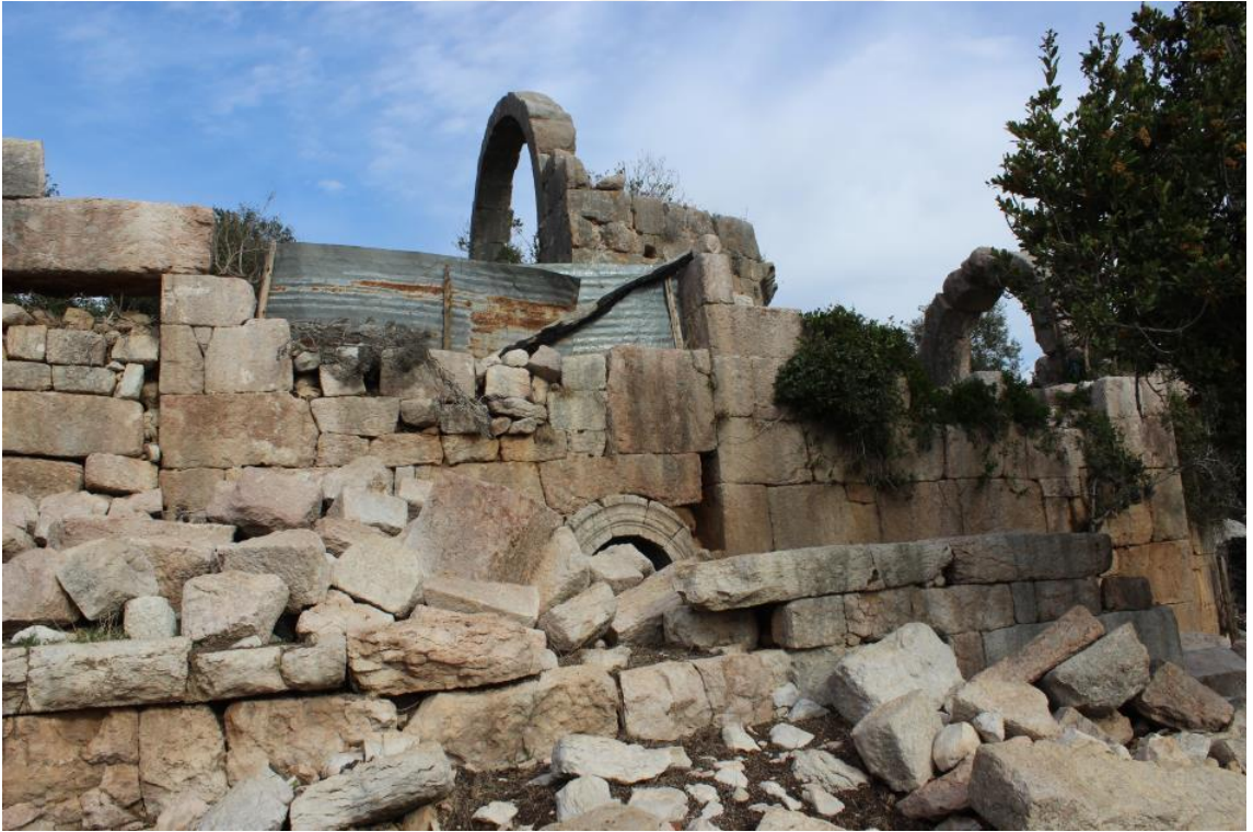
Fotoğraf 372 Mazılık Kilisesi güney cephesinin doğu bölümü
