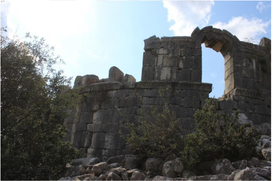
Fotoğraf 44. Akören Kuzey Kilisesi doğu cephesi
