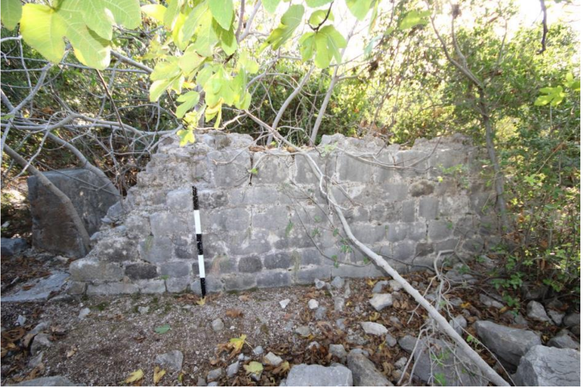
Fotoğraf 222. Ilıca Köyü 2. Nolu Kilise kuzey duvarı
