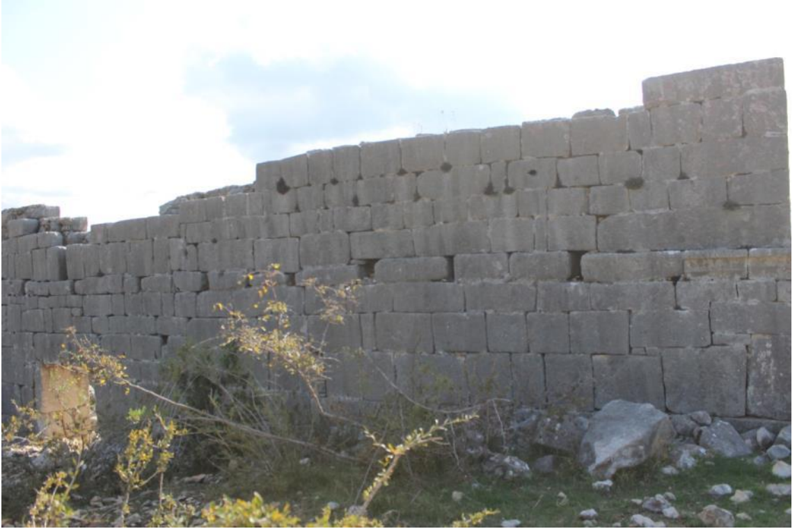
Fotoğraf 24. Akören Güney Kilisesi kuzey cephesinin görünüşü
