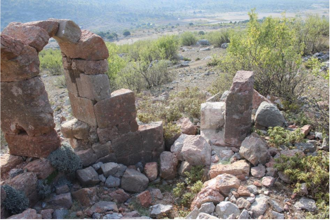
Fotoğraf 202 Gireğiyeniköy Kızılkilise apsisinin güney bölümü
