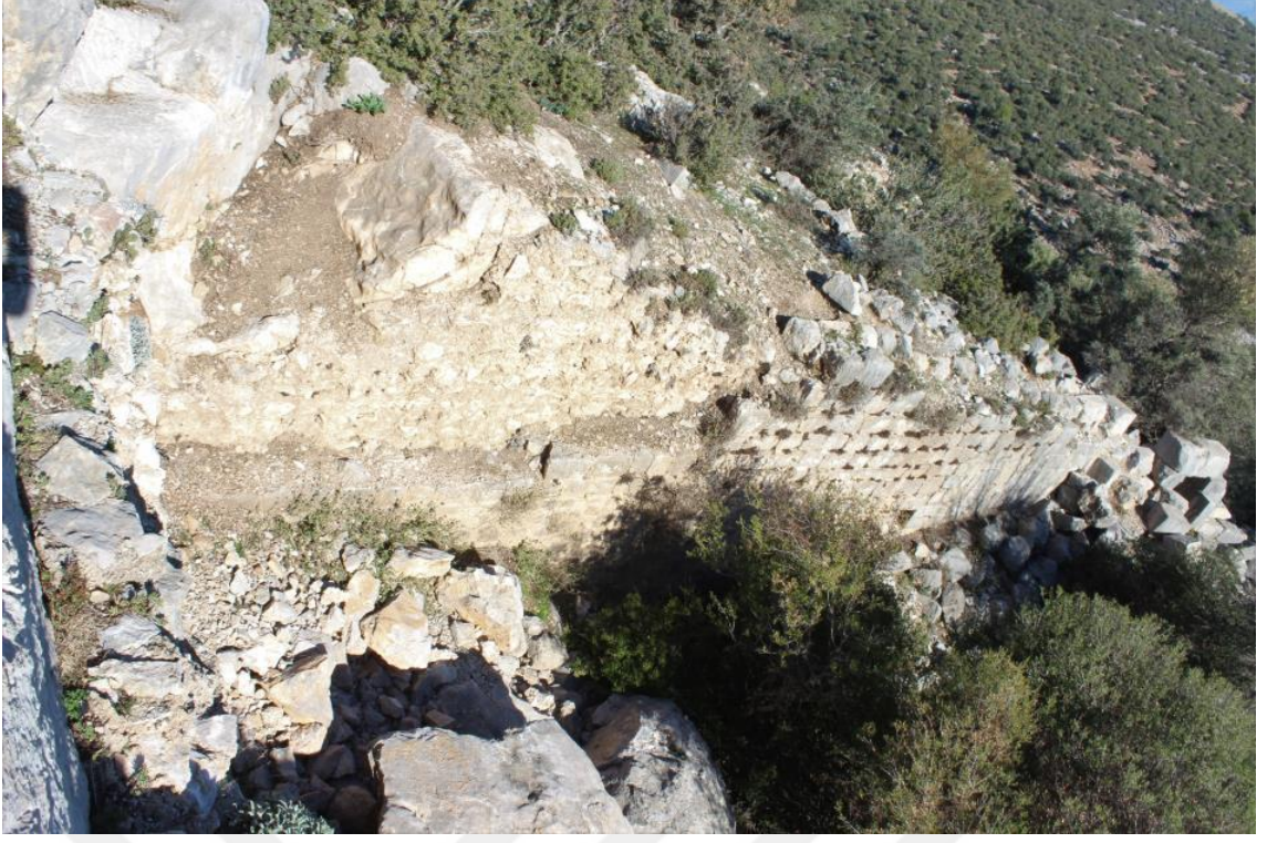
Fotoğraf 413 Perikalesi 2. nolu Kiliseye güneybatı köşeden bakış ve kuzey duvarı
