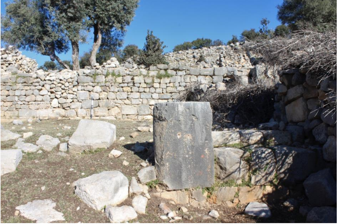
Fotoğraf 396 Perikalesi 1. nolu Kilise güney duvarı ve kapı sövesi kalıntısı
