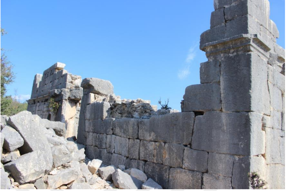
Fotoğraf 19. Akören Güney Kilisesi güneybatıdan batı cephesi
