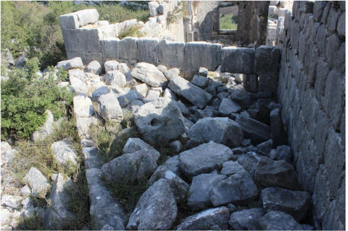
Fotoğraf 40. Akören Kuzey Kilisesi kuzey cephesindeki kalıntılar
