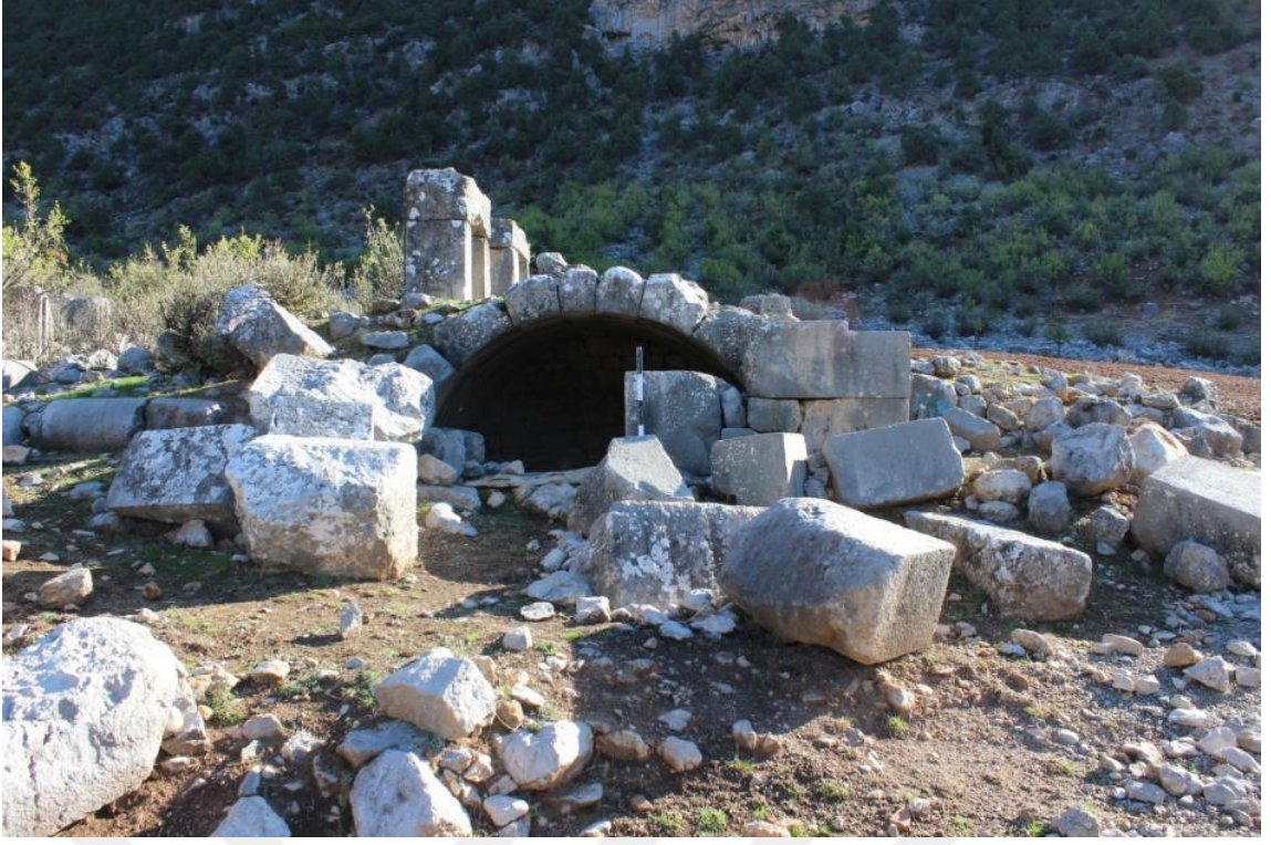
Fotoğraf 131 Cumhuriyet 1. nolu Kilise batıdan bakış. Tonozlu mekan eğimden dolayı kilisenin alt kotundadır
