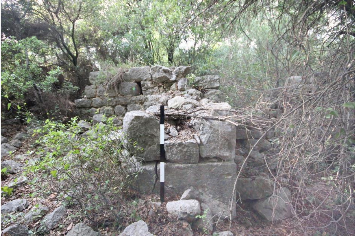
Fotoğraf 344. Mahyalar Köyü 2. Nolu Kilise kuzey duvarı açıklık izi
