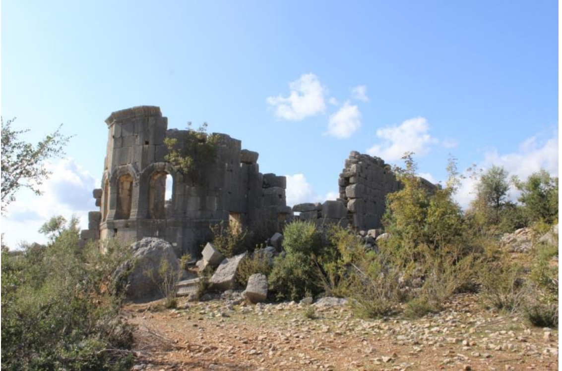
Fotoğraf 16. Akören Güney Kilisesi kuzeydoğudan genel bakış
