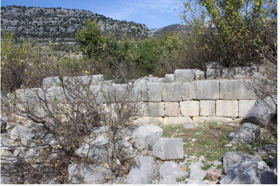
Fotoğraf 309 Kayabaşı 3. nolu Kilise güney duvarı
