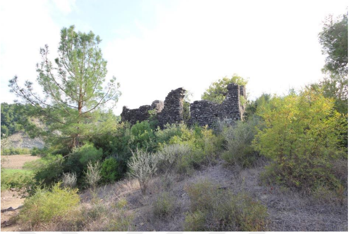
Fotoğraf 149. Eğlence Köyü Yapı kompleksi Kuzey cephe
