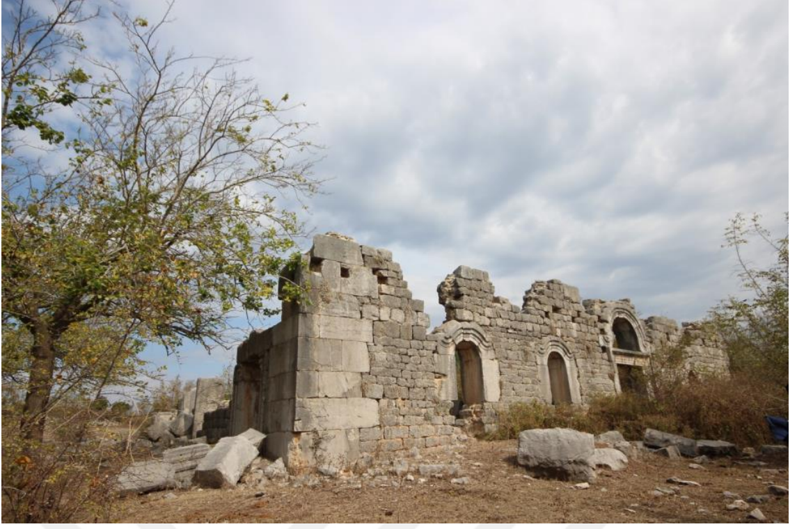
Fotoğraf 205. Ilıca Köyü 1. Nolu Kilise güney cephesi
