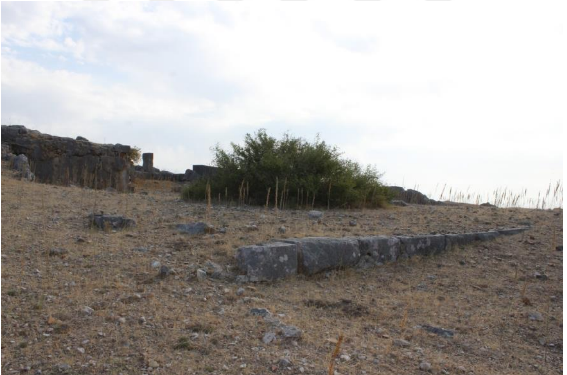
Fotoğraf 96 Anazarbos Ekstra Muros (Kaya) Kilisesi kuzeybatı köşesi duvar kalıntısı
