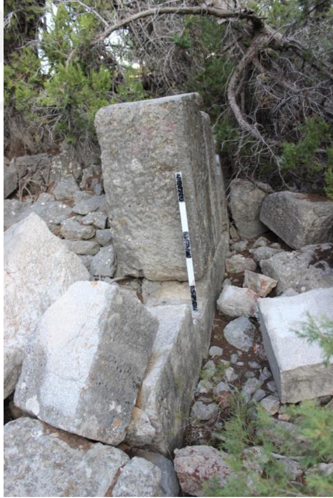
Fotoğraf 166 Ergenuşağı Alakilise güney beden duvarı kalıntısı
