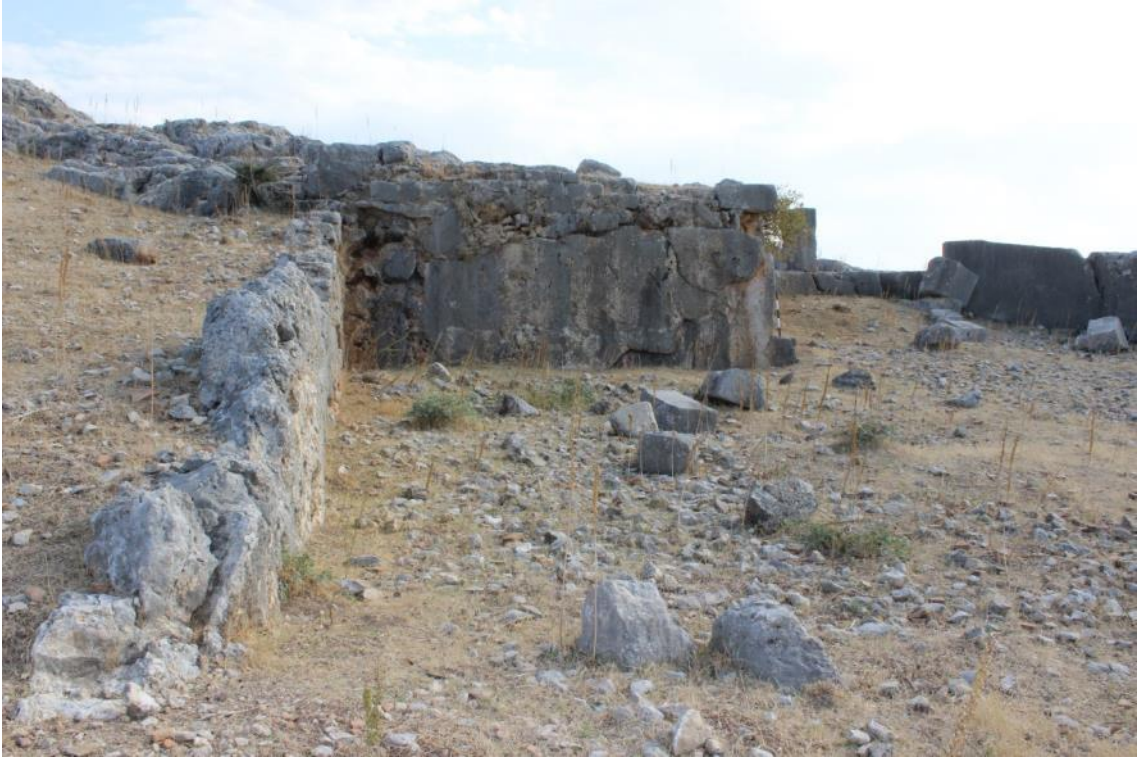
Fotoğraf 98 Anazarbos Ekstra Muros (Kaya) Kilisesi batıdan kuzey duvarına ve kuzey nefe bakış
