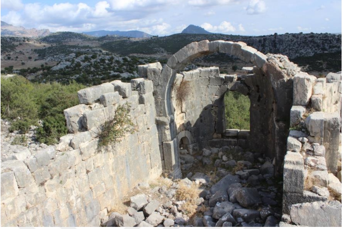
Fotoğraf 51. Akören Kuzey Kilisesi ek şapelin apsisine bakış
