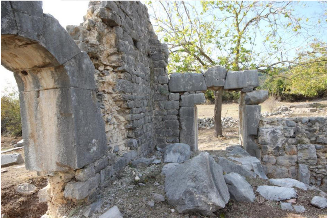
Fotoğraf 214. Ilıca Köyü 1. Nolu Kilise güneybatı köşeye içeriden bakış
