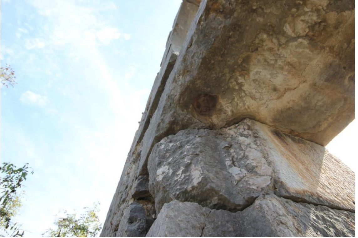
Fotoğraf 220. Ilıca Köyü 1. Nolu Kilise güney kapısında kapı mili izleri
