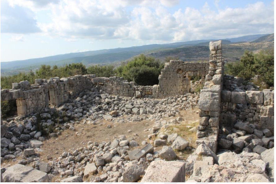
Fotoğraf 47. Akören Kuzey Kilisesi kuzeydoğu köşeden naosa bakış
