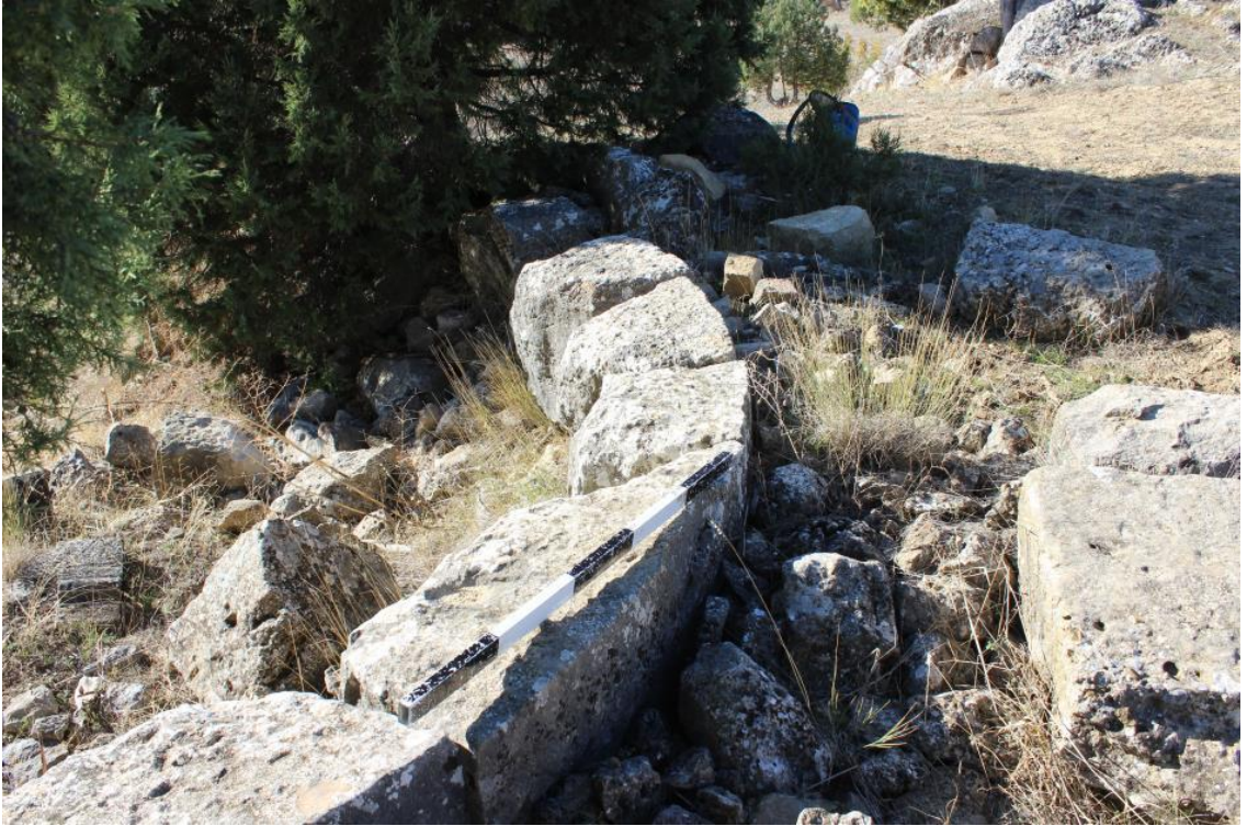
Fotoğraf 436 Yardibi Kilisesi apsisine güneyden bakış
