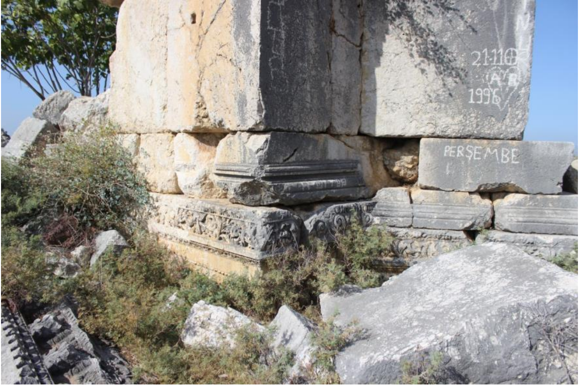
Fotoğraf 64. Anazarbos Oniki Havari Kilisesi güneydoğu köşesi devşirme malzeme kullanımı.
