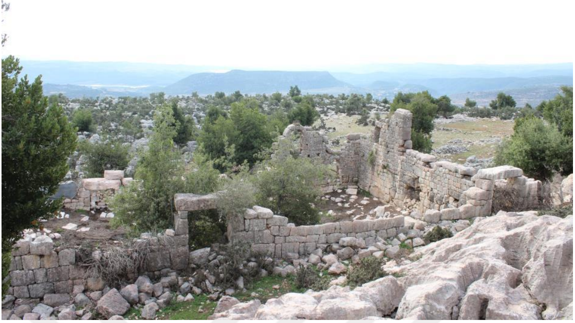
Fotoğraf 363 Mazılık Kilisesi kuzey cephesinin kısmi görünüşü
