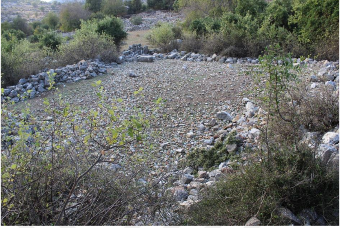
Fotoğraf 283 Kayabaşı 1. nolu Kilise kuzeydoğudan naos, batıya ve güney duvarı yıkıntılarına bakış
