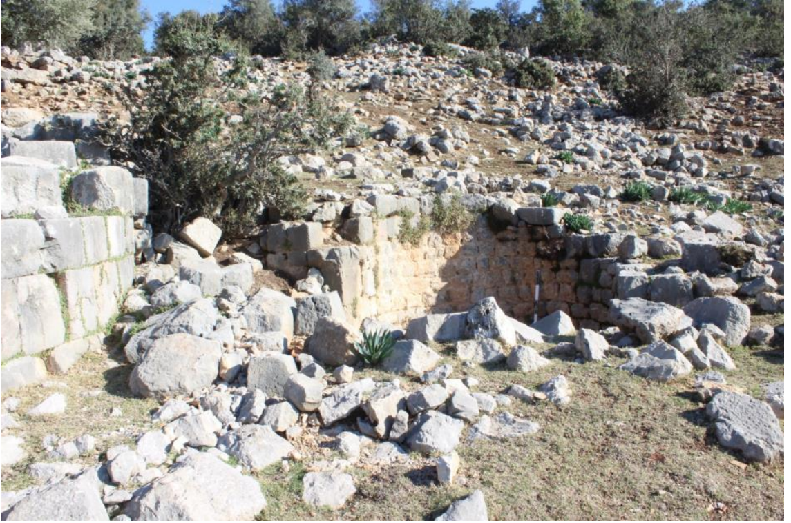
Fotoğraf 406 Perikalesi 1. nolu Kilise güney şapeline batıdan bakış
