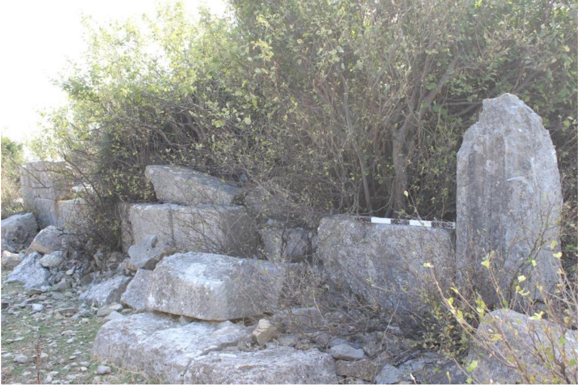
Fotoğraf 302 Kayabaşı 3. nolu Kilise kuzey cephedeki kapı sövesi ve duvarın görünümü
