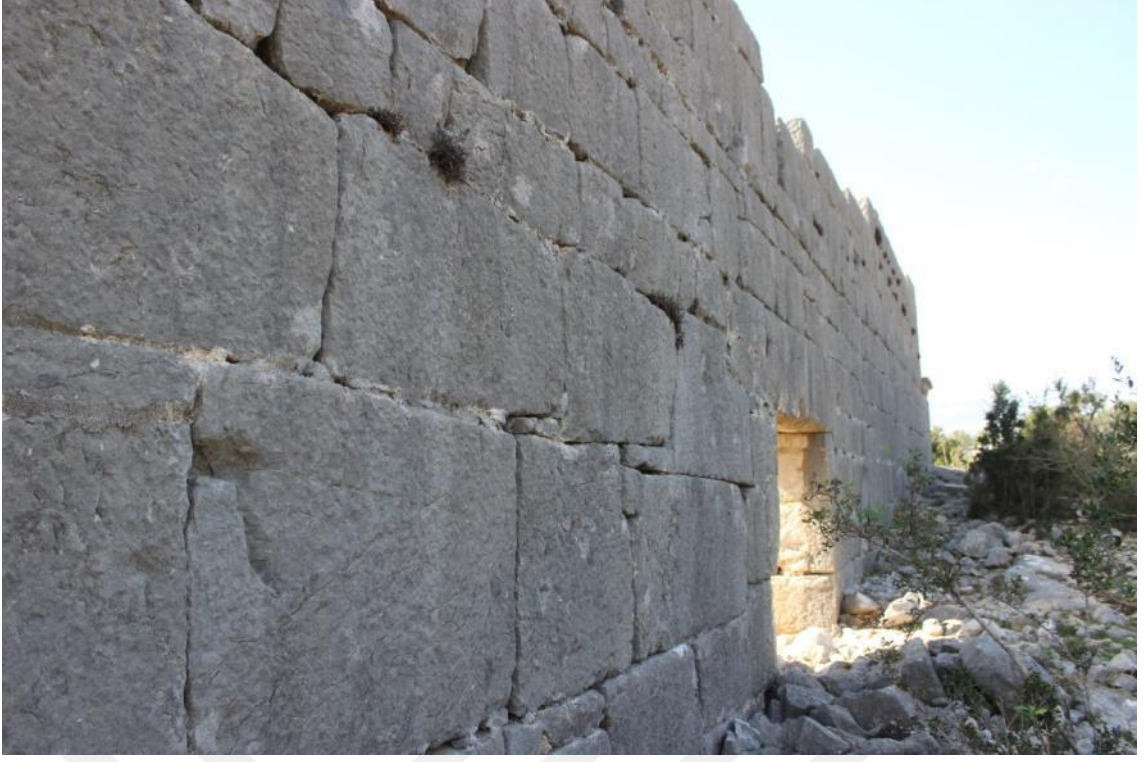
Fotoğraf 23. Akören Güney Kilisesi kuzey cephesinin görünüşü
