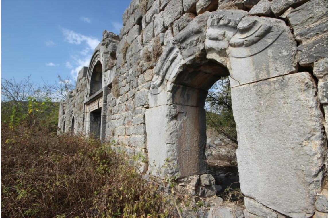
Fotoğraf 210. Ilıca Köyü 1. Nolu Kilise güney cephesi
