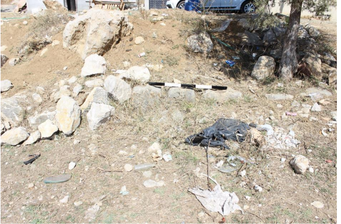
Fotoğraf 447. Yukarıkardak Kilisesinin günümüze ulaşan kuzey duvar izleri.
