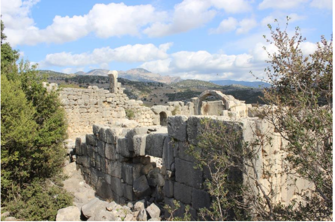
Fotoğraf 34. Akören Kuzey Kilisesi güneybatı köşesinin görünüşü
