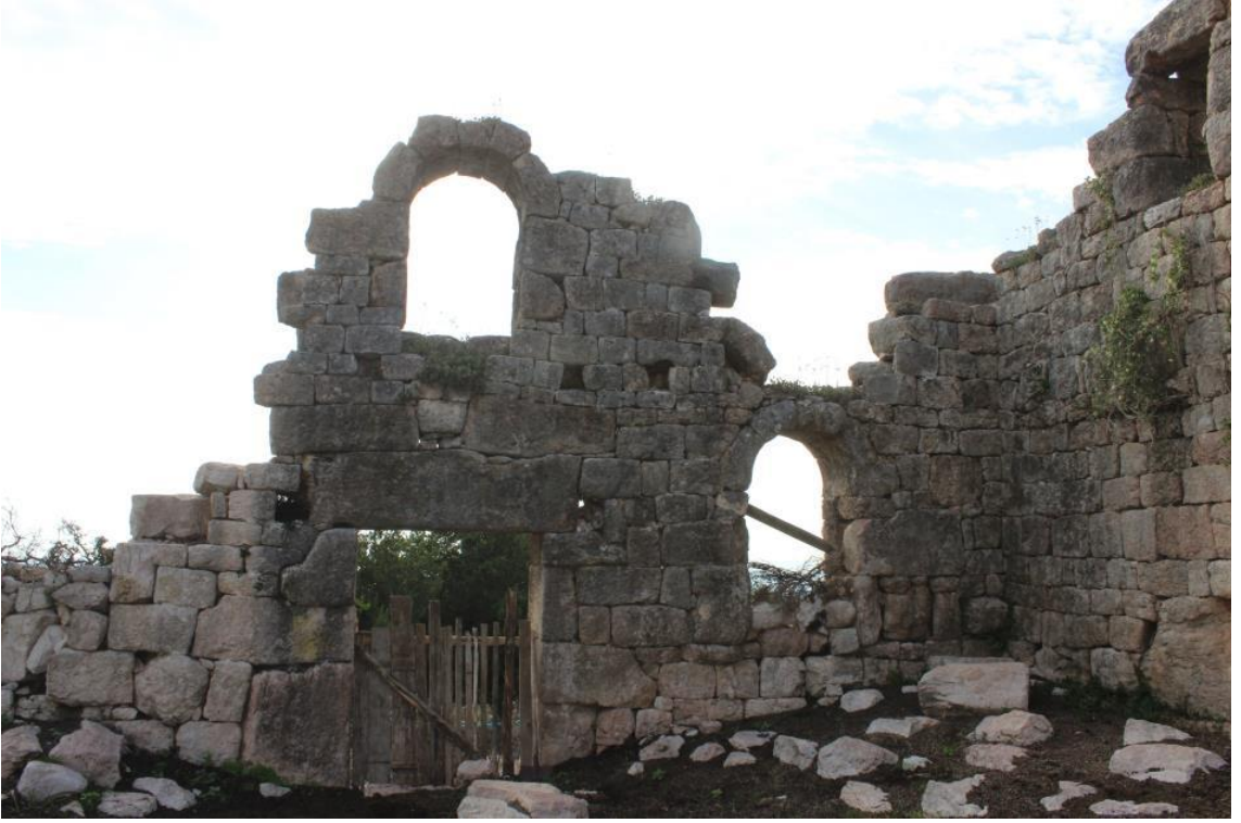
Fotoğraf 382 Mazılık Kilisesi güney ve batı duvarlarının kesişimi içeriden görünüm
