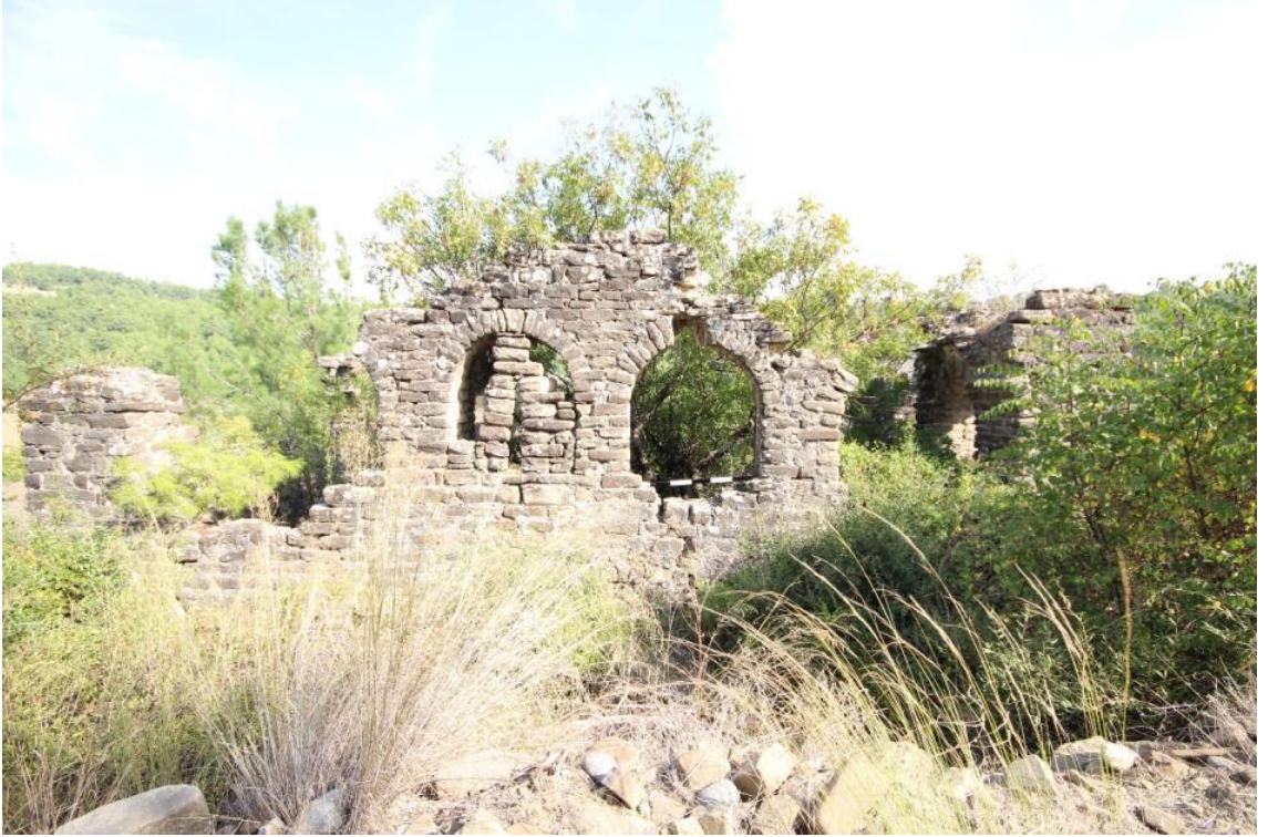
Fotoğraf 150. Eğlence Köyü Yapı kompleksi Batı cephe
