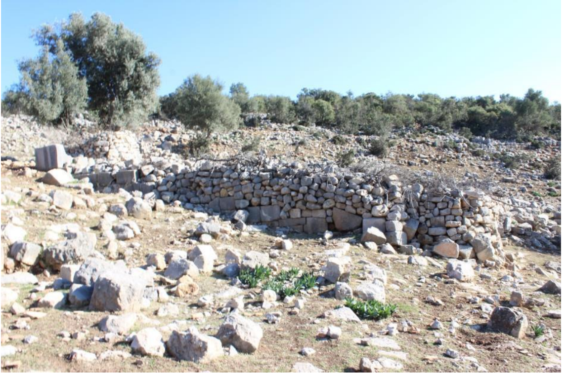
Fotoğraf 394 Perikalesi 1. nolu Kilise batı cephesi genel görünümü
