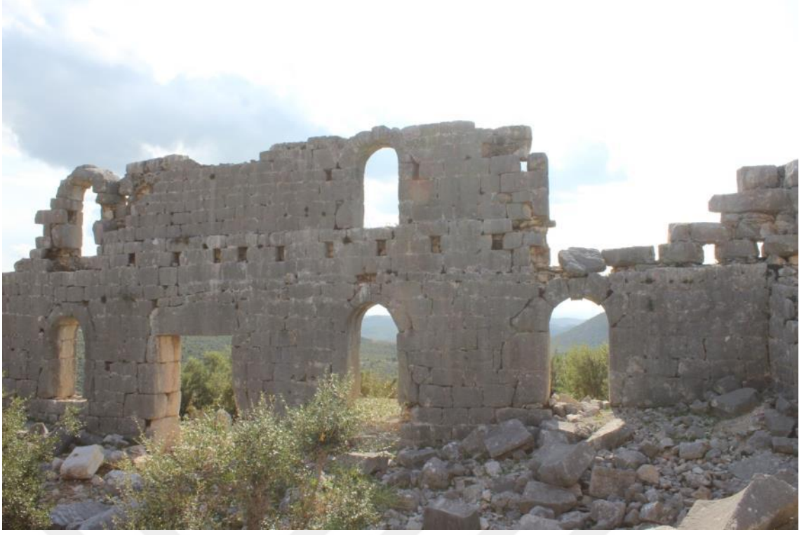
Fotoğraf 31. Akören Güney Kilisesi naostan güney duvarın görünüşü
