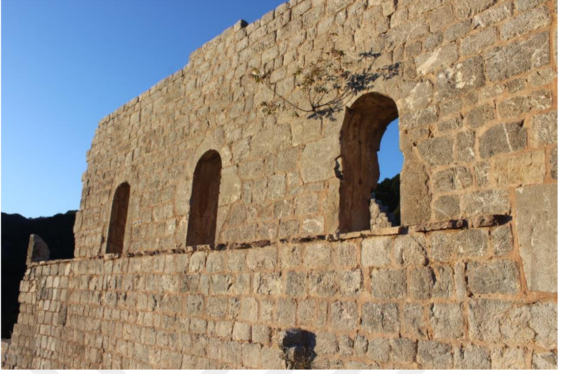
Fotoğraf 243 Karakilise 1. nolu Kilise güney cephenin pencere açıklıkları
