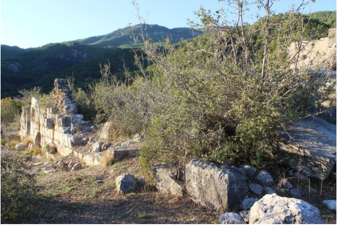
Fotoğraf 256 Karakilise 2. nolu Kilise güney duvarı
