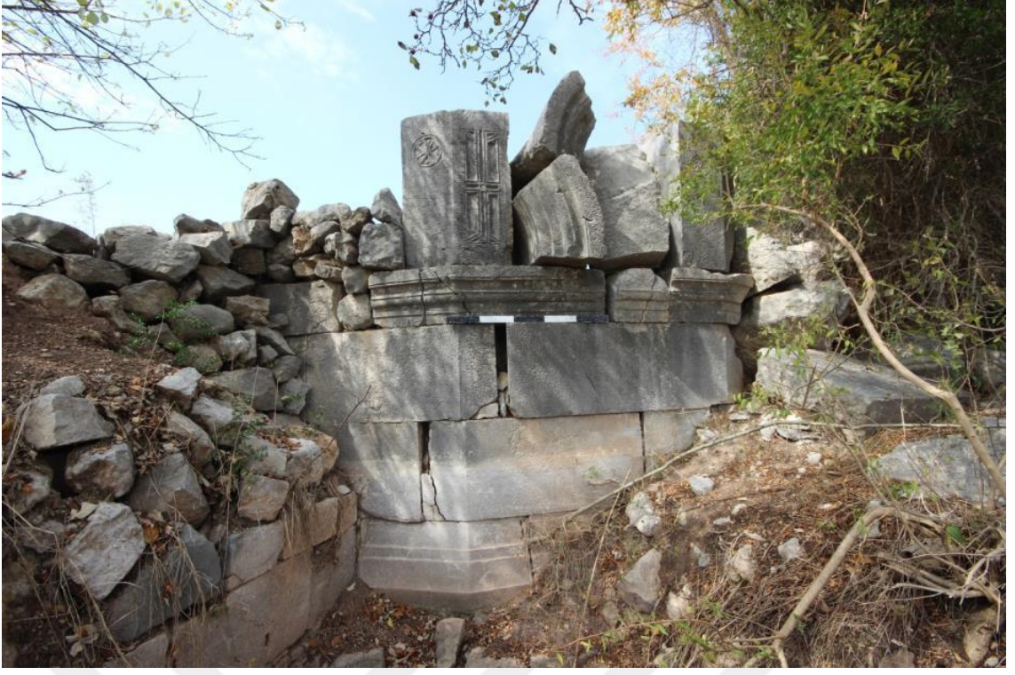
Fotoğraf 215. Ilıca Köyü 1. Nolu Kilise apsis dış cephesi
