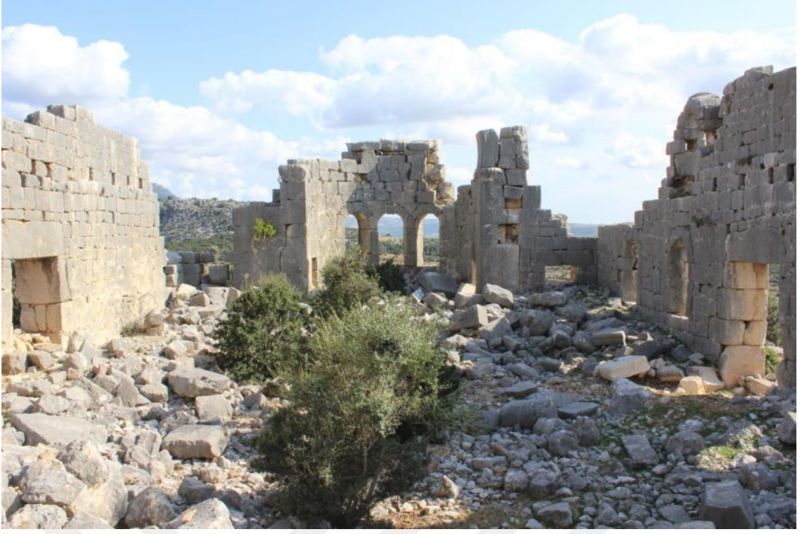
Fotoğraf 29. Akören Güney Kilisesi batıdan naosa ve apsise bakış
