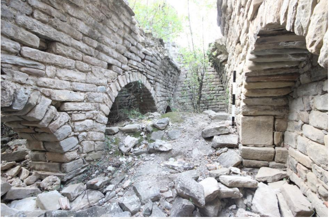
Fotoğraf 151. Eğlence Köyü Yapı kompleksi zemin kat iç görünümü
