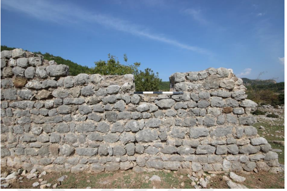
Fotoğraf 179 Ferhatlı Köyü Kilisesi kuzey duvarı detayı
