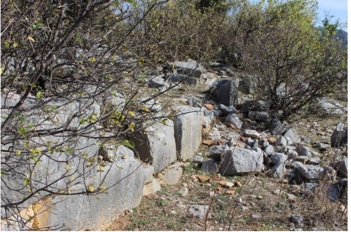
Fotoğraf 310 Kayabaşı 3. nolu Kilise güney duvarı kalıntıları
