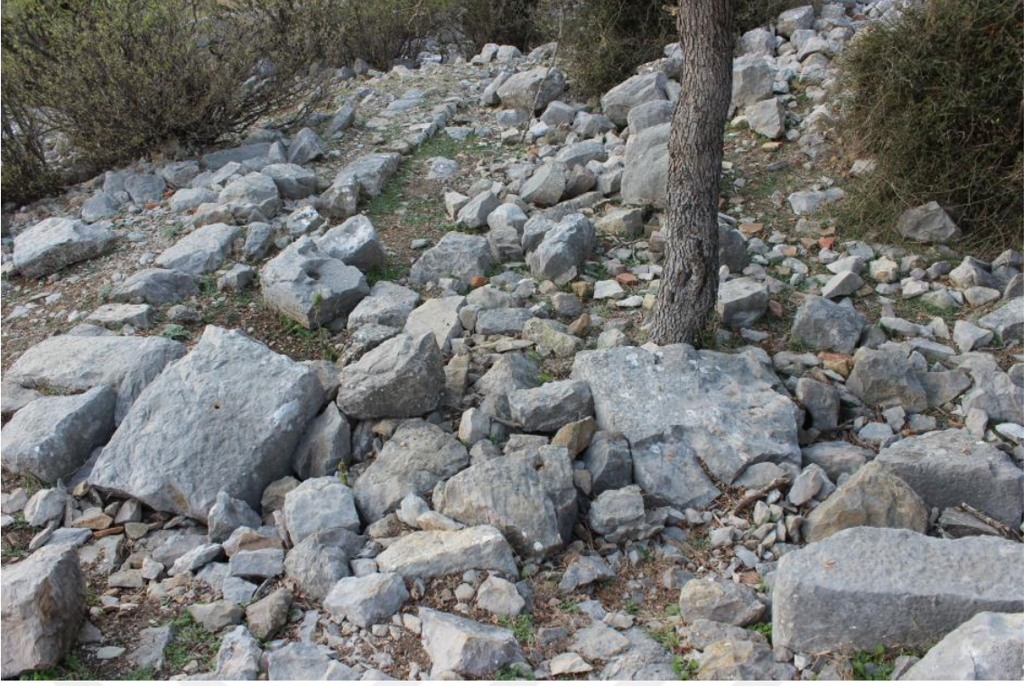
Fotoğraf 291 Kayabaşı 2. nolu Kilise güney duvarı kalıntıları ve naos
