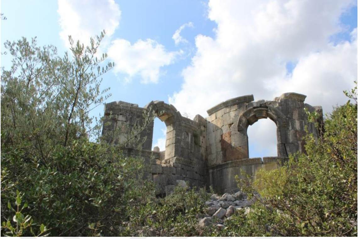
Fotoğraf 41. Akören Kuzey Kilisesi doğu cephesi
