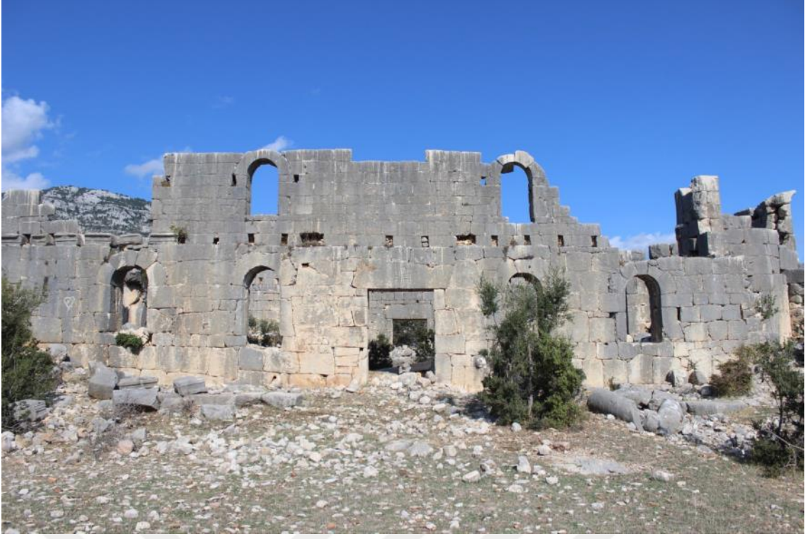
Fotoğraf 17. Akören Güney Kilisesi güney cephesi
