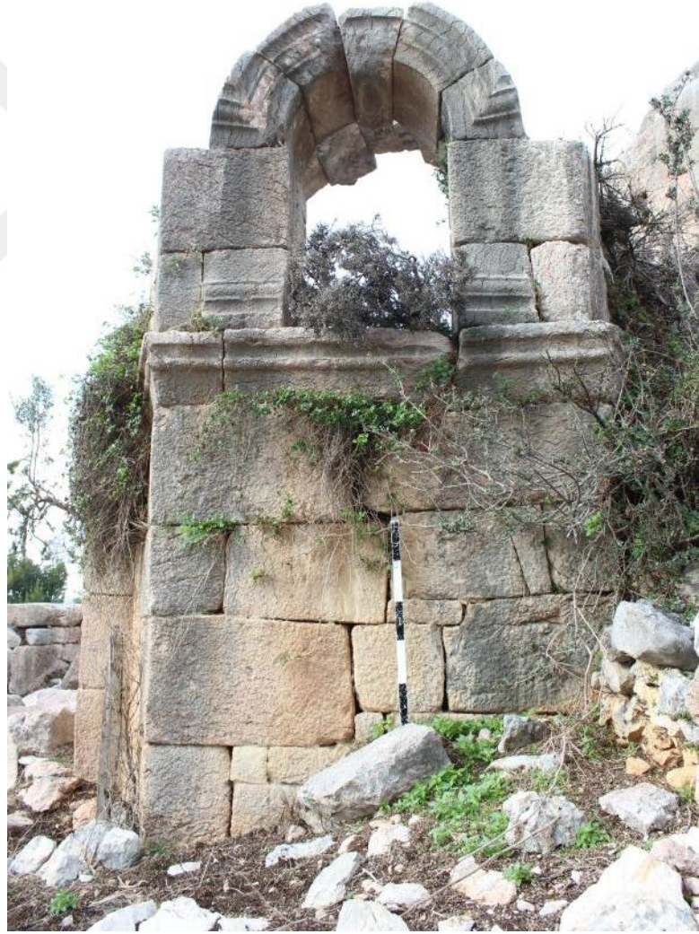
Fotoğraf 374 Mazılık Kilisesi diakonikon mekanının doğu cephesi
