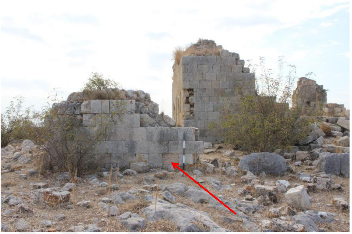
Fotoğraf 71. Anazarbos Bizans Şapeli Kuzeyden görünüş
