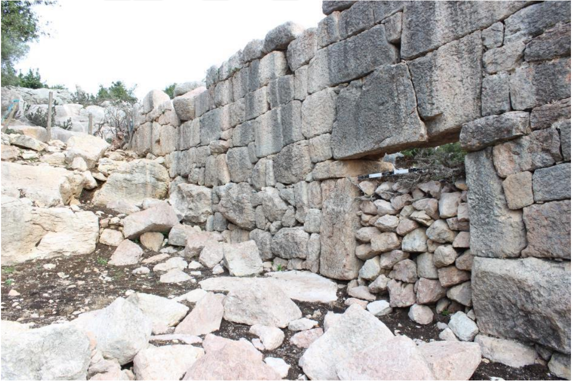
Fotoğraf 368 Mazılık Kilisesi batı cephesinden kuzeye doğru bakış
