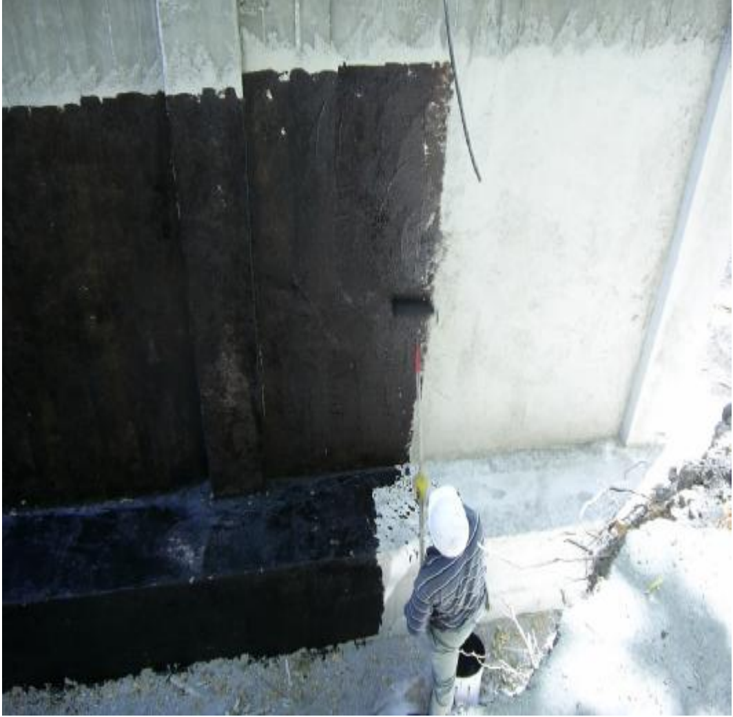
Şekil 4.1. İnşaat Kurallarına Uygun Yapılan Depo Temeli (Su Yalıtımı)
