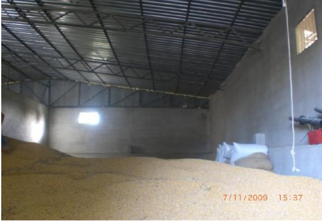
Şekil 3.3. Ölçüm Yapılan Çift Bölmeli(1.Depo, 2.Bölme) Deponun İç Görünümü
