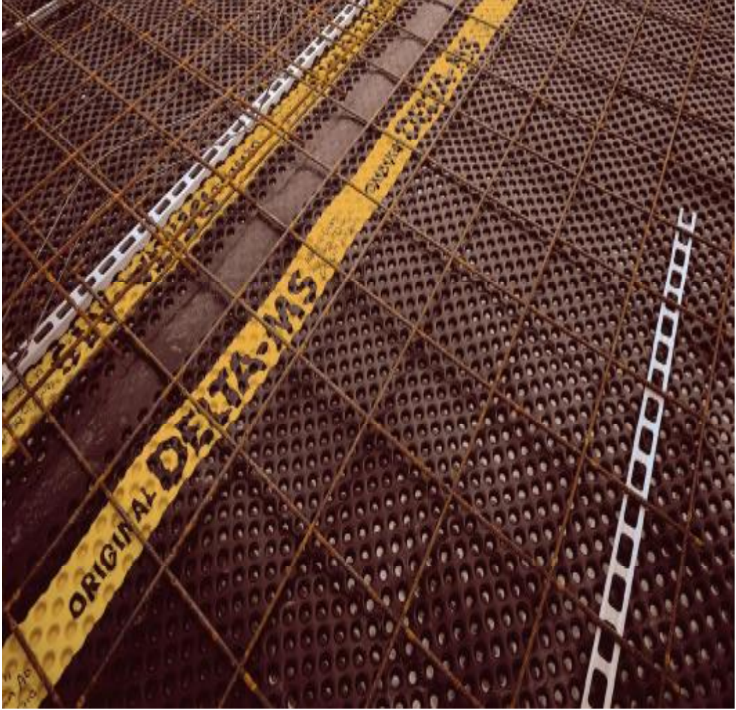
Şekil 4.7. Temelde Su ve Isı yalıtımı Üzerine Yapılmış Hasırlı Demir Döşeme(Hasır Donatı Yapıldıktan Sonra Üzerine 15-20 cm. Kalınlığında Olacak Şekilde Beton(C-20) Dökülmüş)
