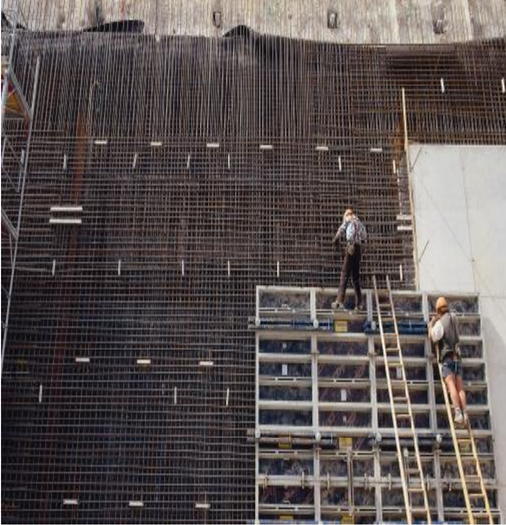
Şekil 4.8. Depo Duvarları Yapılışı(Demir Donatılı Duvar)
