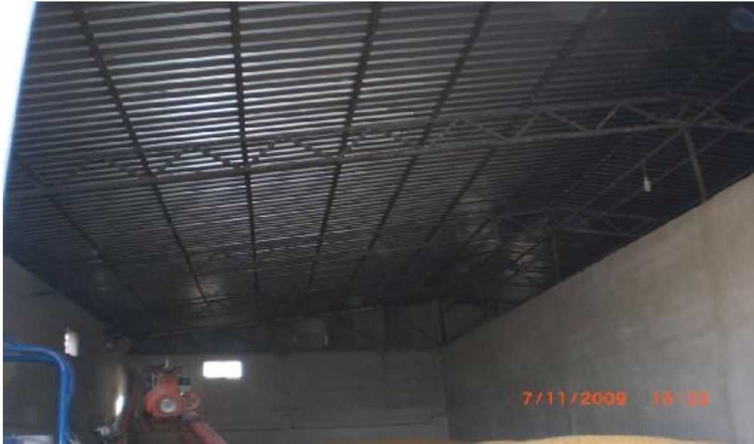
Şekil 3.4. Ölçüm Yapılan Çift Bölmeli(1.Depo) Deponun İç Görünümü(Çatı İç Görünümü)
