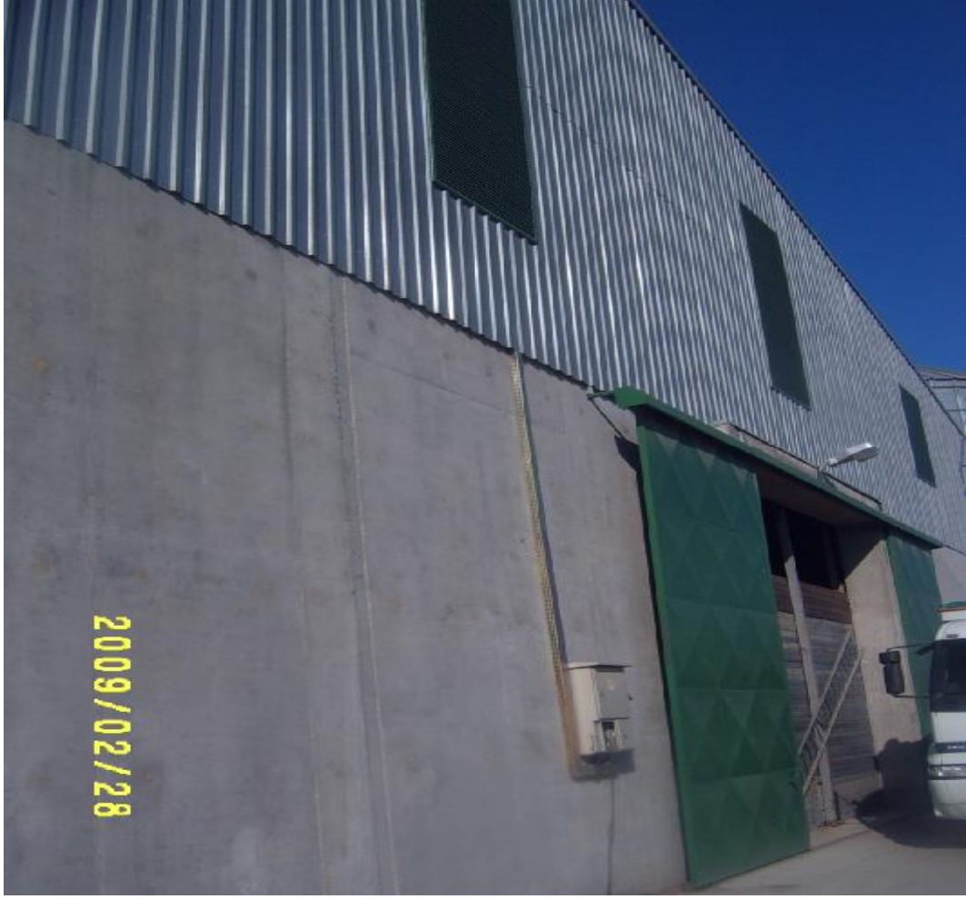
Şekil 3.8. 2. ve 3. Deponun Arkadan Görünüşü/Duvarlar Demirli Betonarme (Taşıyıcı Sistem)
