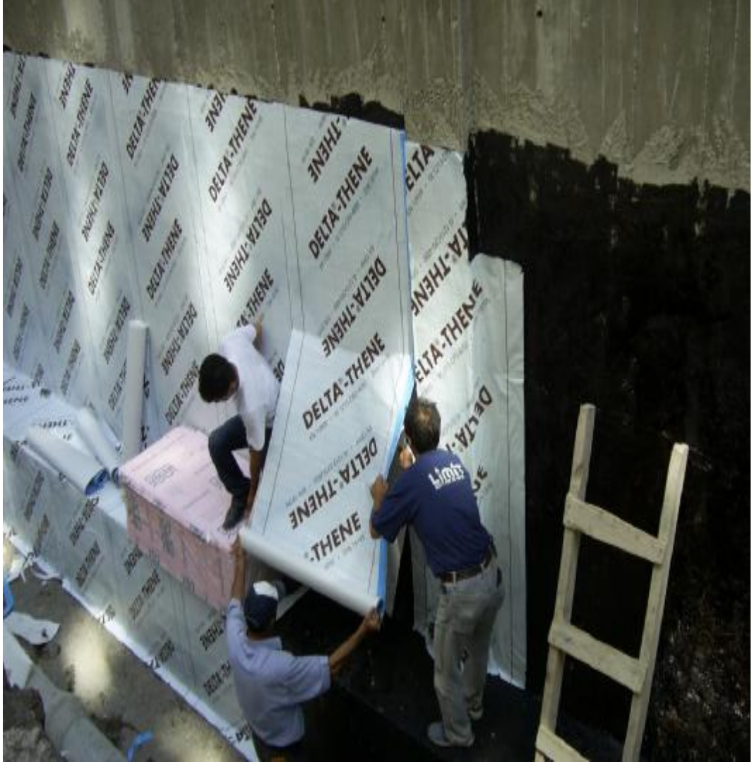
Şekil 4.3. İnşaat Kurallarına Uygun Yapılan Depo Temeli(Su ve Isı Yalıtımı)
