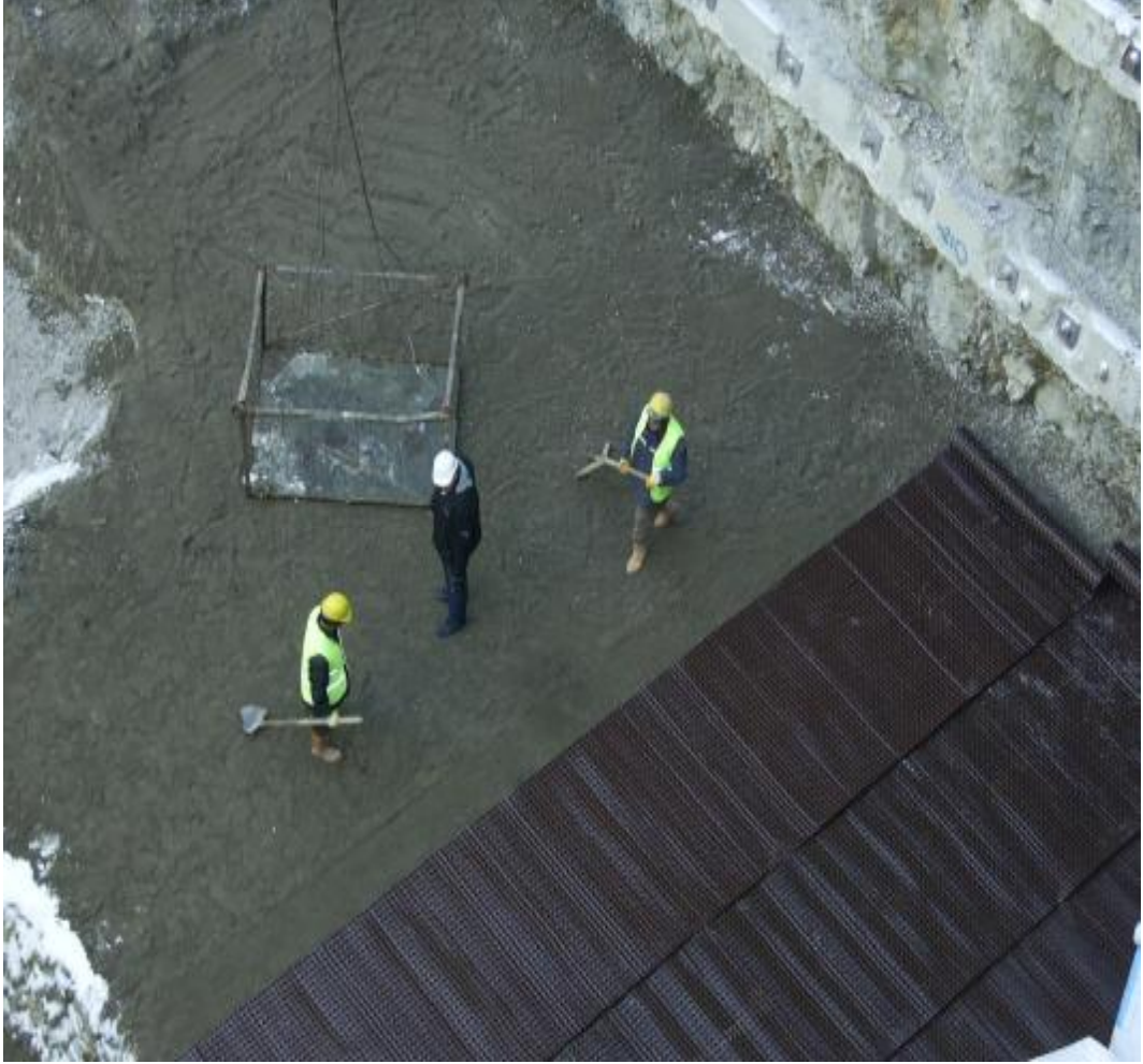
Şekil 4.4. Depo Temeline Yapılan Su ve Isı Yalıtımı
