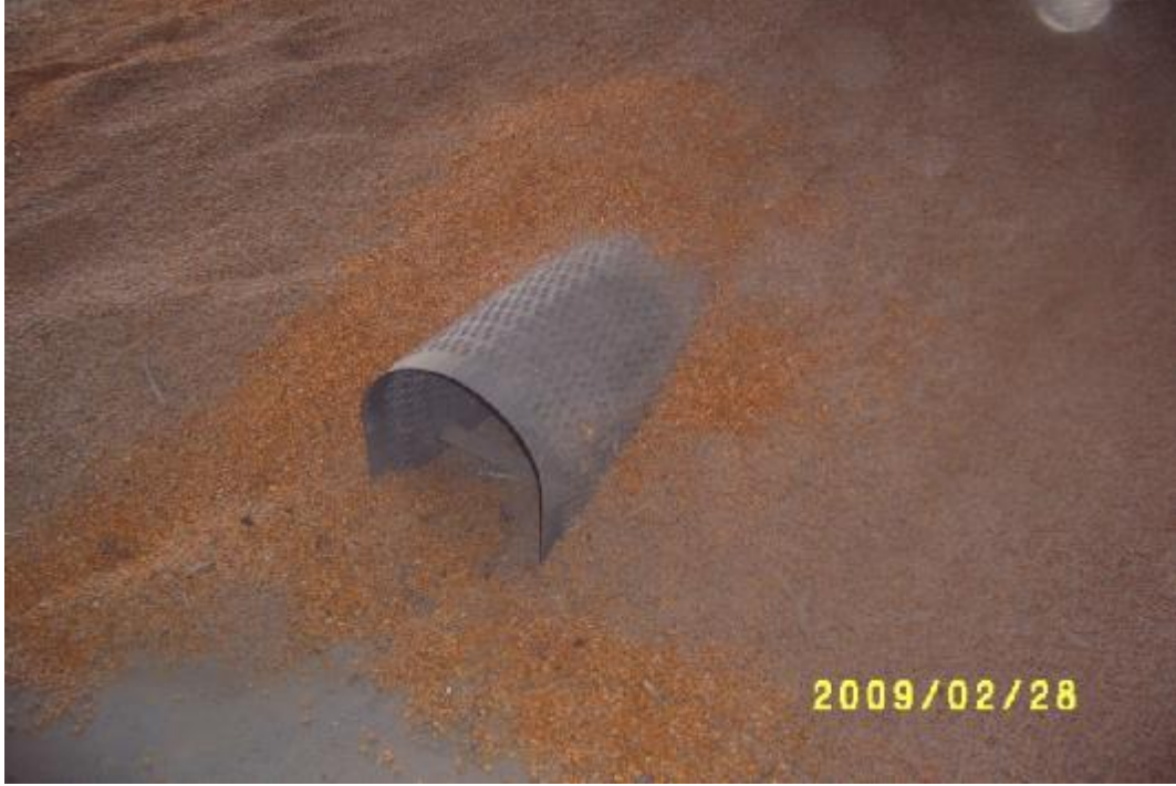
Şekil 3.7. 2. ve 3. Deponun Hububatı Havalandırma Sistemi
