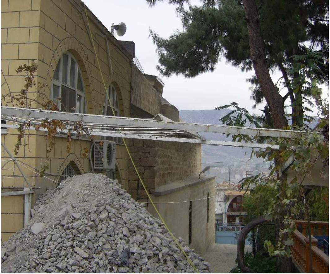
Ek 3: Yapının onarımdaki biçimi güneybatı cephesi
