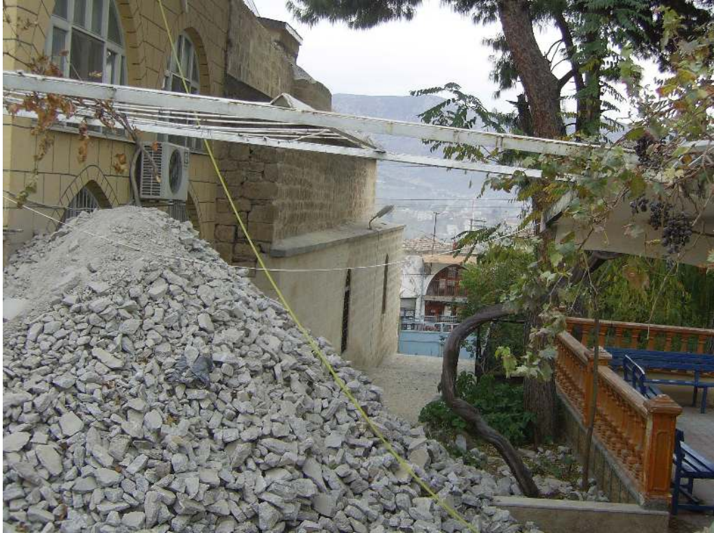
Ek 2: Yapının onarımdaki biçimi güneybatı cephesi
