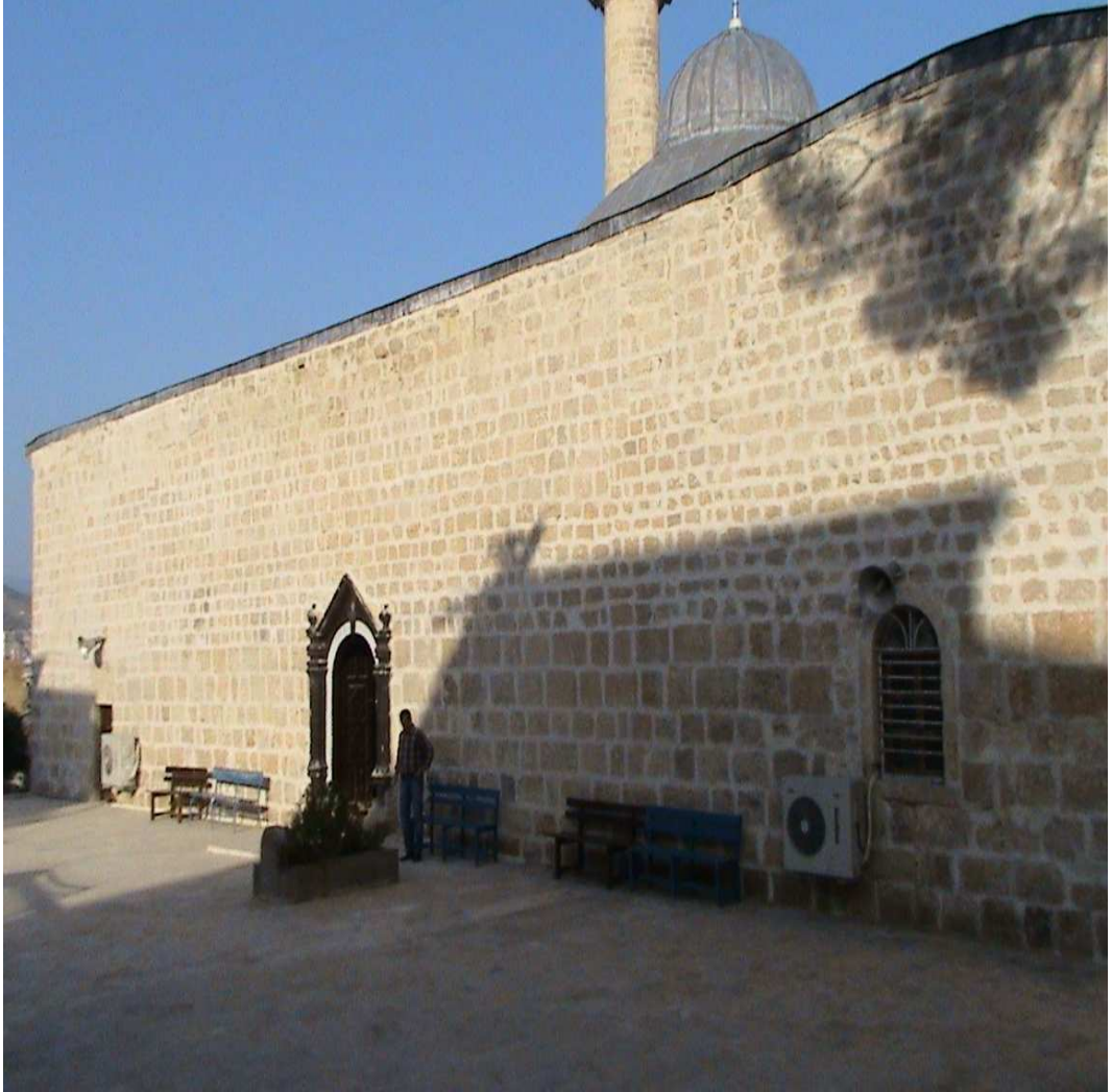
Ek 4: Yapının batı cephesi (üzerindeki ekleme kaldırıldıktan sonraki hali)
