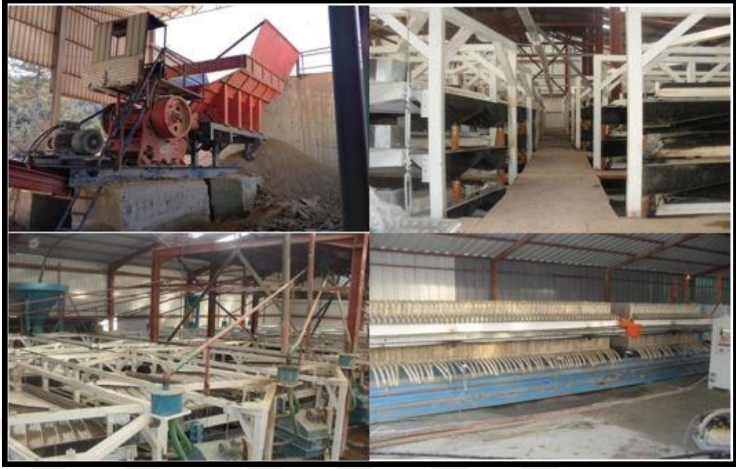
Şekil 4.53. Krom zenginleştirme tesisine ait görünüm.
