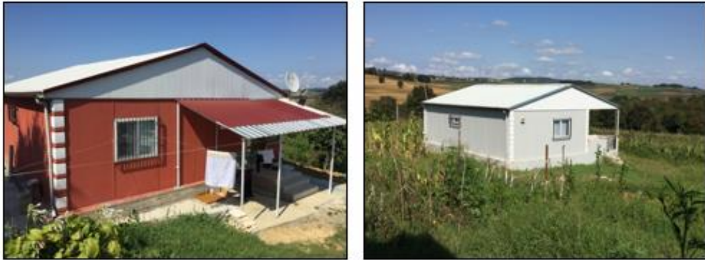
Resim 2.2. Işıklar köyü prefabrik yapı örnekleri
