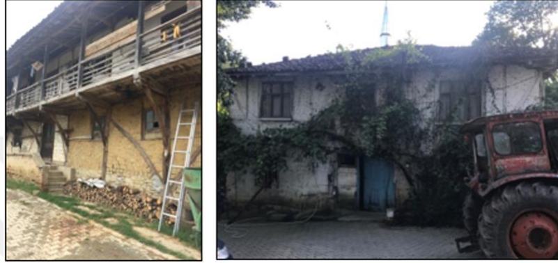
Resim 3.47. 14 numaralı yapı ahşap karkas kerpiç dolgu
