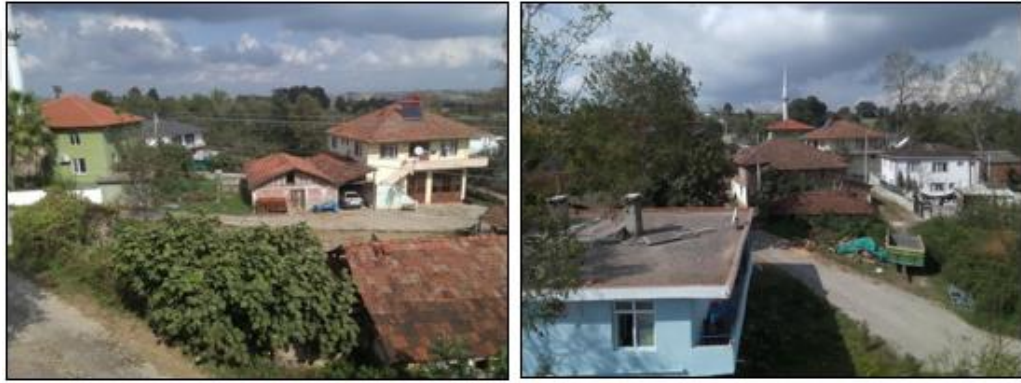
Resim 3.5. Işıklar köyü konut çatıları
