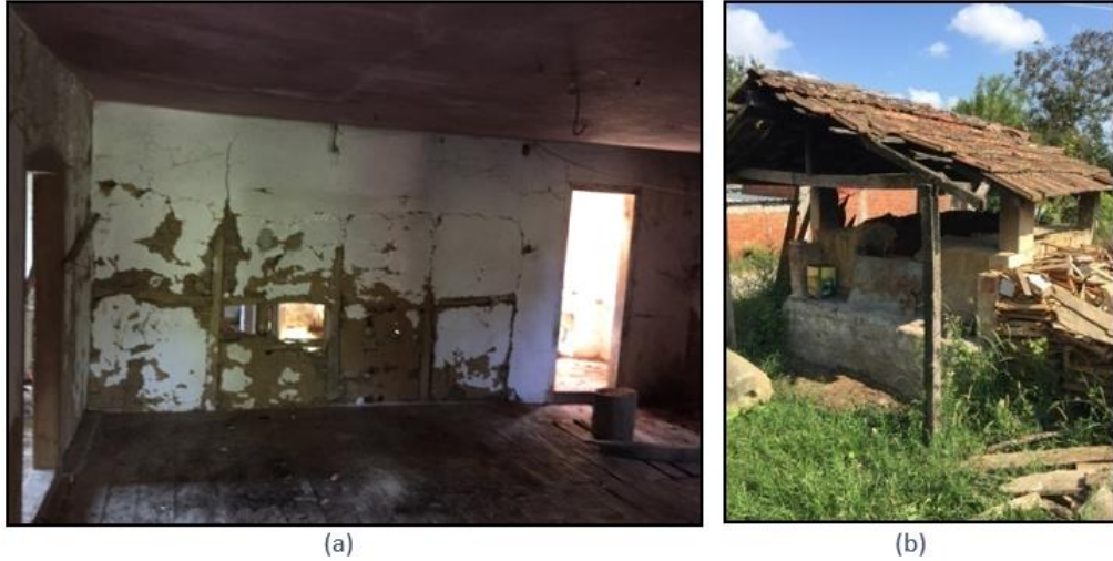
Resim 3.10. Işıklar köyü yapılarında bağlama harcı a) Konut, b) Fırın
