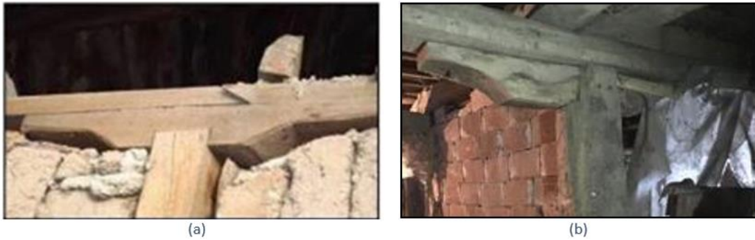
Resim 2.8. Konutların taşıyıcı sistem birleşim detayı a) Dursunbey, b) Ortaköy
