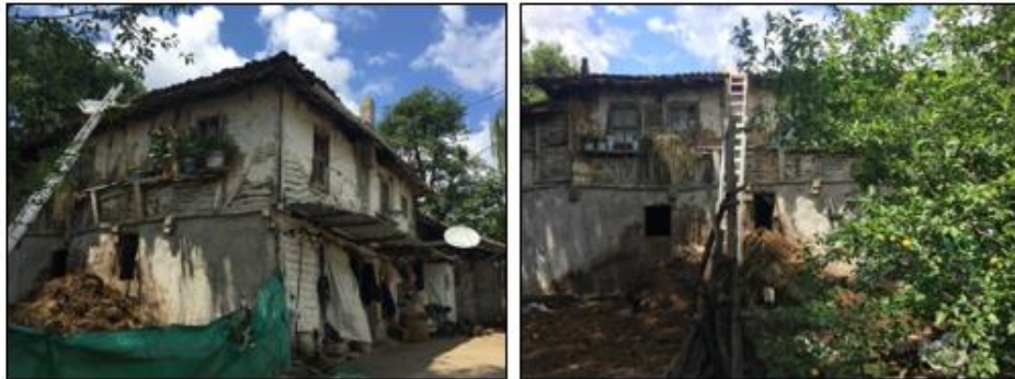
Resim 3.49. 13 numaralı yapı ahşap karkas ahşap dolgu
