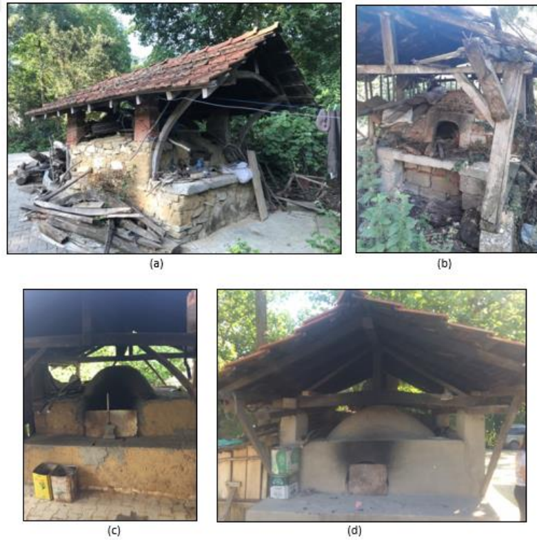
Resim 3.52. Fırınlar a) 14 numaralı yapı, b) 12 numaralı yapı, c) 6 numaralı yapı, d) 17 numaralı yapı
