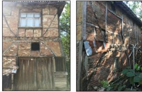
Resim 3.48. 16 numaralı yapı ahşap karkas tuğla dolgu
