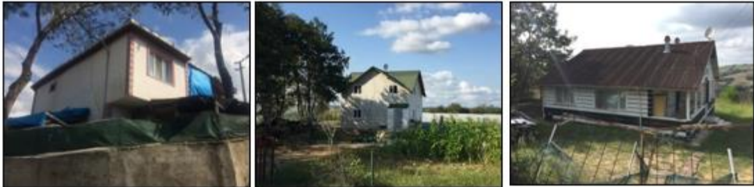
Resim 3.21. Yeni konutların bahçe duvarları ve çitleri
