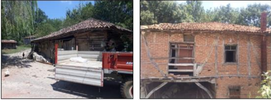
Resim 3.50. Ortaköy yapıları oluklu kiremit çatı örtüsü a) 10 numaralı yapı, b) 12 numaralı yapı
