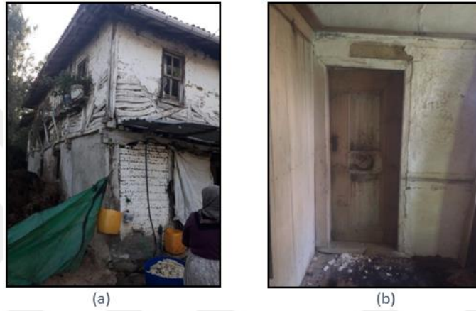
Resim 3.32. Ortaköy konut duvarı örnekleri a) 13 numaralı yapı dış cephe, b) 12 numaralı yapı iç cephe
