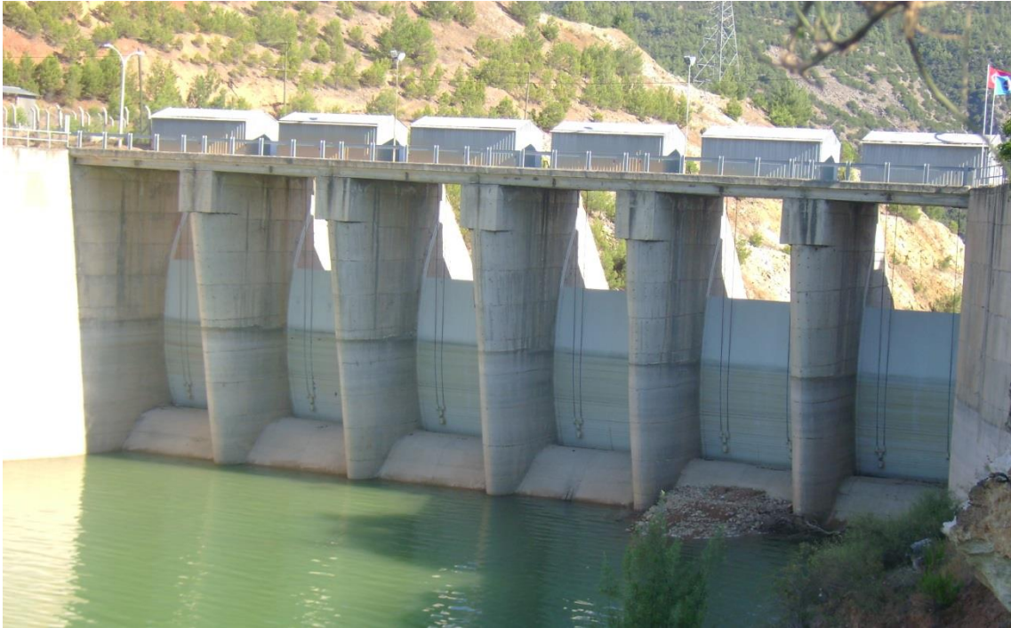
Resim 3.4. Adıgüzel HES' e ait dolu savak tesisleri
