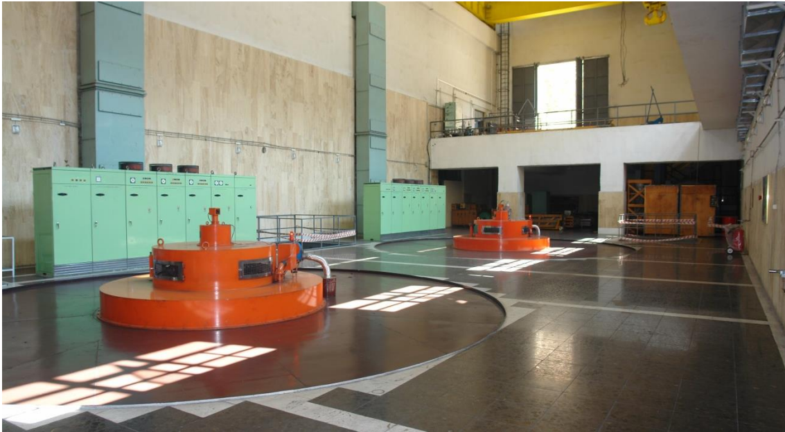
Resim 3.8. Adıgüzel HES' e ait senkron generatörler
