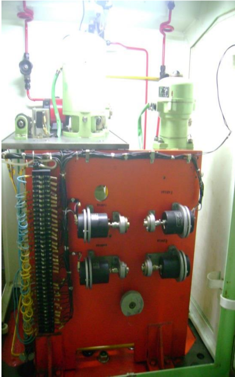
Resim 4.2. Hız regülatörünün mekanik ve hidrolik aksamı
