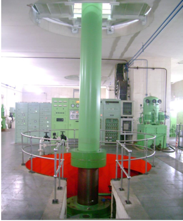
Resim 3.7. Adıgüzel HES' e ait türbin şaftı ve türbin çukuru
