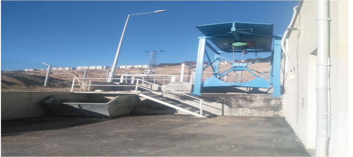
Şekil 5.3. Giriş pompa istasyonu ve kaba ızgara
