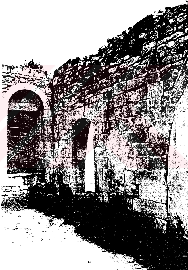
Şekil 4.45 Sofa 03 DV4 duvarı Oda 07 kapı girişi
