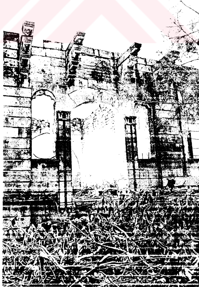
Şekil 4.16 Kuzey cephesi girişi ve "b" sınıfı pencere görünüşü
