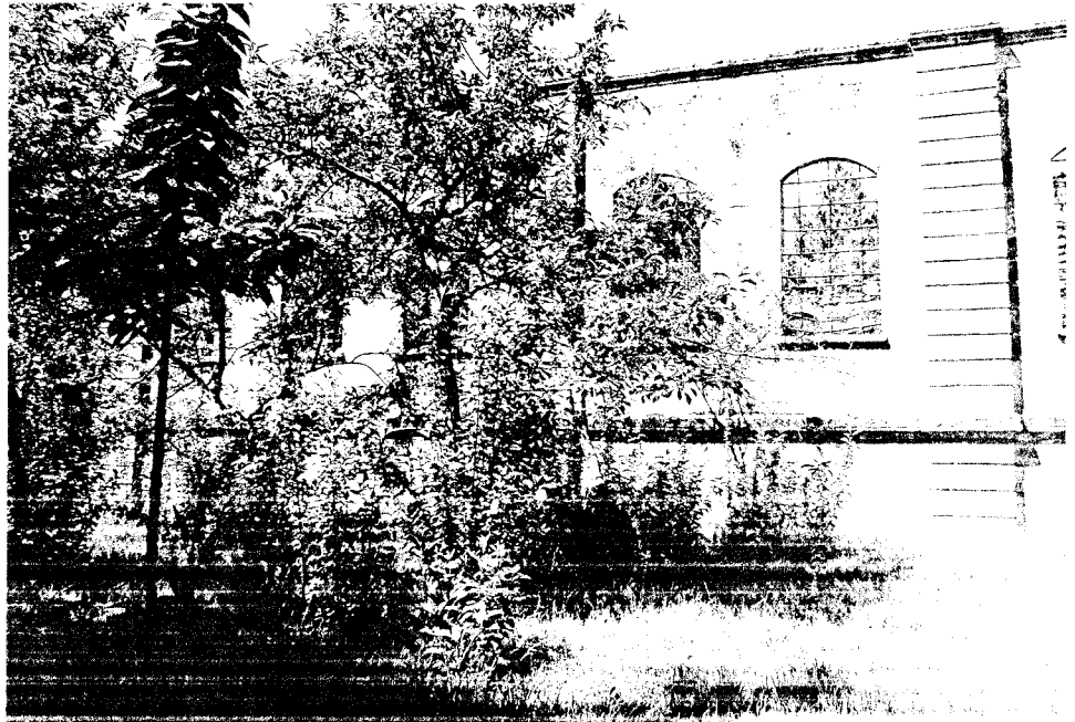
Şekil 4.24 Doğu cephesi görünüşü
