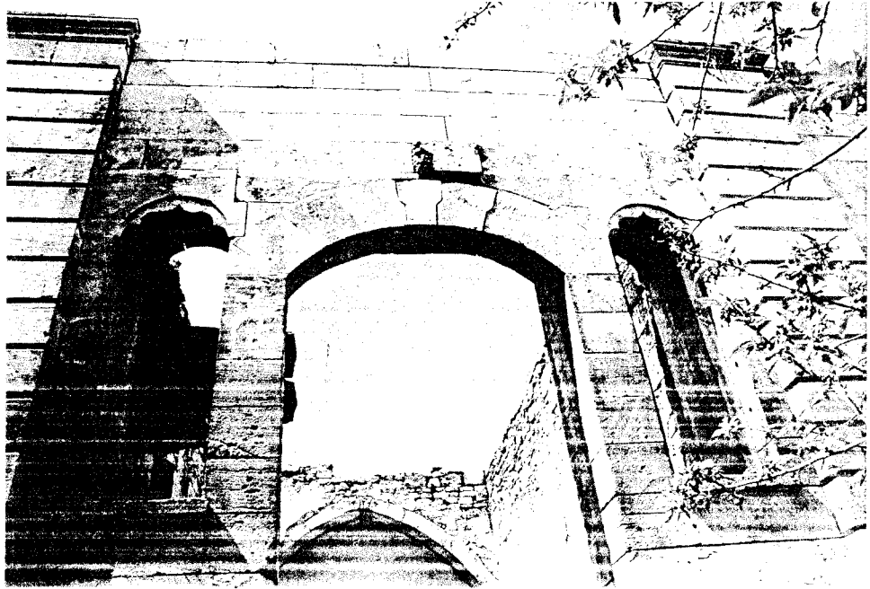
Şekil 4.26 Güney cephesi kapı girişi
