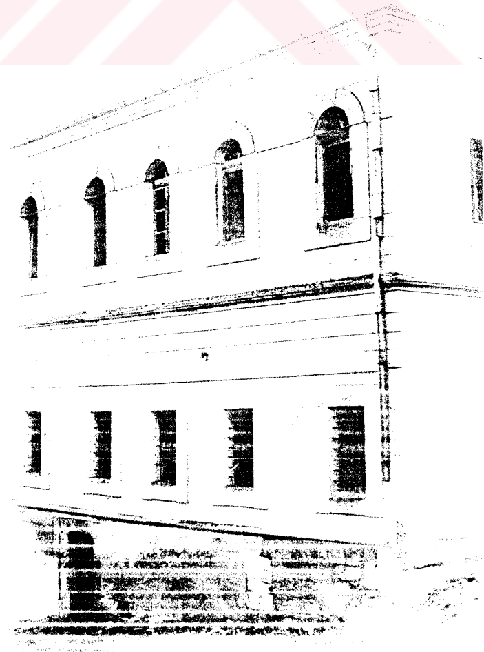
Şekil 5.10 Nevşehir-Ürgüp Askerlik Şube Binası yan cephedeki görünümü
