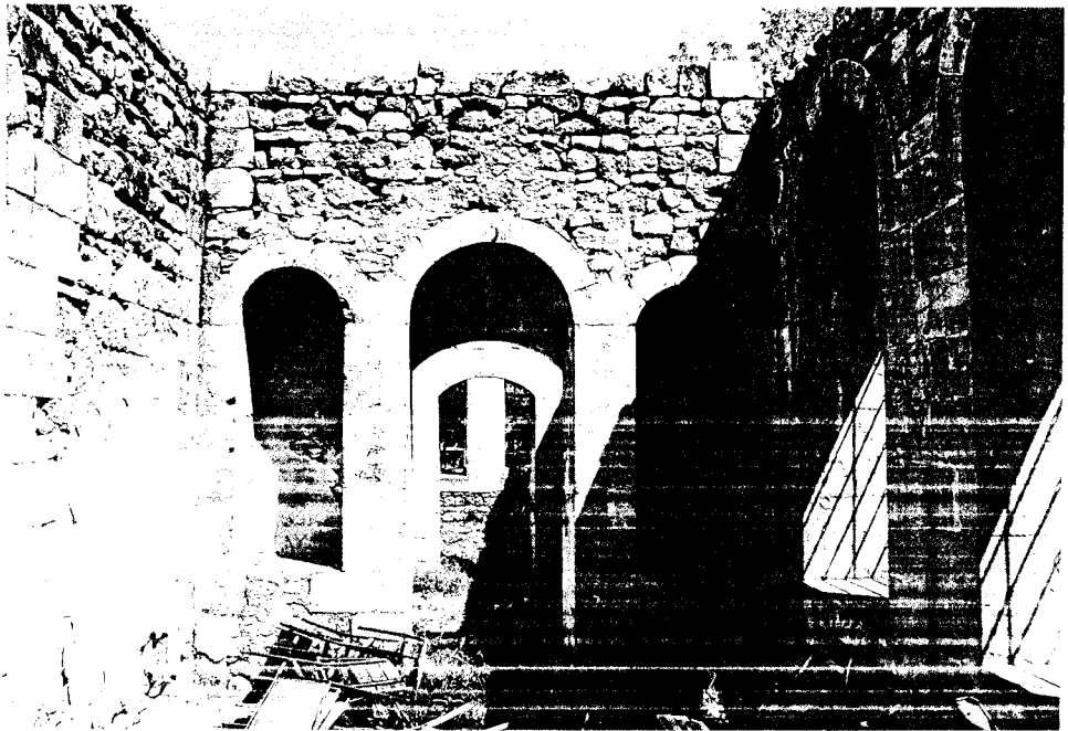
Şekil 4.51 Oda 04 DV4 duvarı
