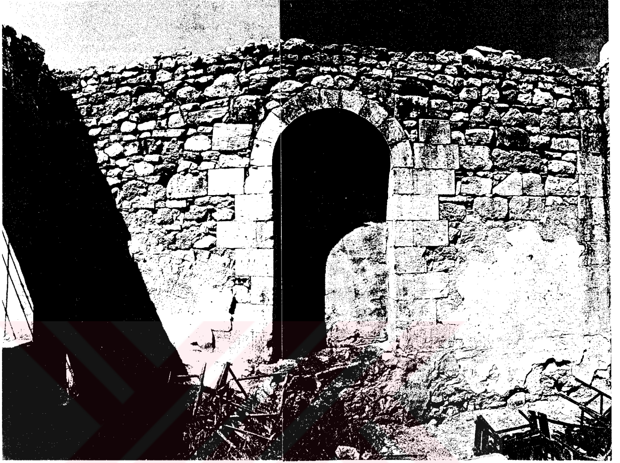
Şekil 4.50 Oda 04 DV3 duvarı
