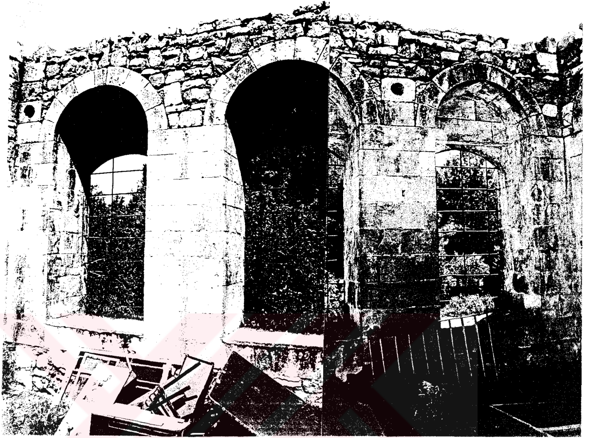
Şekil 4.48 Oda 04 DV1 duvarı
