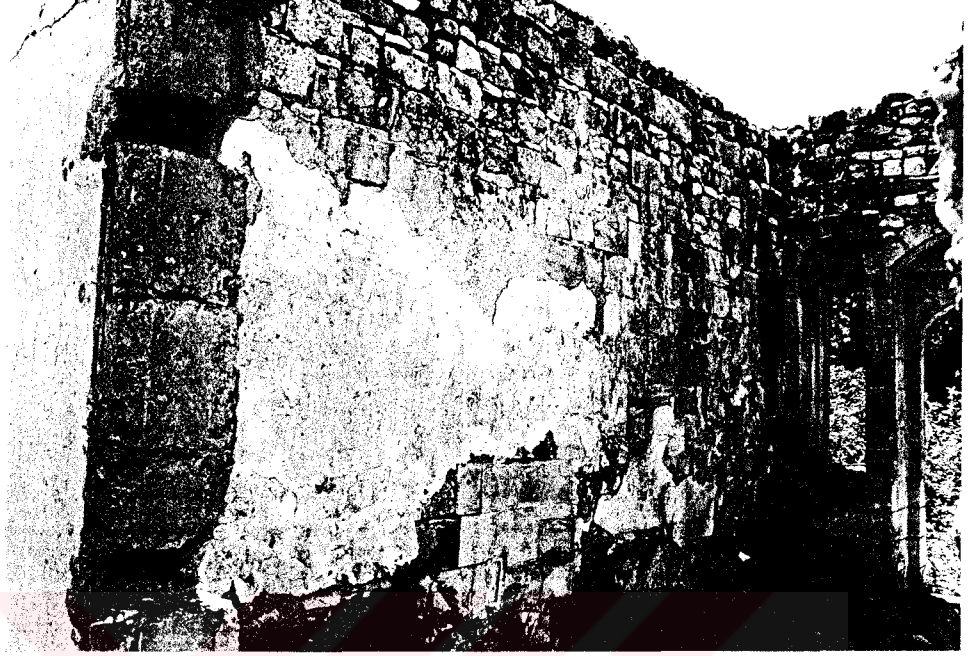
Şekil 4.52 Eyvan 05 DV1 duvarı
