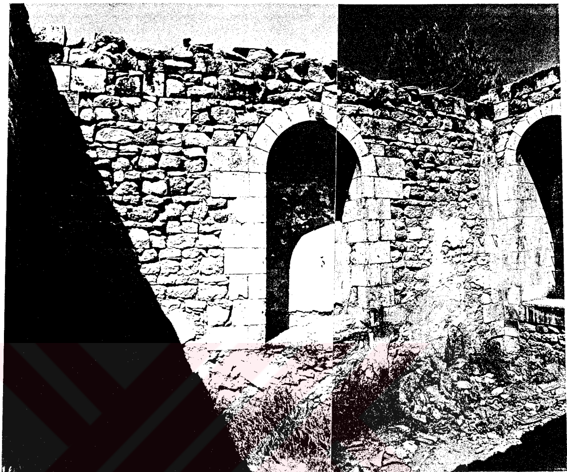
Şekil 4.38 Oda 02 DV3 duvarı
