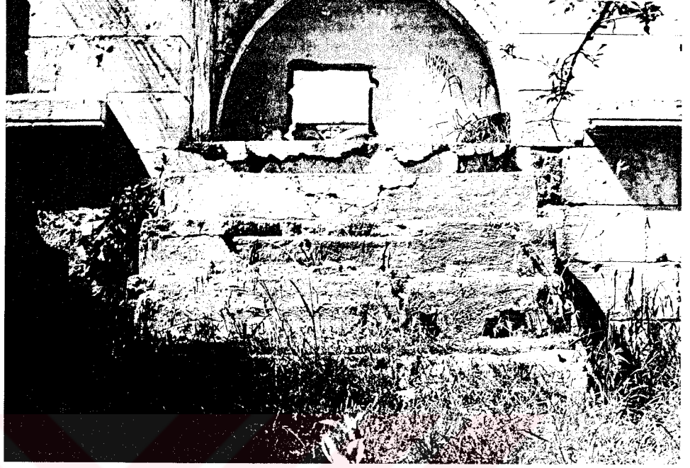
Şekil 4.28 Güney cephesi merdiveni
