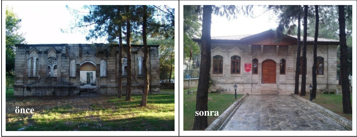
Şekil 4.21. Eski askerlik binası restorasyon öncesi ve sonrası
