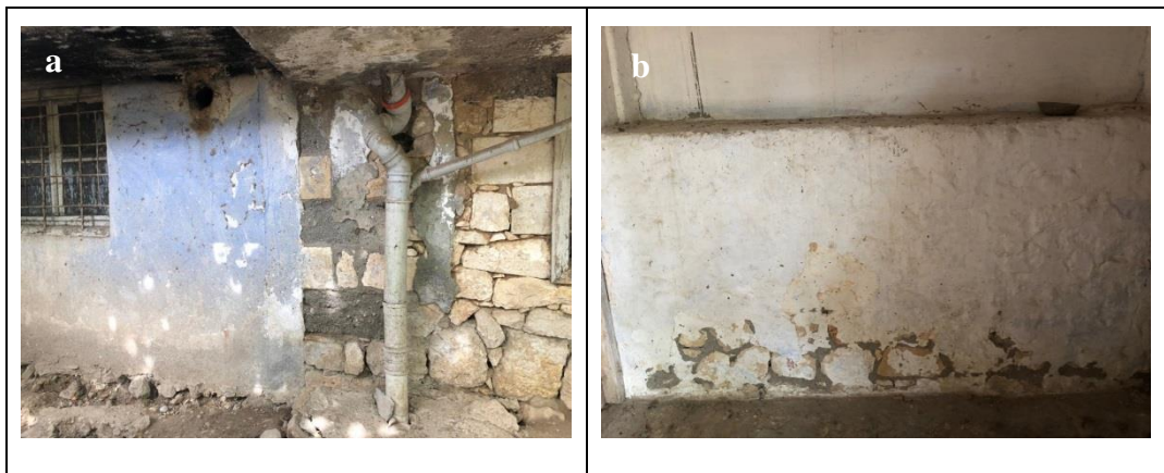
Şekil 4.86. a: Batı cephesi B04 mekânına ait dış duvar görünümü; b: B02 mekânı iç duvar görünümü
