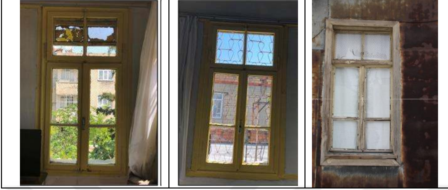
Şekil 4.95. Halil Bilgiç Evi’nde bulunan birinci kat pencereleri
