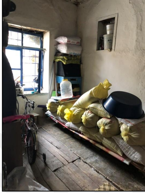
Şekil 4.49. Halil Bilgiç Evi ahşap zemin
