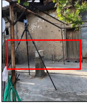
Şekil 4.130. Birinci kat briket duvar izleri
