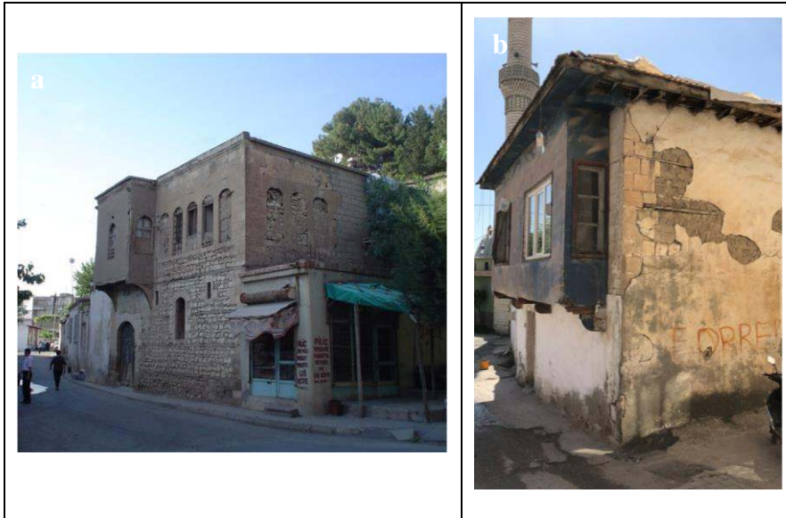
Şekil 4.40. Cumba örneği (a: Restorasyon öncesi Şaziye Keleş Evi; b: Günümüze ulaşan bir örnek)
