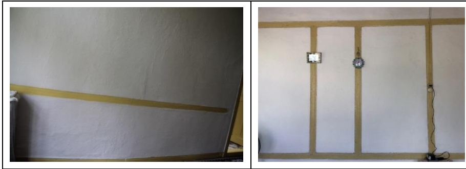
Şekil 4.88. Birinci kat iç duvar
