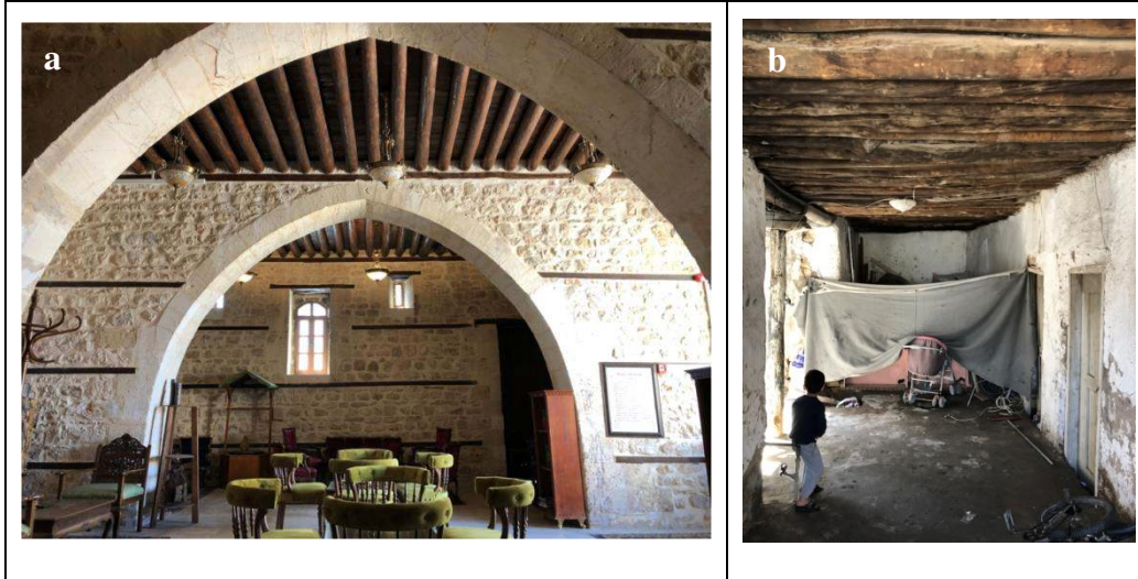
Şekil 4.50. a: Şaziye Keleş Evi restorasyon sonrası ahşap kirişlemeli tavan; b: Kale çevresinde bulunan sahibi bilinmeyen evden ahşap kirişlemeli tavan örneği
