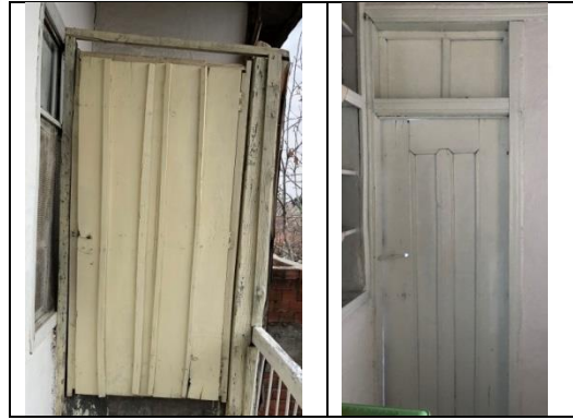
Şekil 4.93. Halil Bilgiç Evi birinci kat tuvalet ve banyo kapısı
