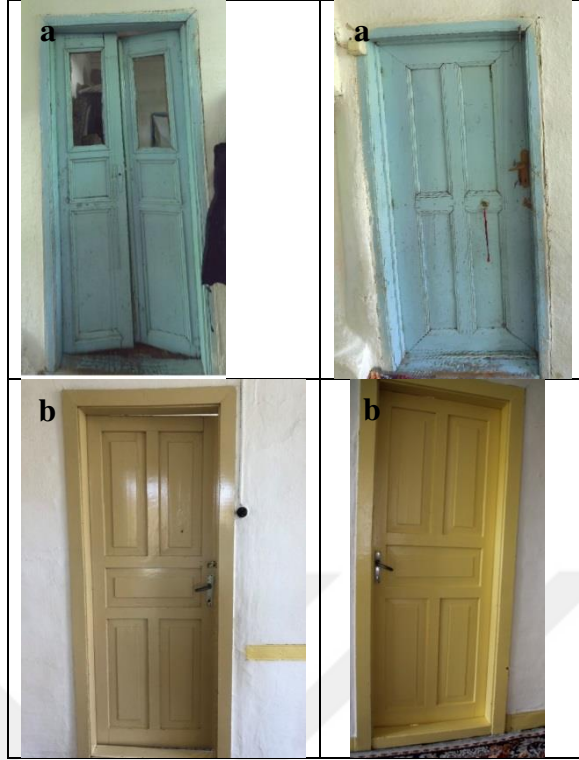
Şekil 4.92. a: Halil Bilgiç Evi zemin katta bulunan iç mekân kapıları; b: Halil Bilgiç Evi birinci katta bulunan iç mekân kapıları
