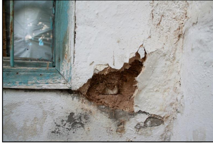
Şekil 4.128. Batı cephesi duvarındaki kalker taşı
