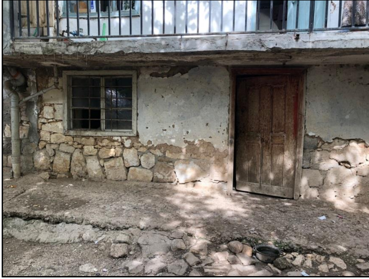
Şekil 4.63. B02 mekânı giriş kapısı ve B03 mekânı cephe penceresi
