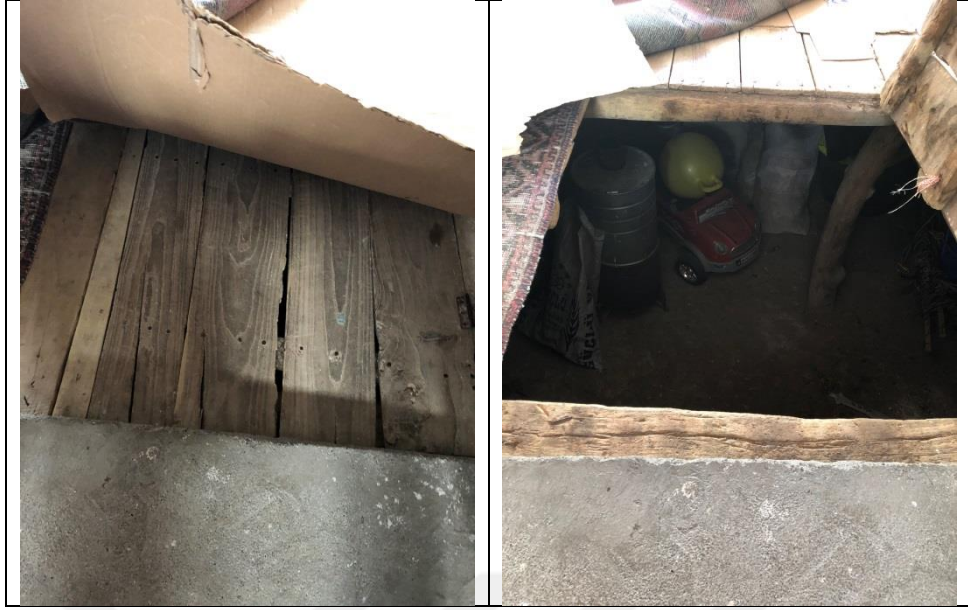
Şekil 4.85. Ahşapla kapatılmış havuz boşluğu
