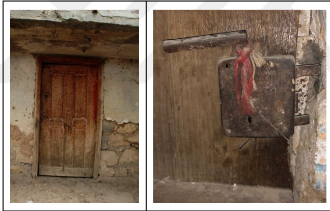
Şekil 4.90. Halil Bilgiç Evi bodrum kat giriş kapısı ve kilit sistemi
