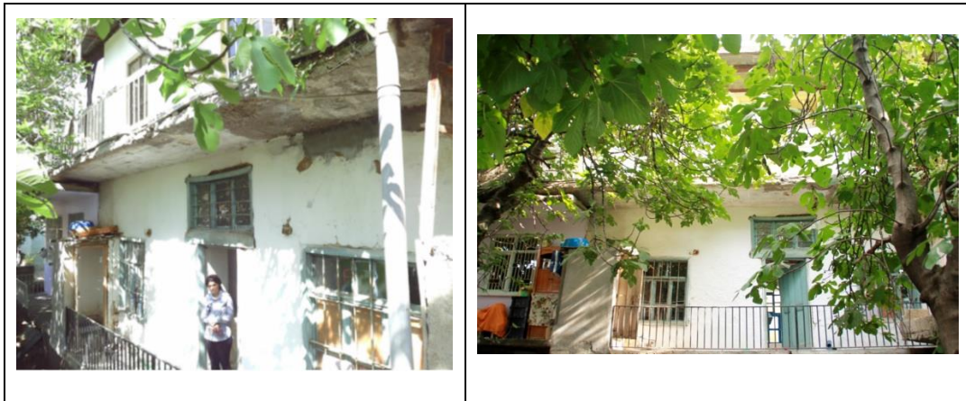
Şekil 4.83. Halil Bilgiç Evi batı cephesi
