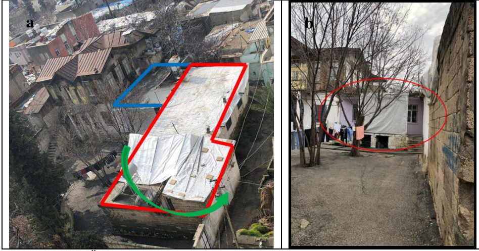
Şekil 4.114. a: Özgün mimariye aykırı müdahale örneği; b: Betonarme eklenti konutun avludan görünümü
