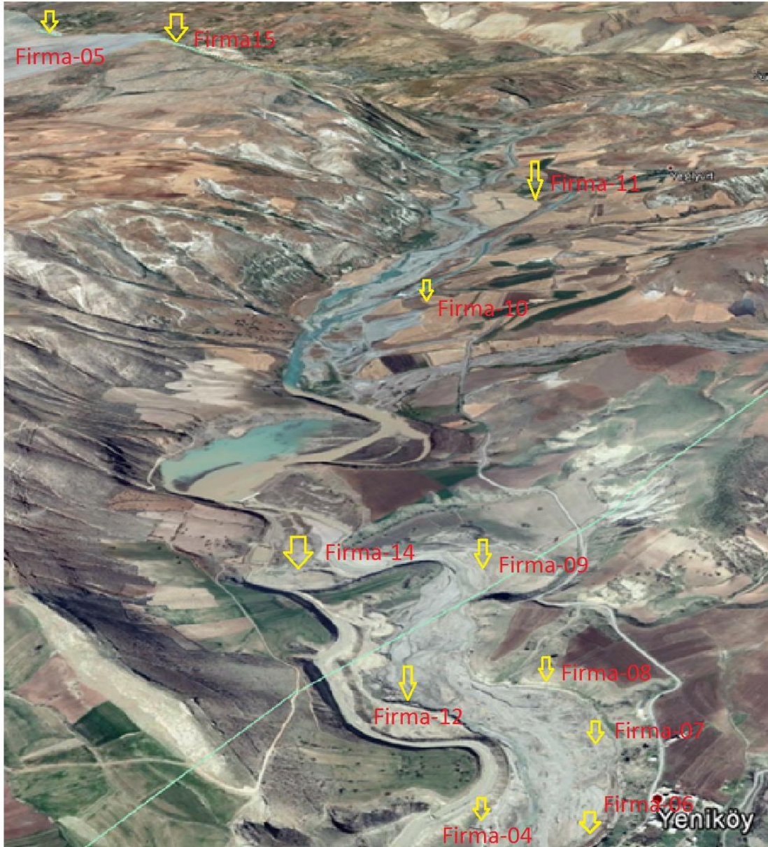
Şekil 4.1 Göksu çayı boyunca bulunan kum-çakıl kırma-eleme-yıkama tesisleri [51]
