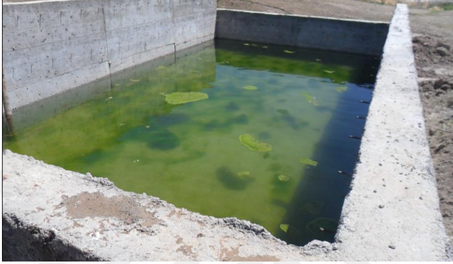
Resim 4.4 Firma02 çöktürme havuzu görüntüsü
