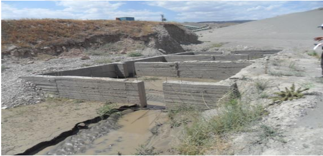
Resim 4.3 Firma02 çökeltim havuzu görüntüsü
