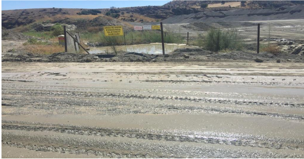
Resim 4.12 Firma06 çöktürme havuzu görüntüsü
