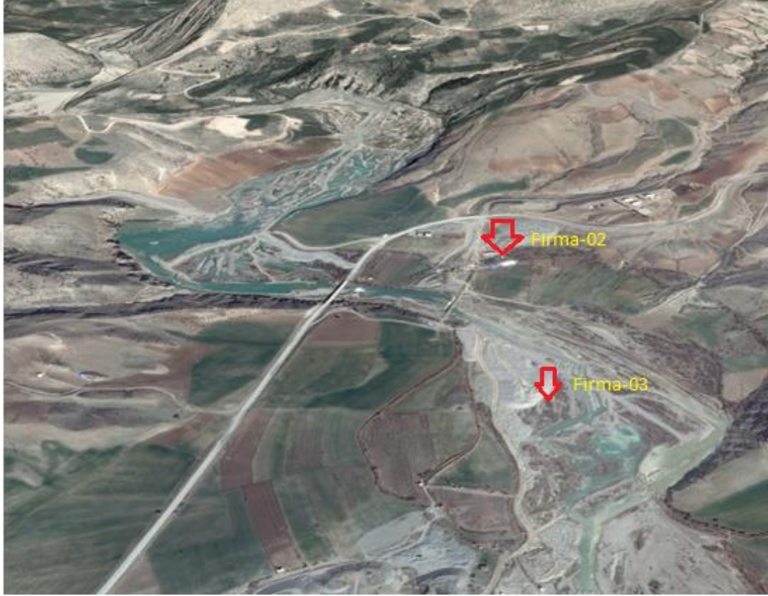
Şekil 4.2 Kâhta çayı boyunca bulunan kum-çakıl kırma-eleme-yıkama tesisleri [51]
