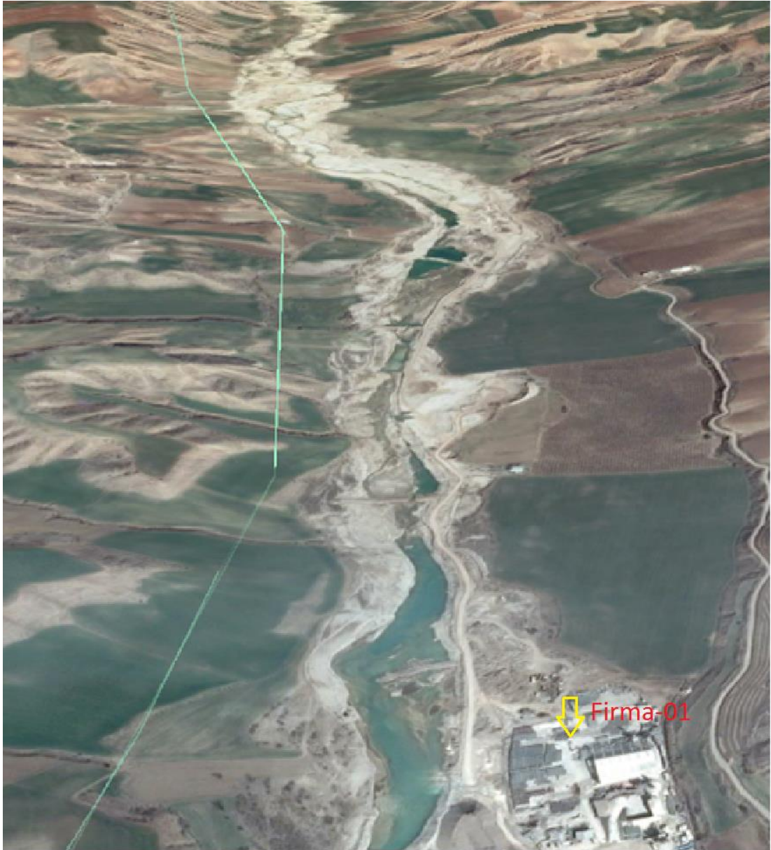
Şekil 4.3 Kalburcu çayı boyunca bulunan kum-çakıl kırma-eleme-yıkama tesisleri [51]
