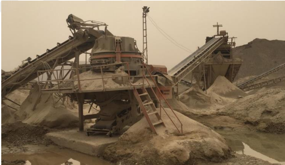
Resim 4.21 Firma10 konkasör tesisi görüntüsü
