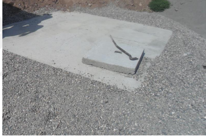
Resim 1.1 Fosseptik çukuru üst görünüşü
