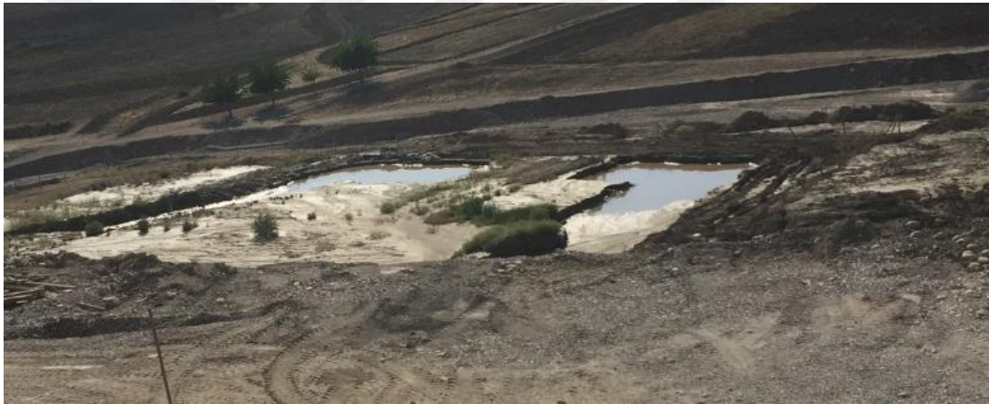
Resim 4.32 Firma13 doğal çöktürme havuzu
