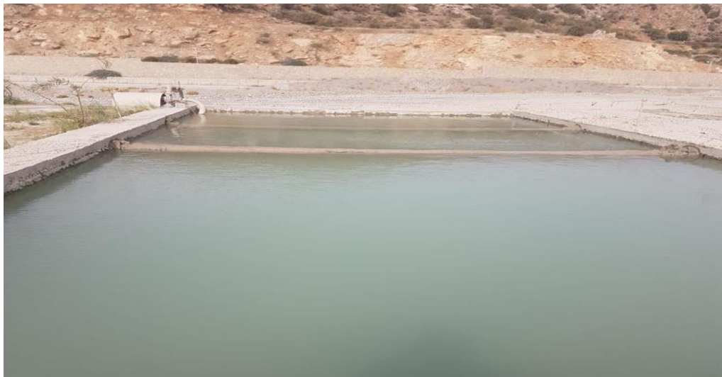
Resim 4.35 Firma15 çöktürme havuzu
