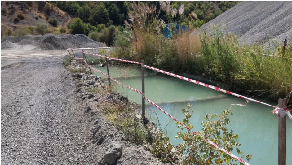
Resim 4.8 Firma05 çöktürme havuzu görüntüsü
