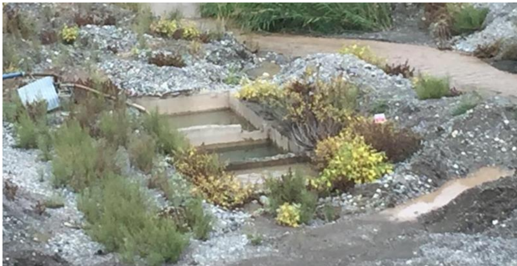
Resim 4.24 Firma11 çöktürme havuzu
