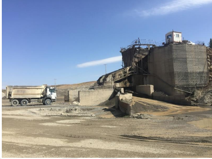
Resim 4.17 Firma08 yıkama-eleme tesisi görüntüsü
