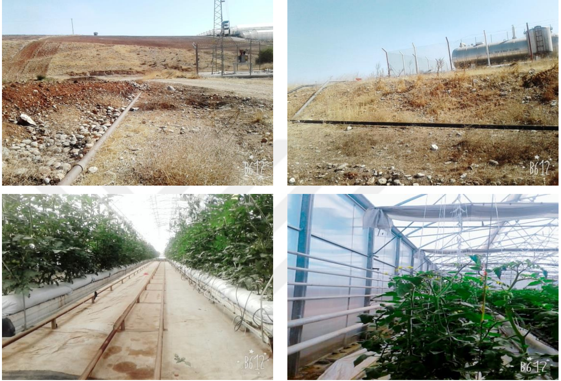
Şekil 4.64. Sıcak suyun seralara iletilmesi ve seraların ısıtılması
